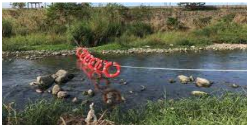
圖 2 於湍流區作業場所下游處設置之攔截索
