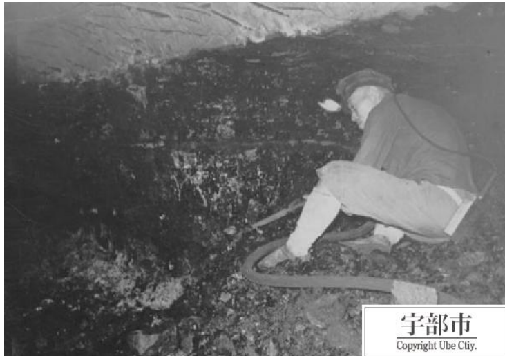
圖六 「松浜炭鉱の薄層採炭」情形（照片：宇部市圖書館附設資料館提供）
