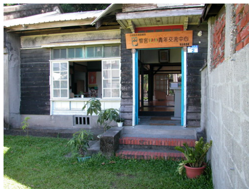
歷史建築右側正面及階梯
