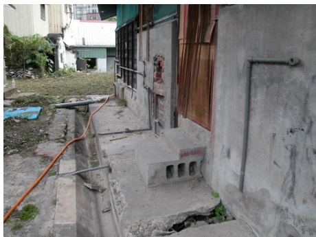
左側牆面並已無煙囪
