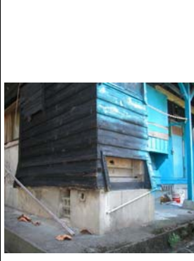
建築後側一角
