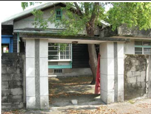
歷史建築右側正面及門口
