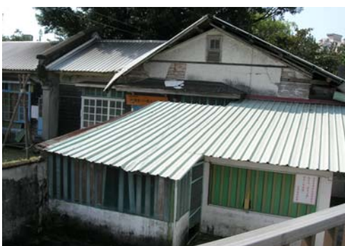
正立面、山牆及加建的違章建築
