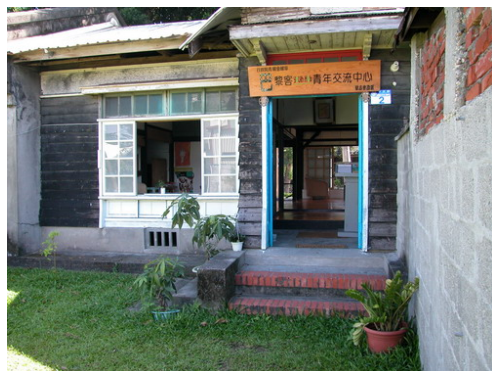
歷史建築右側正面及階梯
