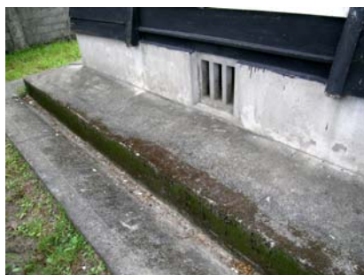
排水溝與通風口
