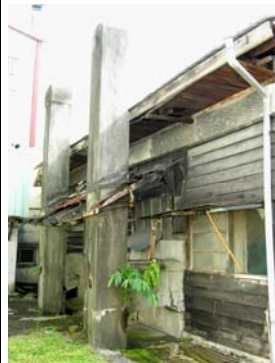
水泥磚造煙囪
