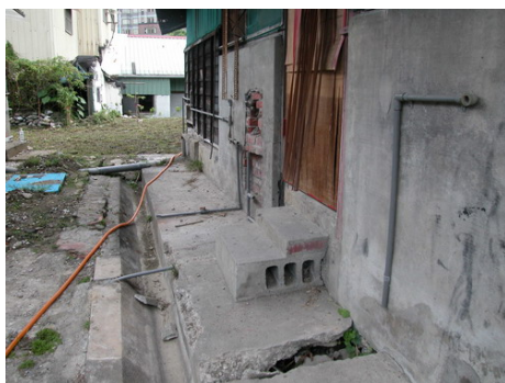
左側牆面並已無煙囪
