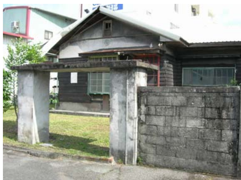
歷史建築左側門口及圍牆
