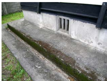
排水溝與通風口
