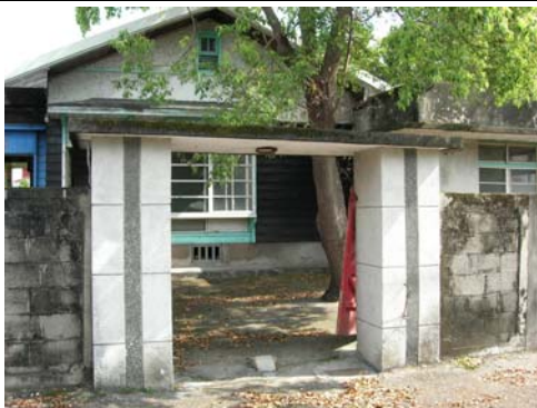
歷史建築右側正面及門口
