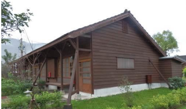
【照片 3-3-38】已整修的旅館外牆,已改為洋風下見板張。
