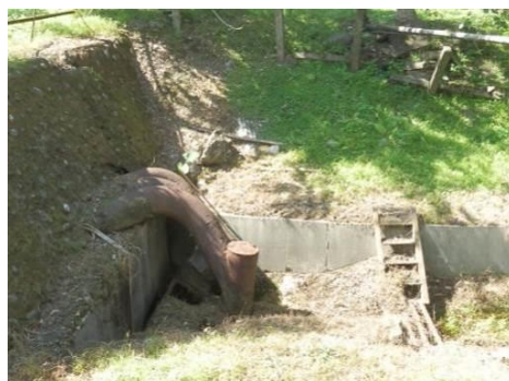
【照片 4-4-8】水路水管化
