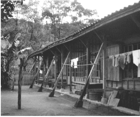
【照片 3-3- 40】舊連棟宿舍斜撐舊照
