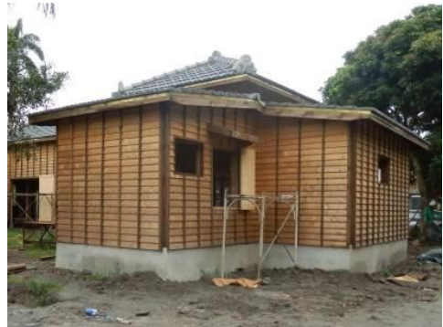
【照片 3-3-39】整修中的旅館外牆,洋間外牆已改為簾子押緣下見板張。
