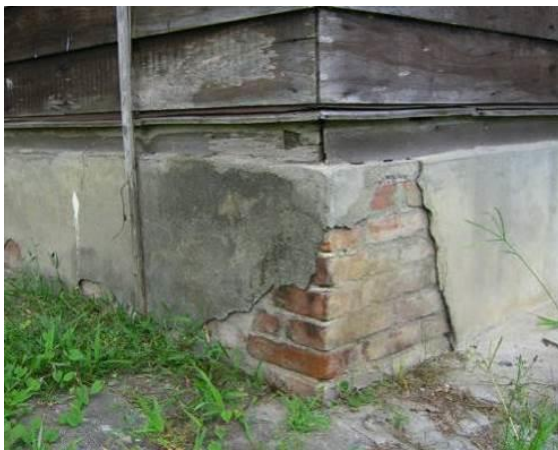
【照片 3-3-29】基礎磚造部分外露
