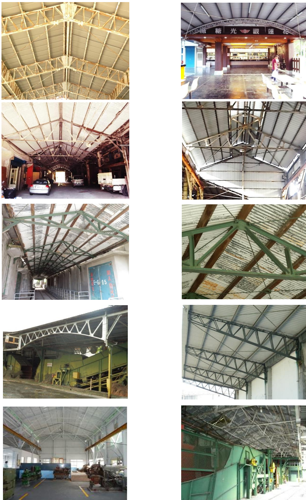
【照片 3-3- 108】本區常見桁架型式組圖
