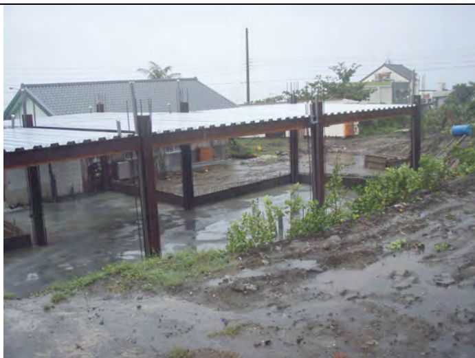
大坑53號後方新建建築
