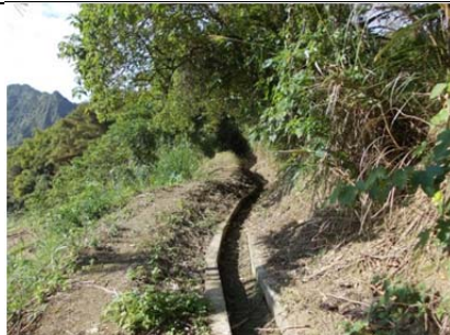
018 圳路 0k660 混凝土內面工
