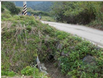
023 圳路 0k811 混凝土農路暗渠
