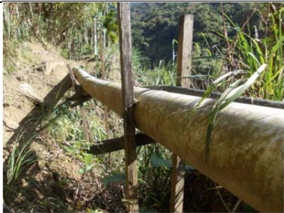
017 圳路 0k638 塑膠管渡槽
