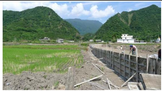
照片 6 豐南村活動中心興建中之鋼筋混凝土內面工
