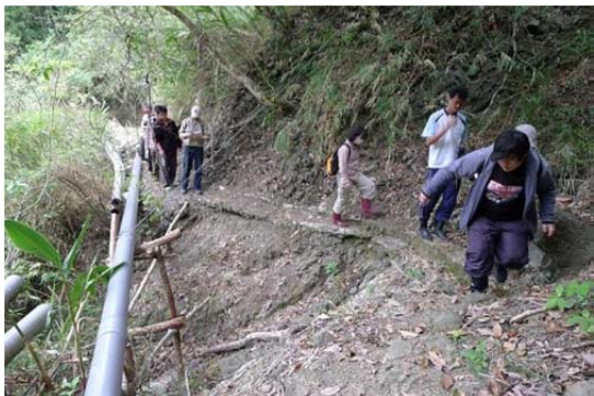
照片 13 第一號 (Urayama) 水圳之塑膠管渡槽
