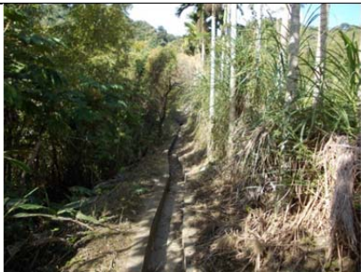
020 圳路 0k690 混凝土內面工
