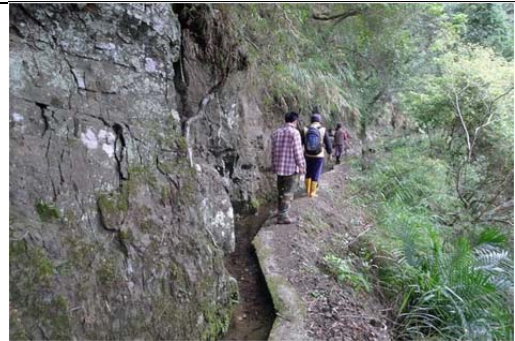
照片 2 第一號 (Urayama) 水圳之混凝土內面工
