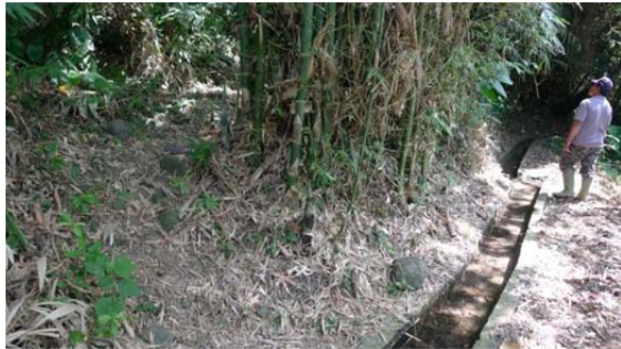
照片 3 第二號 (Cikimay) 水圳之混凝土內面工
