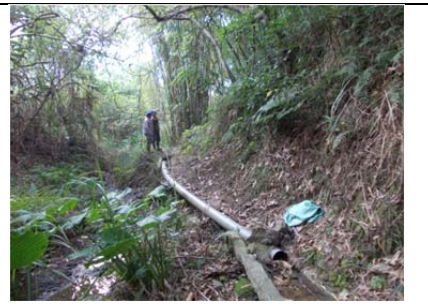
025 圳路 0k947 塑膠簾渡槽
