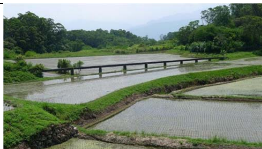
照片 12 羅山村泥火山旁之鋼筋混凝土渡槽
