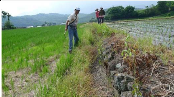
照片 5 豐南村活動中心旁之乾砌塊石內面工
