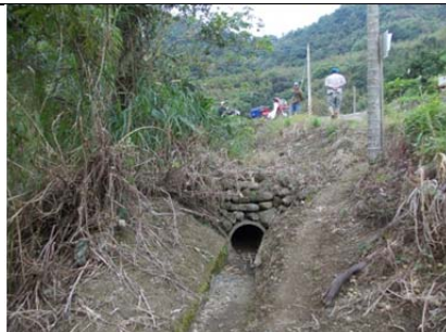
021 圳路 0k780 混凝土土管暗渠
