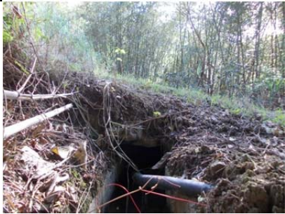
014 圳路 0k535 混凝土農路暗渠
