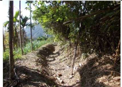
016 圳路 0k615 土渠
