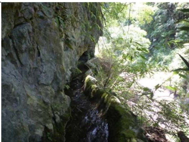
照片 64 2011/08/06 第三次豐南水圳踏查與 施工方法：第二號水圳沿石壁開鑿水圳
