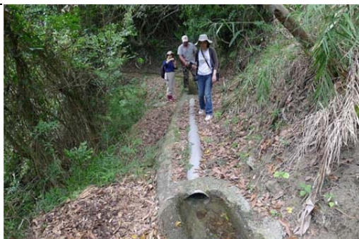
照片 17 豐南村第一號 (Urayama) 水圳之塑膠管暗渠
