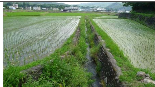
照片 10 豐南村活動中心旁之混凝土砌塊石內面工
