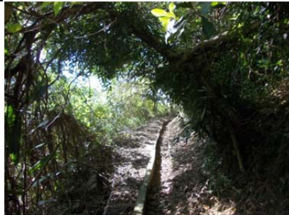
015 圳路 0k590 混凝土內面工
