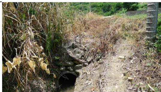
照片 18 豐南村第二號 (Cikimay) 水圳圳尾附近之混凝土管暗渠
