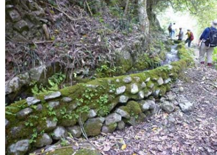
照片 8 第一號 (Urayama) 水圳之混凝土砌塊石內面工
