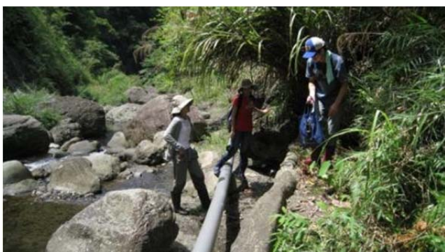
照片 66 2011/08/06 第三次豐南水圳踏查與 施工方法：第二號水圳原取水口因有 落石阻塞，圳道已呈廢棄狀態，並改 以塑膠水管延伸至上游取水
