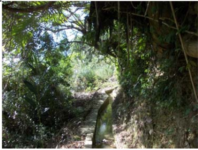
011 圳路 0k450 混凝土內面工
