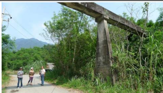
照片 11 跨越永豐村復興產業道路的鋼筋混凝土渡槽
