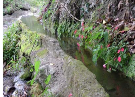
照片 4 第四號水圳之混凝土內面工
