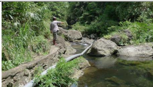
照片 9 第二號 (Cikimay) 水圳之混凝土砌塊石內面工及取水口原址
