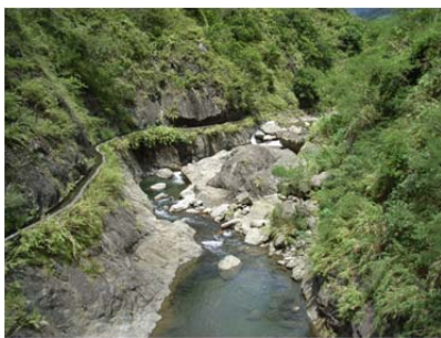
照片 7 石門圳之斷層切割工法與外側之混凝土砌塊石內面工
