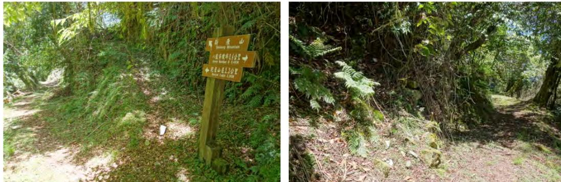
沙敦平台雖小但駁坎作工依然精細，平台邊緣築有小規模的駁坎矮牆（左圖），而駐在所駁坎從越道起至平台也有近 5 公尺高（右圖），是處小而美的駐在所。
