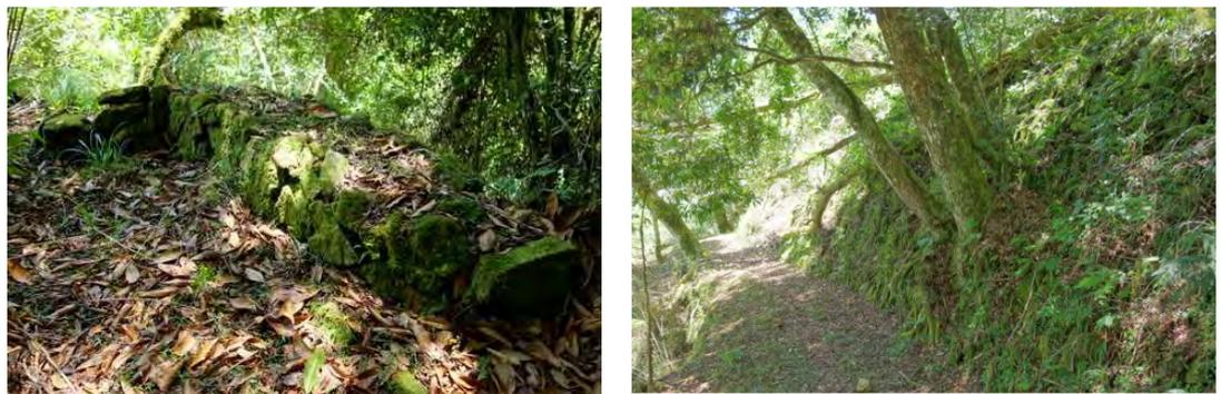
坡道入口因倒木橫陳不易穿過，而倒木也壓毀平台一角的護牆與駁坎牆。1999 年因改建 8 號橋所需曾闢建為工寮，階梯上的大量近代垃圾應為當時遺留。
