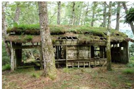
曾經倒塌在砲庫屋頂上的倒木已清除（左圖），但似乎已影響屋頂結構，目前已有多處大小不一的破洞（右圖），整體結構似也不若以往穩固。
