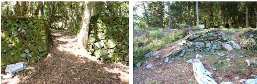
每層平台間皆有駁坎牆，上、中層間之駁坎牆最具規模，以塊石砌成的三公尺高駁坎牆具有壯闊的美感（左上圖），但東南面的駁坎牆因倒木等因素導致大幅崩毀（右上圖），西北處也有小規模崩塌情形（左下圖）。中、下層間的駁坎牆則幾近全毀，僅有幾處駁坎尚堪完好（右下圖）。上、中層平台遍生高大喬木，林相優美舒適，中、下層平台交接處與下層平台則多為草地。
