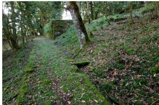
位於北側門旁的駁坎牆已傾斜的十分嚴重，研判為駁坎上方的樹木根系生長（左圖），重量並導致下方越道路面塌陷（右圖），目前已有部分石版掉落造成駁坎牆出現缺口
