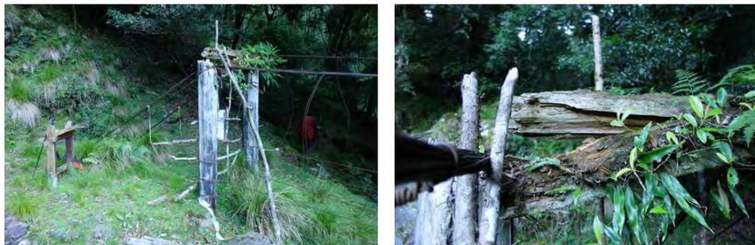
東側橋門的狀況目前仍算完好，但橫樑目前也已有腐朽情況（下圖）。
