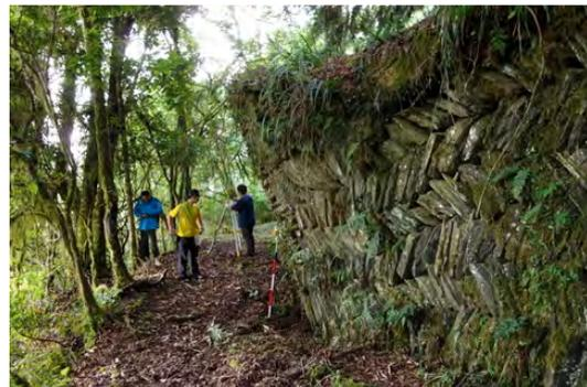
位於南側門旁的護牆因生長其上的樹木倒塌，造成約有 50 公分長駁坎倒塌（左圖），北側門旁的護牆亦因樹木生長出現傾斜狀況（右圖）
