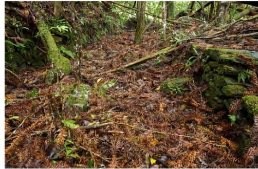
石砌階梯被步道路線斜穿而過（左圖），但多數結構仍還完整（右圖）。階梯最寬達 1.9m，步道上至平台處共有 13 階，步道下方至古道處則有 35 階。
