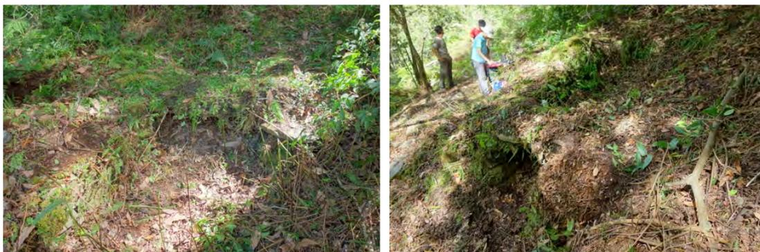
平台與越道間的階梯已因土石滑落、植被生長等因素而難以通行，入口處並錯置為「電話桿」解說牌（左圖）。此處曾作為直昇機吊掛場而砍除駁坎上方的樹木，樹木倒塌後壓毀下方駁坎，並導致前方越道不易通行（右圖）。此地為玉管處進行東段步道整修工程中，受到最嚴重破壞的駐在所。
