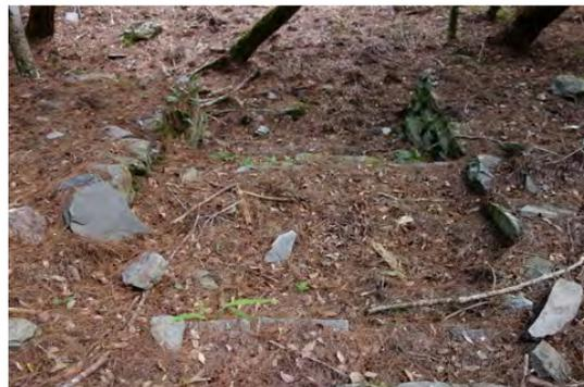
平台被明顯的駁坎牆區隔成兩塊，北側並以一小階梯與下方的小平台相通，不過許多駁坎牆都遭山豬破壞而傾倒損毀（左圖）。越道與平台間的斜坡以階梯為中心，兩側各建置一道駁坎牆，東側已因倒木、土石滑落等因素而損毀（右圖）。
