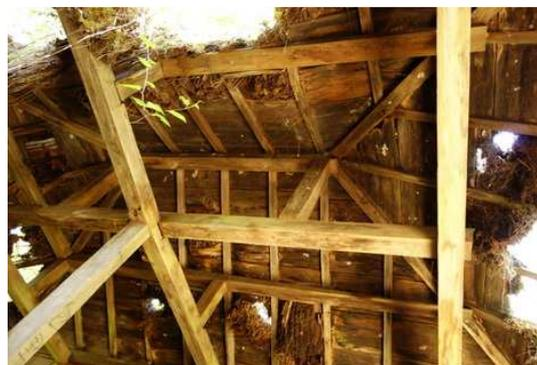
辦公室的保存狀況尚屬良好，但多處接榫已脫開（左圖），顯示整體結構漸趨不穩，辦公室入口目前也已呈傾斜狀態（右圖）。
