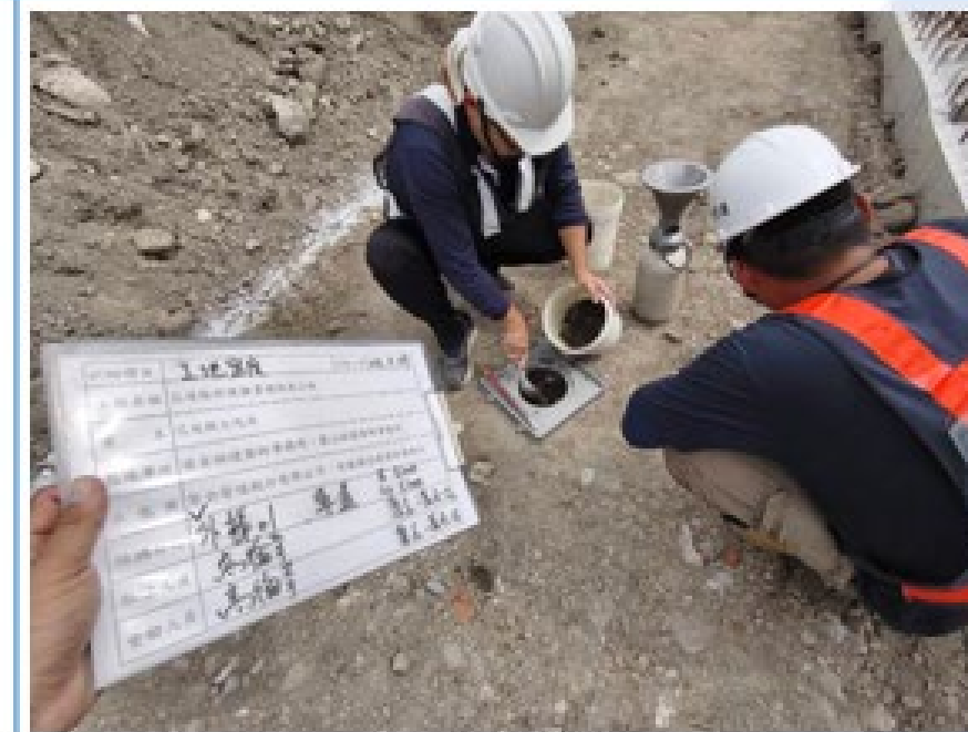
113.05.29 工地密度-東側外梯、車道
