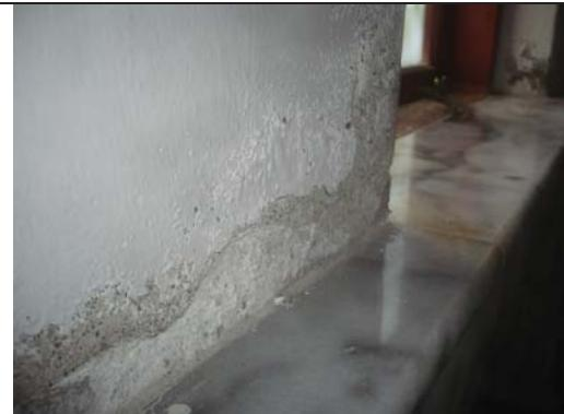
照片 5-49 牆面產生白華，導致水泥砂漿粉刷層剝落
