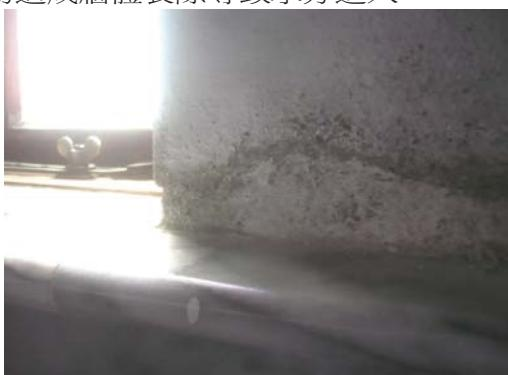
照片 5-47 水泥砂漿粉刷層剝落約 1cm
