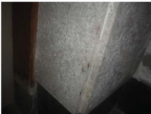
照片 5-41 鐘樓牆面石材風化
