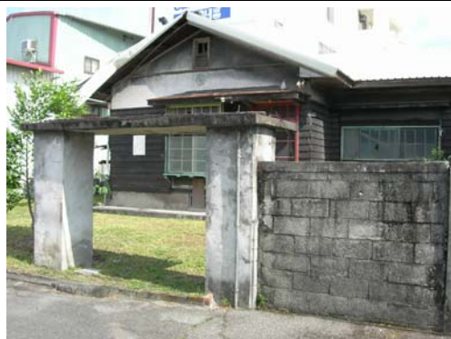
歷史建築左側門口及圍牆
