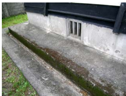
排水溝與通風口
