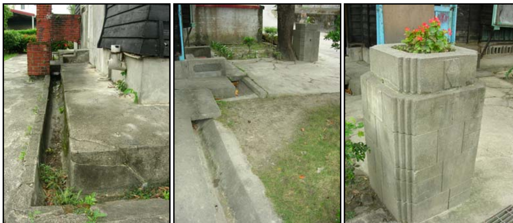
圖 2-3 美崙溪畔日式宿舍建築之排水溝與門柱
