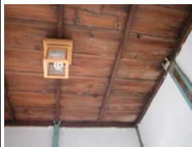
室內之天花板
