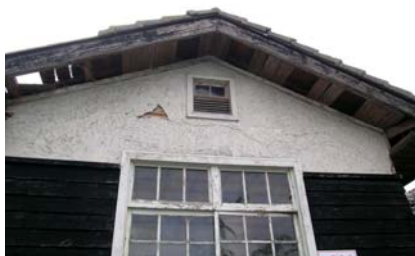
屋角、破風與通風口
