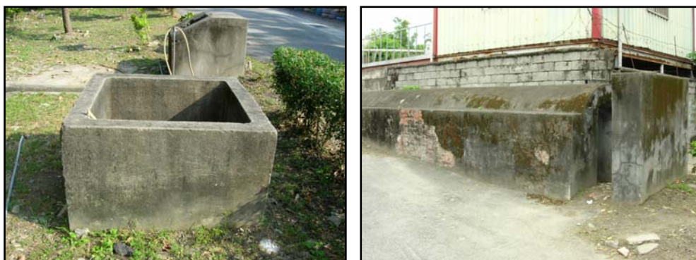
圖 2-2 美崙溪畔日式宿舍區內現存之消防砂池與防空洞
