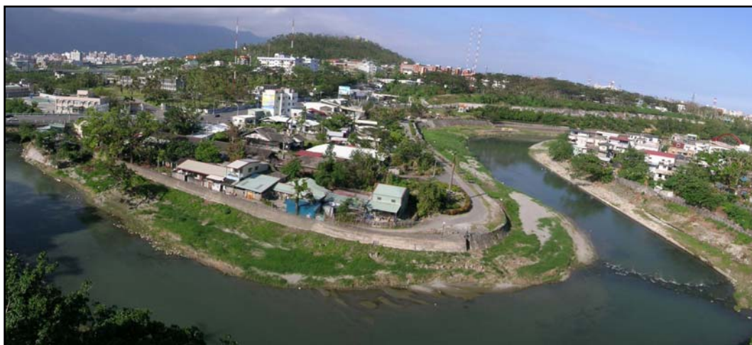
圖 6-1 美崙溪、美崙溪畔日式宿舍與河堤旁之違章建築
