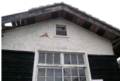
屋角、破風與通風口
