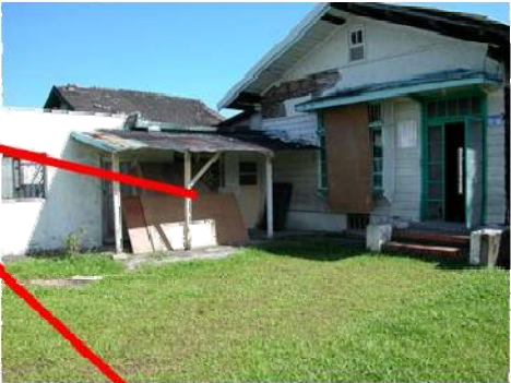
外牆雨淋板腐朽老化
