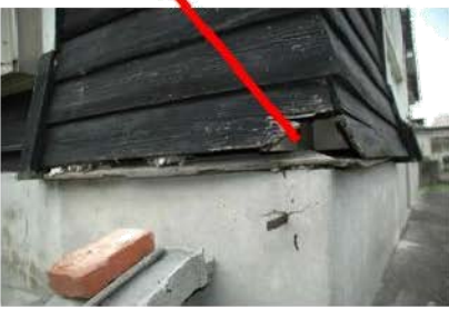
外牆雨淋板部分損毀
