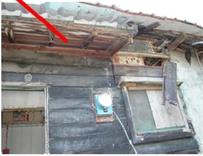
屋瓦已變成鋼瓦
