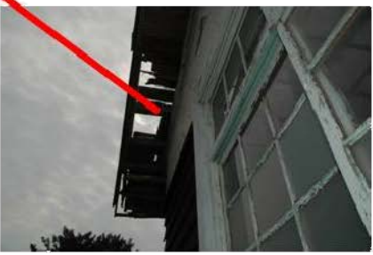
竹編灰泥牆 老化破壞損毀
