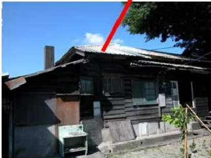
屋瓦已變成鋼瓦
