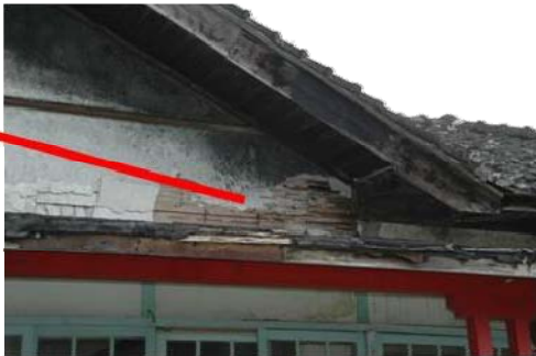
竹編灰泥牆 老化破壞損毀
