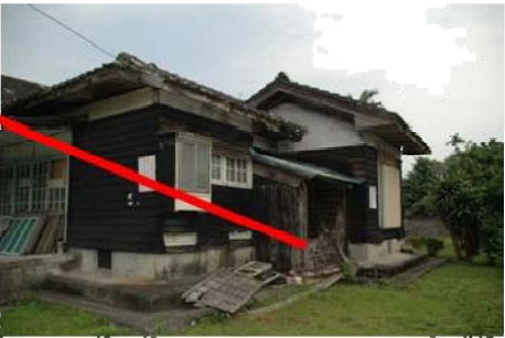
外牆雨淋板部分損毀
