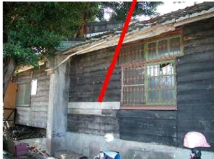
外牆雨淋板腐朽老化
