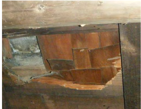
照片 4-18 鋪設於野地板上方之土居葺防水層
