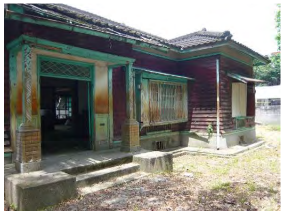
照片 4-2 周圍地坪為土壤綠敷地
