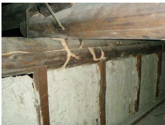
照片 4-9 屋架構件上的遮蔽管
