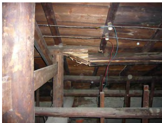
照片 4-12 母屋斷裂
