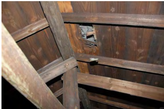
照片 7-11 屋架腐朽
