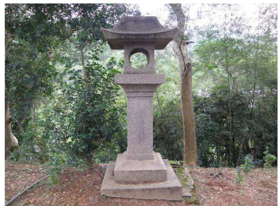
照片 7-18 混凝土構造石燈籠
