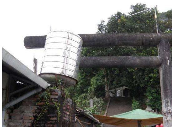
照片 7-8 現住戶設備影響景觀
