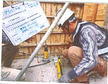
試驗位置 3 架設設備後執行測試狀態
