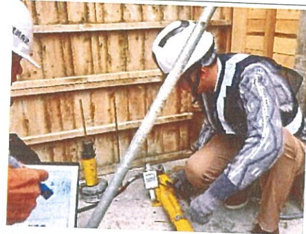
試驗位置 4 架設設備後執行測試狀態
