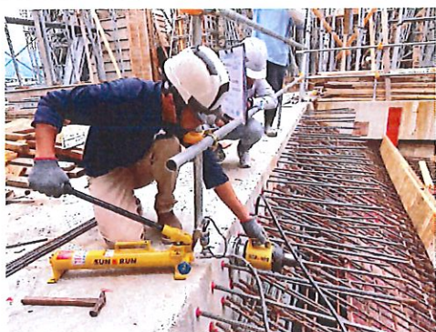
試驗位置 3 架設設備後執行測試狀態
