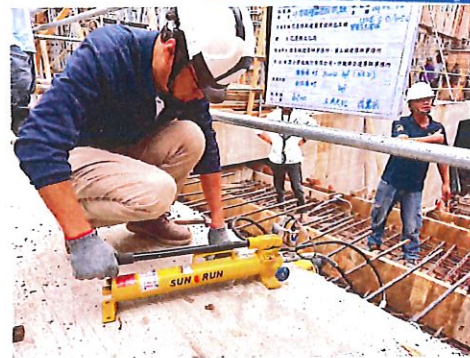
試驗位置 2 架設設備後執行測試狀態
