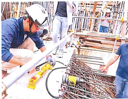
試驗位置 1 架設設備後執行測試狀態
