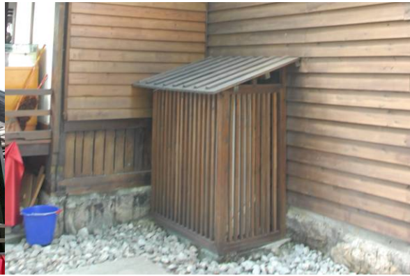
照片4-6 設施設備按時保養
