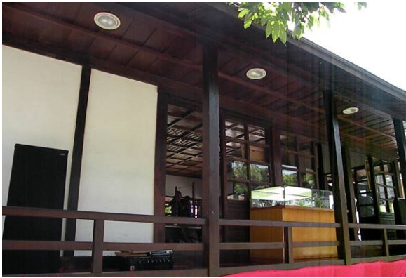
照片4-5 建築整體結構安全評估
