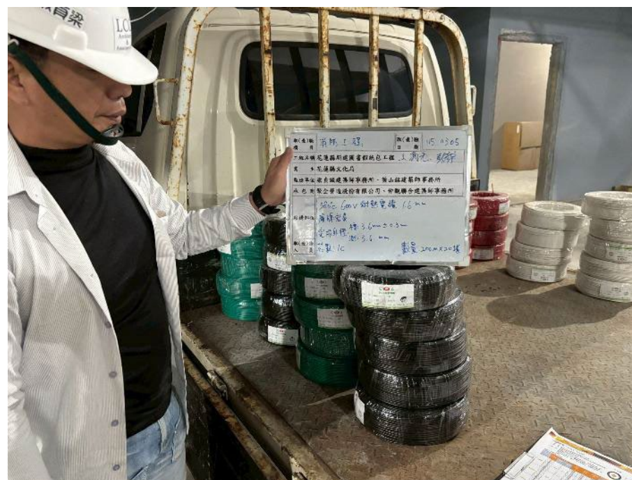
115.03.05 電線及電纜 (600V 380°C 15分耐熱線)材料進場查驗
