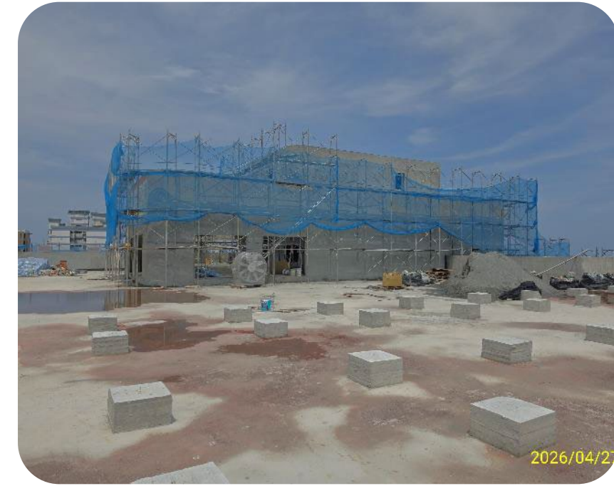
115/4/27-RF東側外牆
