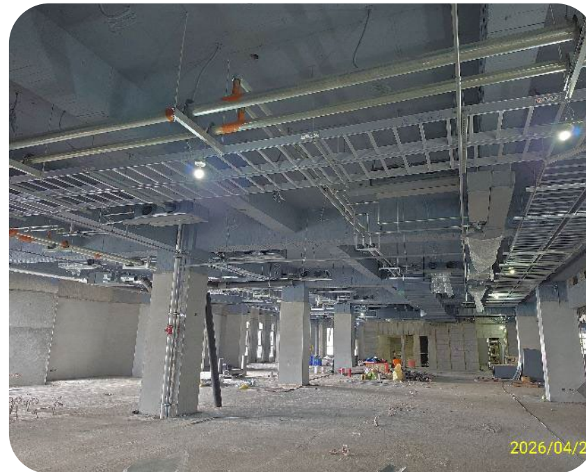
115/4/27-3F室內牆面
