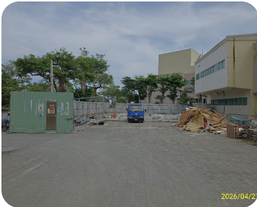
115/4/27-原工務所拆除情形
