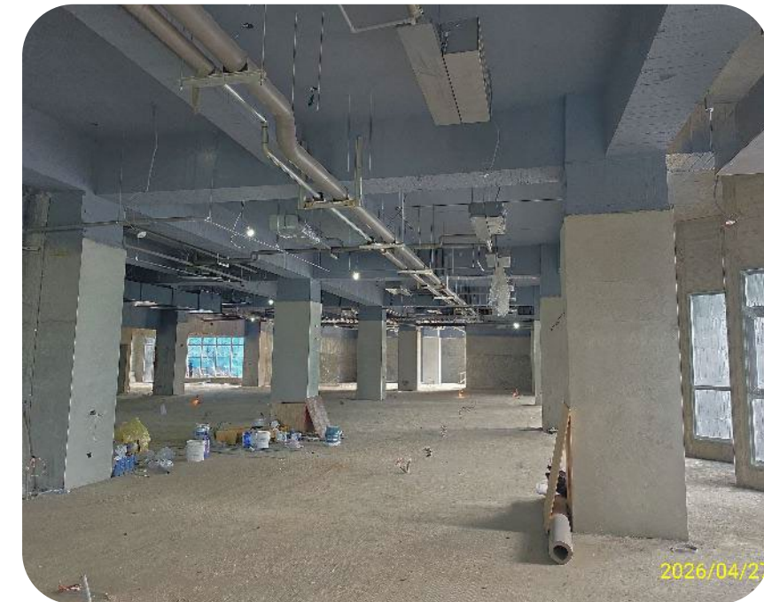
115/4/27-2F室內牆面
