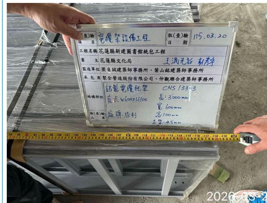
115.03.20 鋁製電纜托架材料進場查驗
