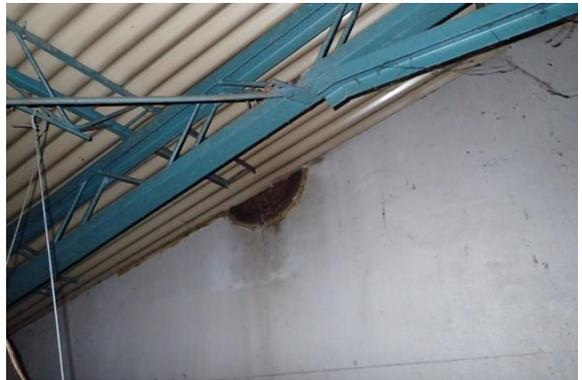
【照片 4-1-27】大殿南側的通風孔已失去原有功能。
