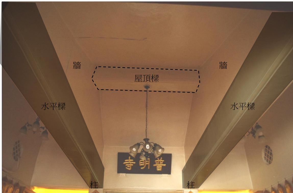
【照片 3-1-7】大殿屋頂中央的重量傳遞路徑為：屋頂樑、牆、水平樑、柱。
