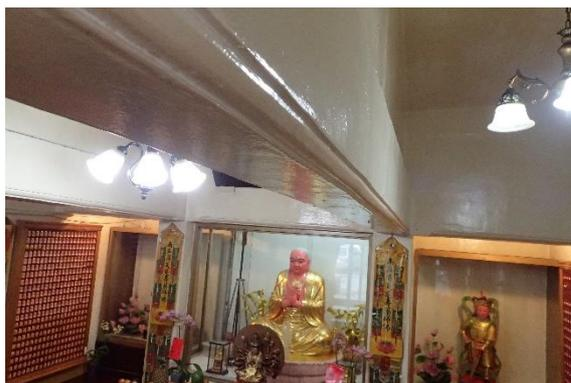
【照片 3-2-1】大殿水平樑斷面尺寸為：高 52cm，寬 40cm
