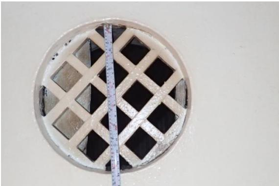
【照片 4-1-26】大殿北側的通風孔已失去原有功能。
