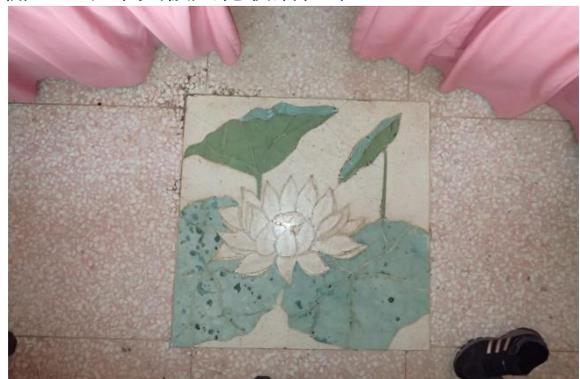
【照片 4-1-21】原有水泥砂漿粉光的地坪已改為磨石子地坪
