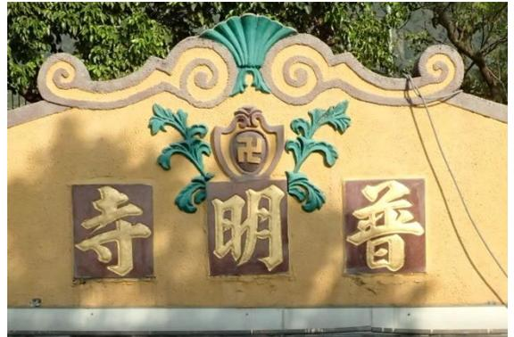
【照片 3-1-25】原本水泥砂漿塑造字體已經換為石板雕刻字體。
