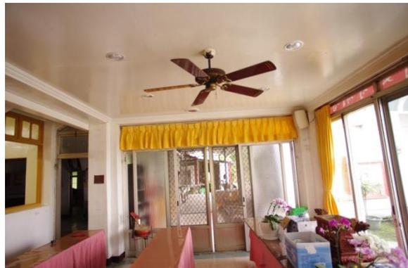
【照片 4-1-19】原有屋頂板下方加設吊扇、照明設備，並以木夾板天花收納管線。
