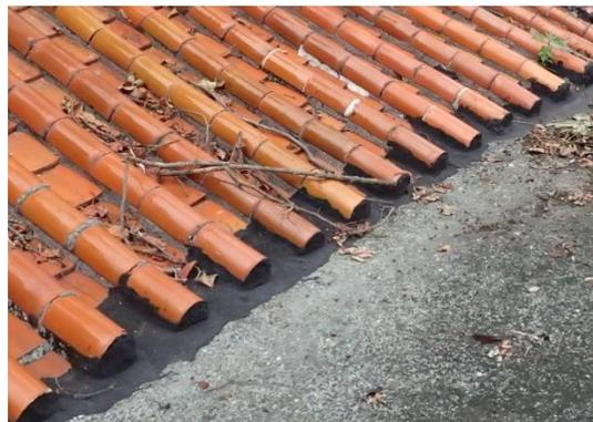
【照片 3-1-21】大殿東側屋簷局部原有板瓦與滴水瓦已埋入誦經堂的屋頂樓板內。
