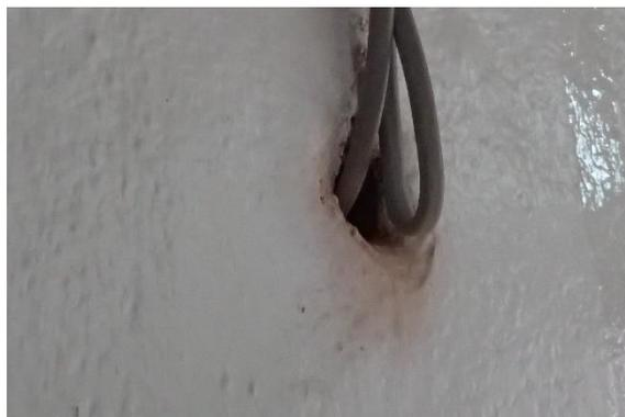
【照片 3-1-9】牆面上的電線孔周邊還有明顯的紅色粉末，可能為當時鑽孔時殘留的紅磚粉末。
