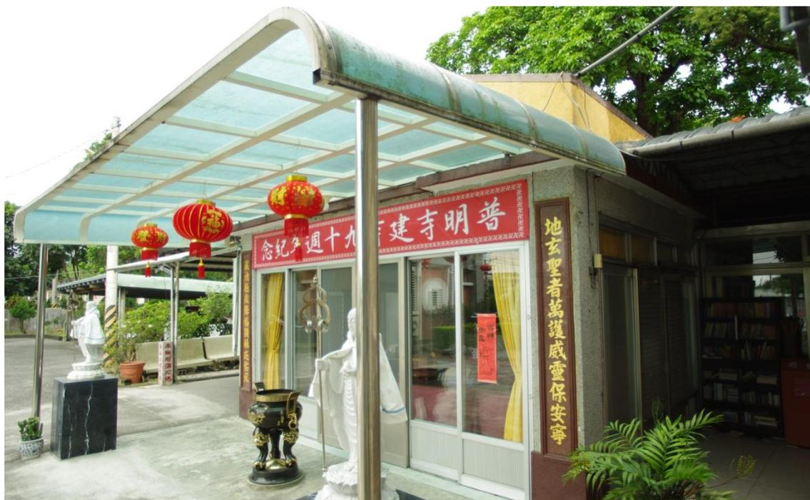
【照片 4-2-2】本歷史建築之一：普明寺誦經堂，為鋼筋混凝土構造。
