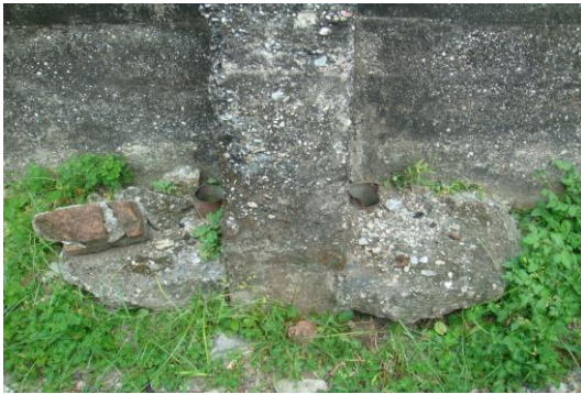
明智街側邊之 X 軸向圍牆柱周邊基墩外露情形。
