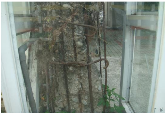
位於自由廣場後方的 Y10 圍牆的柱子因鋼筋鏽蝕、外露破壞情形較為嚴重，新增安全框架。
