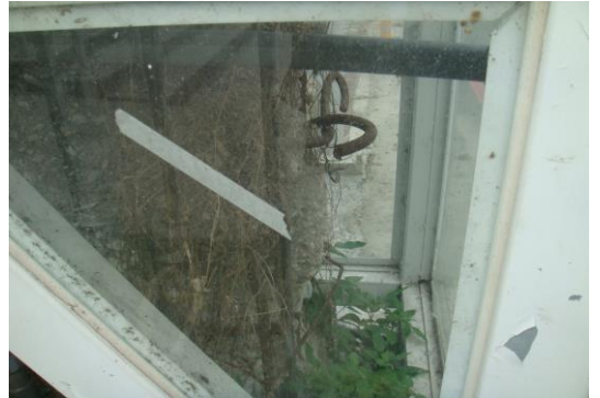
位於自由廣場後方的 Y10 圍牆的柱子因鋼筋鏽蝕、外露破壞情形較為嚴重，新增安全框架。
