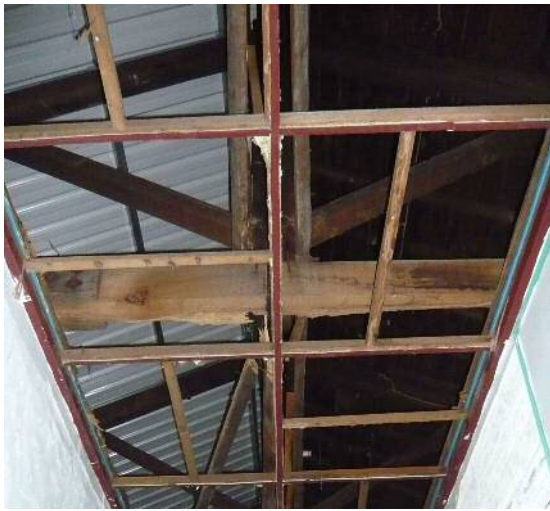
【照片 4-6】前棟走廊 A-02 上方屋架構件現況。
