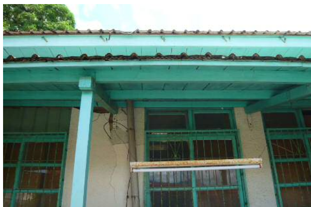
【照片 4-26】前棟屋頂面與落水管現況。
