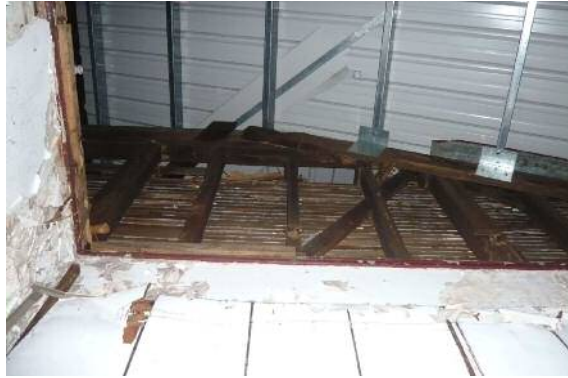
【圖 3-117】本建築之牆體主要為木椽壁
