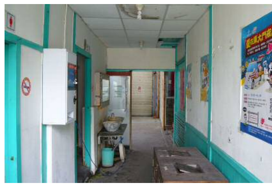
【照片 4-43】後棟便所 C-01，C-02
