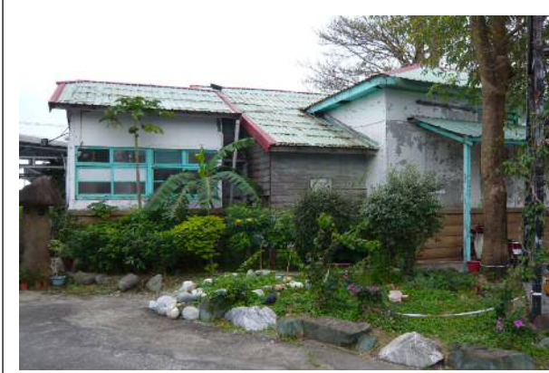
圖 3-49 目前的男便所改建於原暗房,而原暗房是戰後依著戶外簷廊所增建的空間,使得戶外簷廊變成室內走廊。
