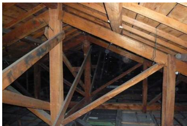
【照片 4-17】前棟空間 A-10 上方屋架構件現況。
