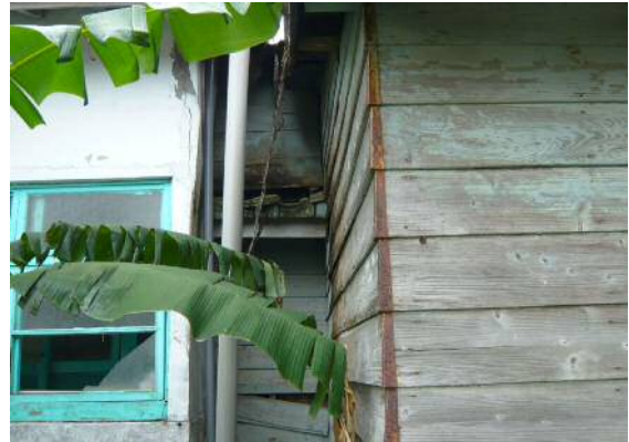
圖 3-50 目前在連接處可看到幾片被壓在牆體下的水泥軒瓦,應是屬於原戶外簷廊所有。
