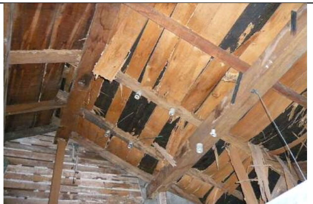
【圖 3-99】增建的廁所屋架與屋面是直接搭建於簷廊的屋面之上的和小屋式樣，形成雙重屋面型式。
