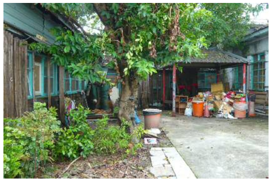
【圖 3-67】中央連廊北側的中庭花園已改成水泥鋪面，此處有兩株老榕，鄰近連廊處的高大老榕與楠樹共生，十分特殊，為此中庭的主要景觀。
