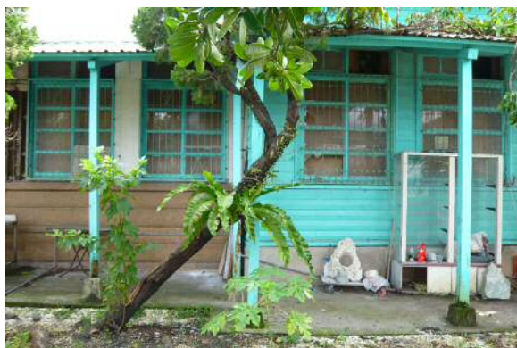
【圖 3-121】前棟南側增建牆體為小舞壁覆雨淋板
