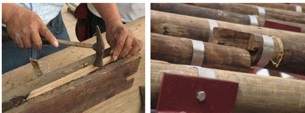
圖 6-4：木構件包覆鐵片（右）以及縫隙填補同材質木料
