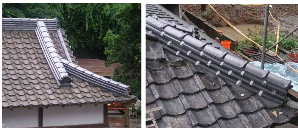
圖 6-2：日式建築瓦片重鋪
