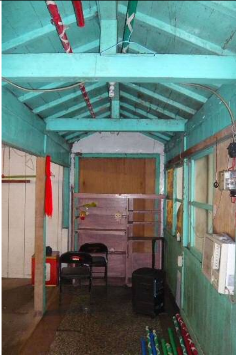
【圖 3-106】採用簷廊屋架的和小屋式樣，屋架與屋面板現況都保持非常良好
