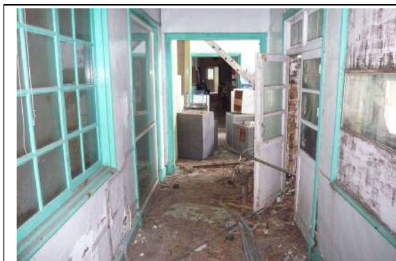
圖 6-13：進行地板水泥基台、磨石子拼花表面的檢修
