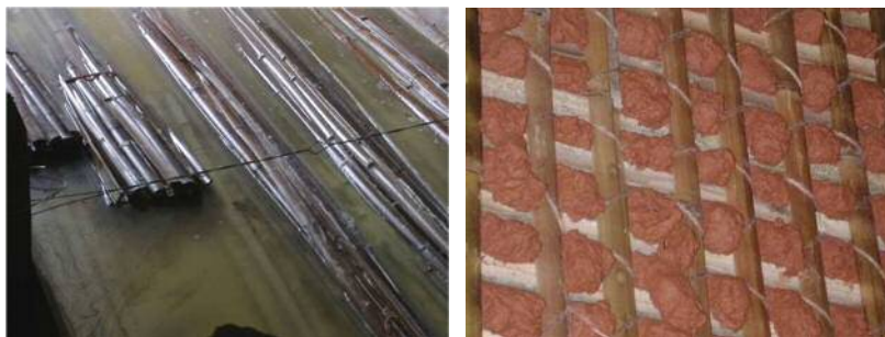
竹材防腐（左）與小舞壁底層泥料塗覆擠入竹編網目形成凸球狀咬合竹材
