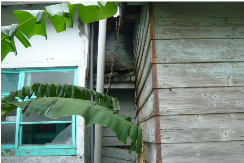
【圖3-111】由前棟增建之男廁所覆蓋的簷廊殘存邊緣軒瓦可以看到為日式水泥瓦。
