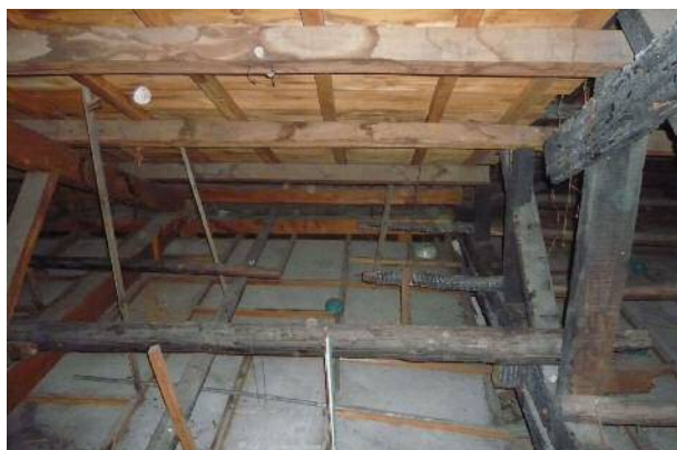
【照片 4-16】前棟空間 A-10 上方屋架構件現況。
