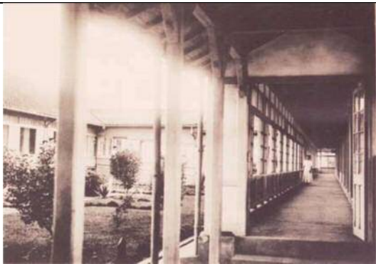
【圖 3-12】 明治 45 年（西元 1912 年）新竹醫院病棟照片
