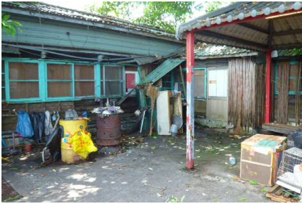
【圖 3-62】後棟為病房棟，藉中央連廊來與前棟串連。
