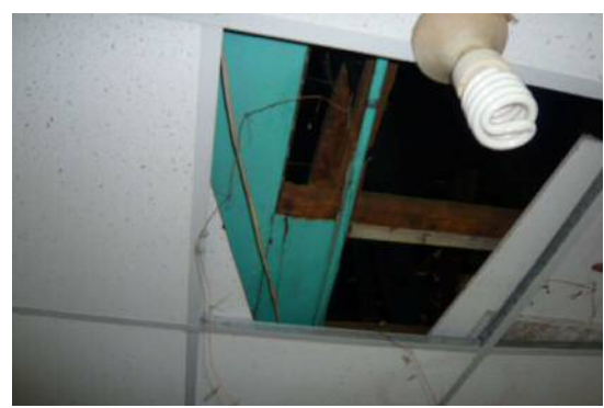
【照片 4-60】大致良好，目前被覆蓋在新作天花之內。
