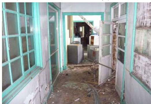
圖 4-30：前棟中央走廊地坪空間現況
