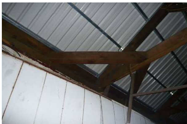
【照片 4-10】前棟空間 A-05 上方屋架構件現況。
