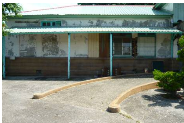
【照片 4-21】前棟屋頂面現況。
