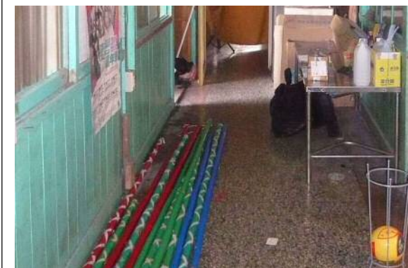
【圖 3-125】中央連廊的地板採用的是磨石子地面。
