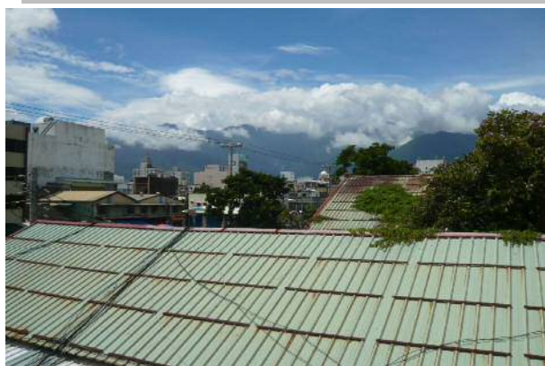
【照片 4-22】後棟屋頂面現況。
