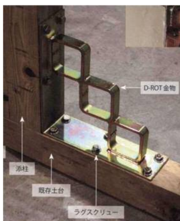
牆體框架角隅增設剛性鐵件提升牆體單元強度
