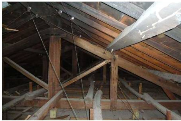
【圖 3-81】成排的屋架、屋面板與天花板依舊保有良好的狀況。
