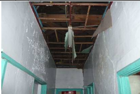
【照片 4-58】前棟部份破壞拆除，部份破損變形。
