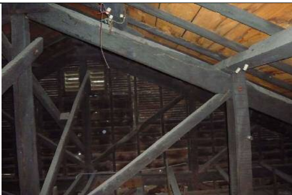
【圖 3-92】外牆有部份是木摺壁，部份是小舞壁。
