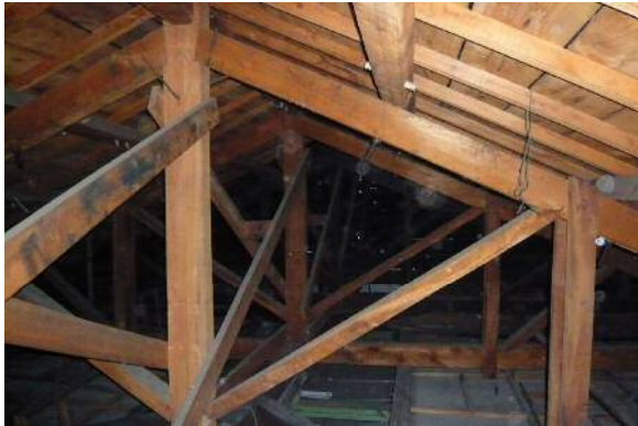
圖 4-2：前後棟主館為木造洋小屋屋架式樣
