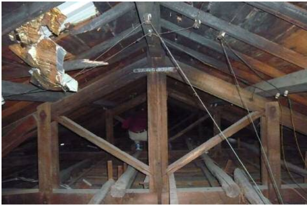
【圖 3-64】後棟的屋架、屋面板與天花板依舊良好。
