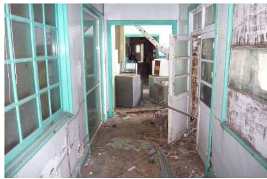
【照片 4-33】前棟走廊 A-02
