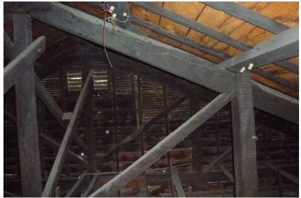
【圖 3-118】前棟南側增建牆體為小舞壁
