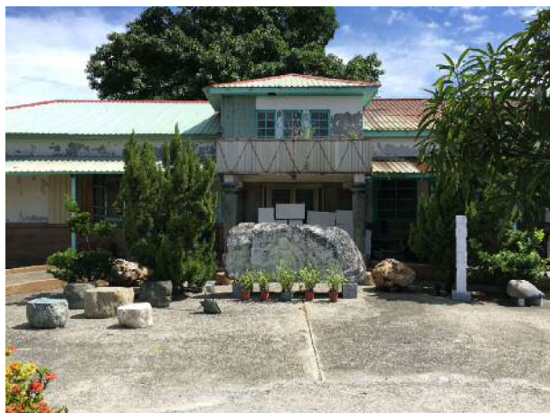
【照片 4-20】前棟屋頂面現況。
