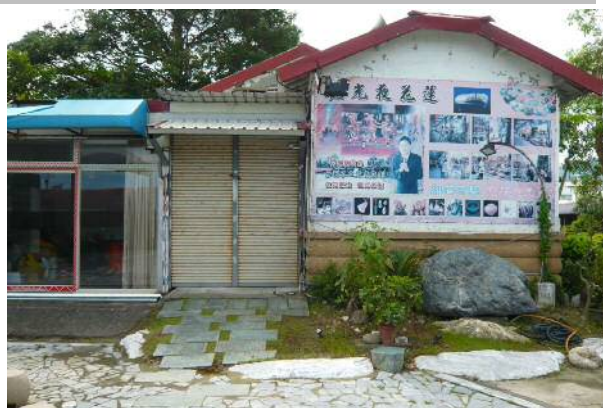
【照片 4-23】前棟側向屋頂面現況。
