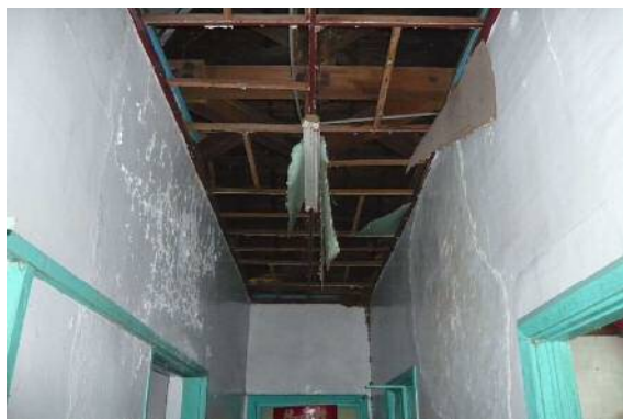
【圖 3-119】前棟採傳統「大壁造」作法
