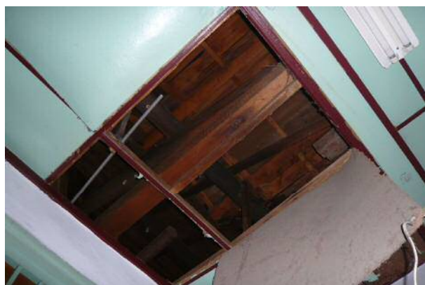
【照片 4-13】前棟空間 A-07 上方屋架構件現況。
