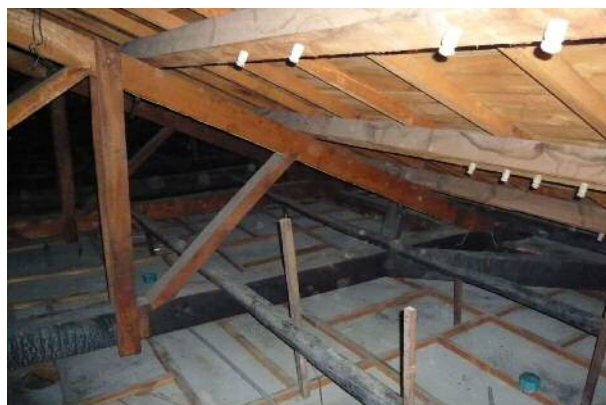
【照片 4-11】前棟空間 A-06 上方屋架構件現況。
