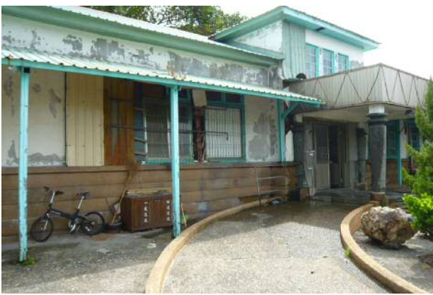
【圖 3-60】向外突出的門廊及車寄，斜坡車道可直接到達主入口。兩側並有成排立柱簷廊。
