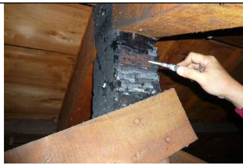
圖 3-54 碳化深度約 5mm 厚，並未影響木料的結構性。
