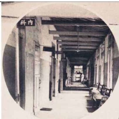
【圖 3-16】花蓮港醫院廳舍內部廊道照片
