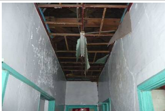
【照片 4-46】前棟走廊 A-02。
