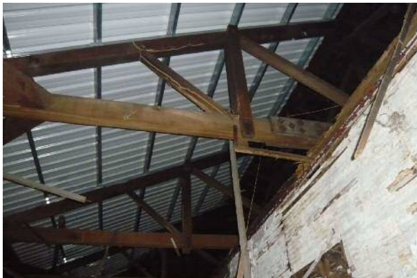
【照片 4-8】前棟空間 A-03 上方屋架構件現況。
