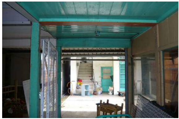
【圖 3-83】C-04：病房棟的中央過廊，兩側僅保留原始的立柱，牆面皆已遭到更動。
