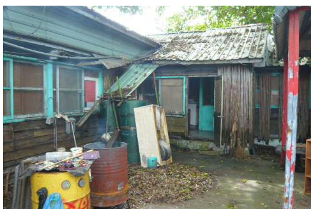
【照片 4-24】中央連廊屋頂面現況。
