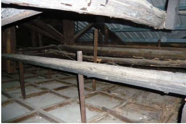
【照片 4-4】前棟走廊 A-01 上方屋架構件現況。
