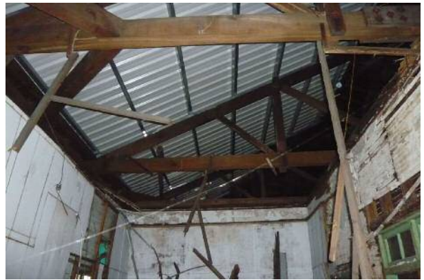
【照片 4-7】前棟空間 A-03 上方屋架現況。
