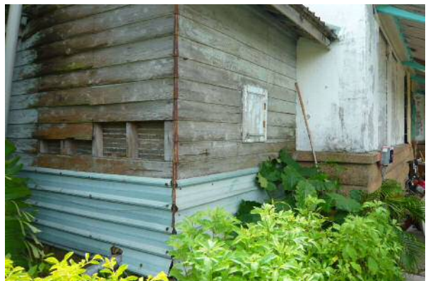
【圖 3-122】北側增建的男廁牆體為木椽壁覆雨淋板
