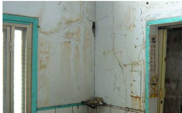
【照片 4-44】【照片 4-45】入口大廳 A-01 牆體有局部破壞與白灰牆剝落的情形。
