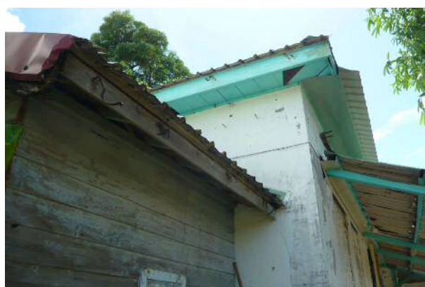
【照片 4-25】前棟側向屋頂面現況。
