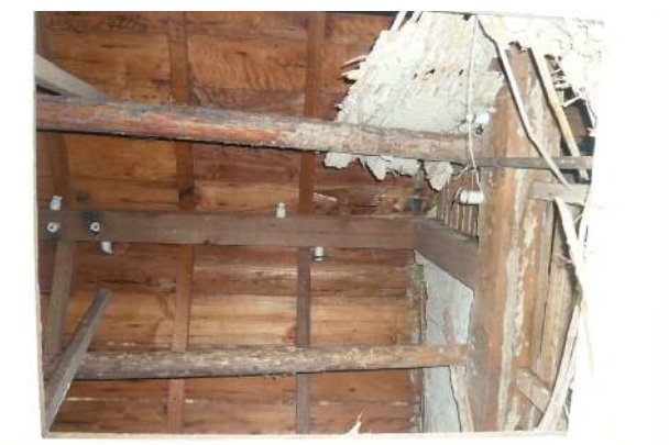
【照片 4-14】前棟空間 A-08 上方屋架構件現況。
