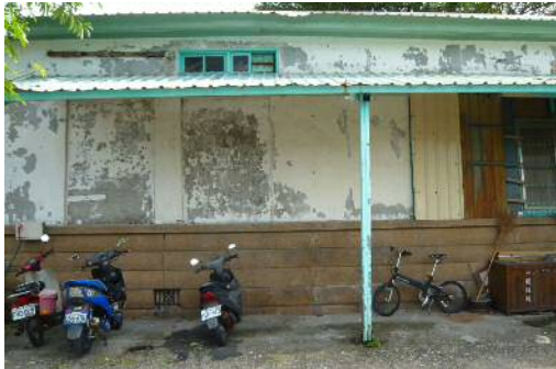
【照片 4-29】混凝土抬高基台。
