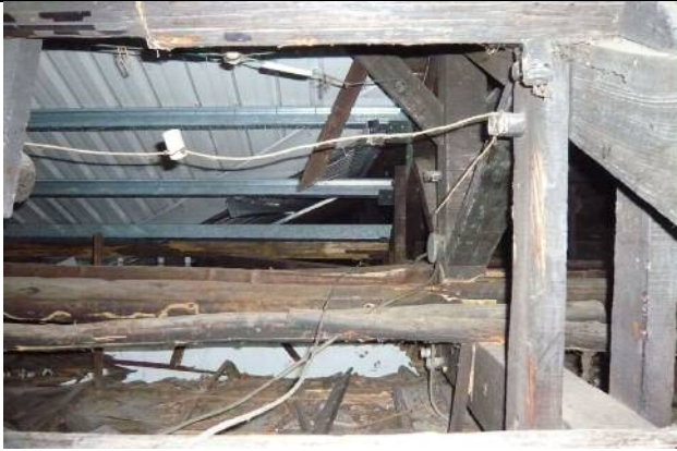
【圖 3-94】中央大廳斜屋頂由 4 組桁架所組成，屋面板、椽子已遭拆除，並以槽鐵與鐵皮浪板取代。
