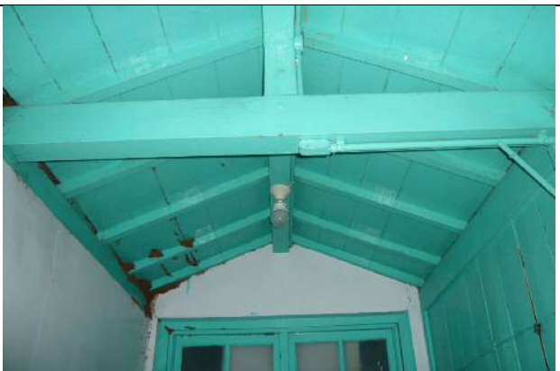
【圖 3-98】中央走廊靠近末端廁所是採簷廊的屋面與屋架型式，可以推測是後來增建導致變成室內走廊。
