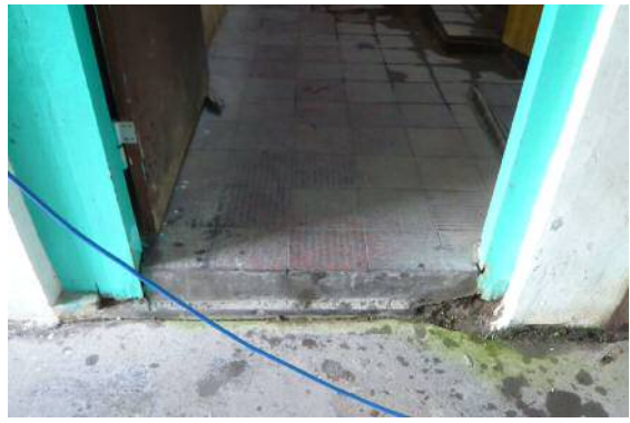
【圖 3-128】便所空間包括地板與土台都被以混凝土填實。
