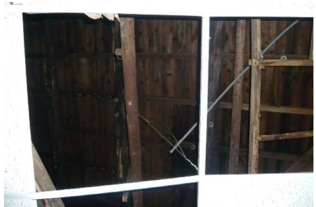
【照片 4-9】前棟空間 A-05 上方屋架構件現況。
