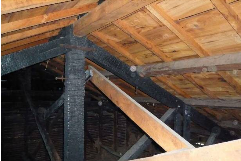
【圖3-112】由下而上包含椽子、屋面板、防水層與掛瓦條
