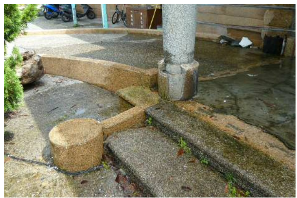
【圖 3-61】車寄、斜坡車道與入口階梯。
