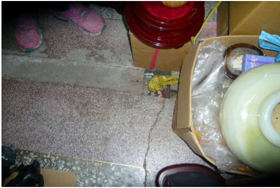
【圖 3-127】局部挖開的柱礎位置，可以看到包括土台也都被以混凝土填實。
