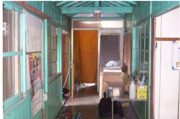
【圖 3-143】中央連廊室內大門已改為現代木門。
