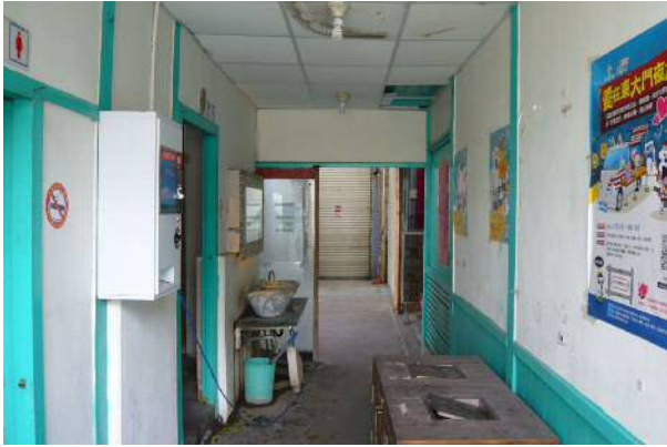
【圖 3-138】後棟的男女廁的木質門扇與門框亦保留十分完整
