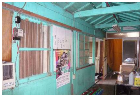
【照片 4-55】中央連廊 B-01，左側外牆已遭拆除。
