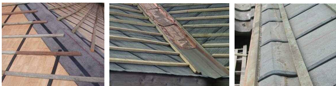
圖 6-3：屋頂新鋪防水毯並增設洩水條（需注意避免在廣小舞部位產生凹槽）
