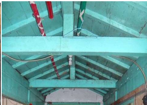
【照片 4-19】中央連廊 B-01 上方屋架構件現況。
