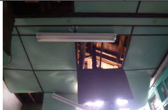
【照片 4-58】前棟部份破壞拆除，部份破損變形。
