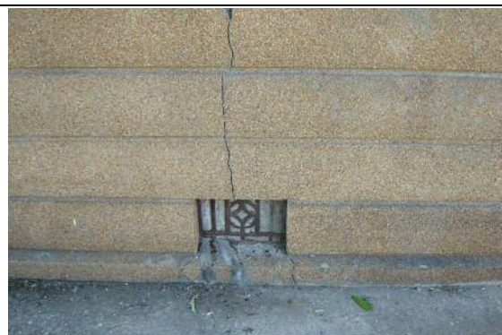
【圖 3-124】勒腳牆尚可看到被水泥填補的通氣孔。
