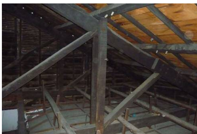
【照片 4-18】前棟空間 A-10 上方屋架構件現況。
