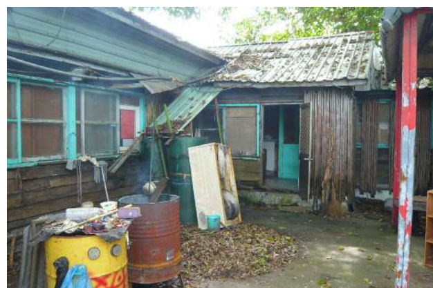
「歷史建築舊花蓮鐵路醫院」中庭與連廊
