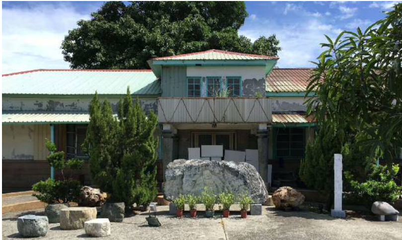
【圖3-110】現今「歷史建築舊花蓮鐵路醫院」屋頂均更換為金屬鋼浪板。
