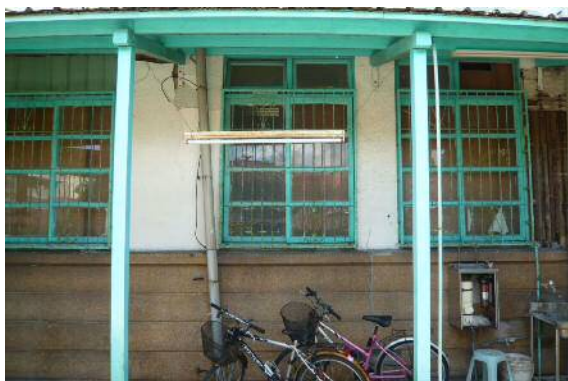
【圖 3-133】正面外牆的格子窗與通氣窗尚稱完整。
