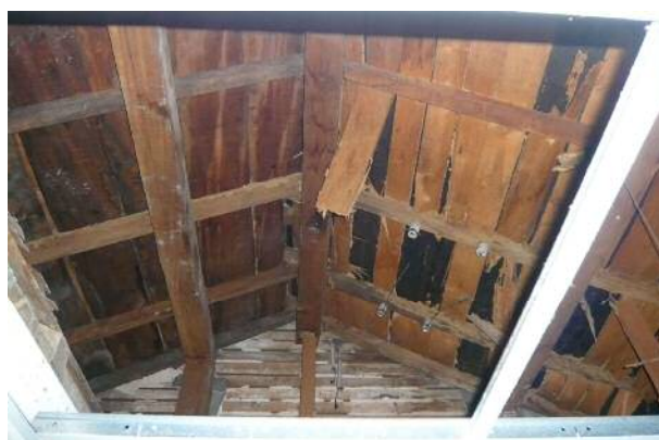
【照片 4-15】前棟空間 A-08 上方屋架構件現況。
