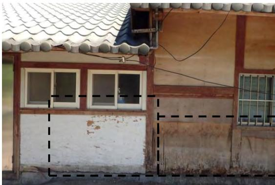
【照片 4-1-21】木夾板劣化破損
