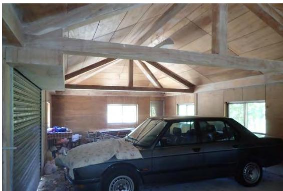
【照片 4-1-9】右護龍已改為鋼構造，外包覆木夾板
