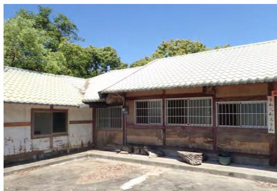
【照片 4-1-18】木夾板劣化破損
