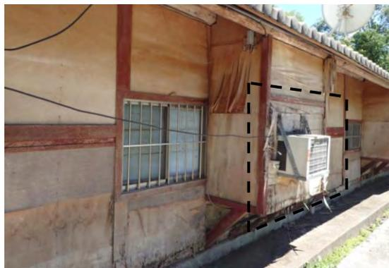
【照片 4-1-22】木夾板因加裝冷氣破損
