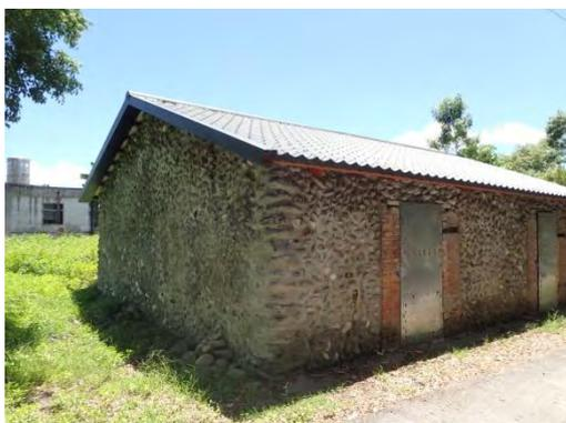
【照片 4-2-3】已整修之第三室，屋面鋪設金屬浪板
