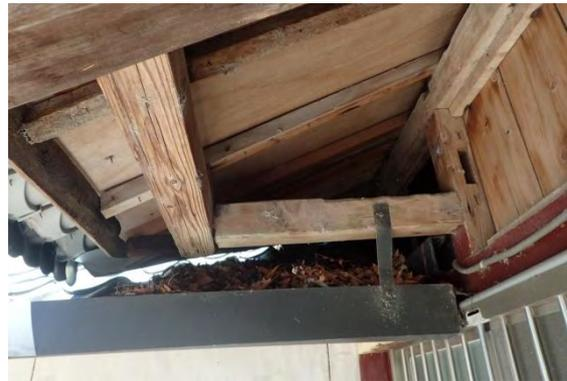
【照片 4-1-48】屋頂轉折處之排水溝遭落葉阻塞
