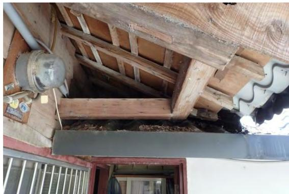
【照片 4-1-50】屋頂轉折處之排水溝遭落葉阻塞
