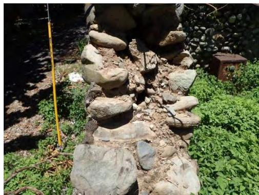
【照片 3-4-15】牆體兩側以卵石疊砌，中央填補碎石與泥土
