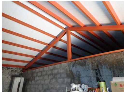
【照片 4-2-2】已整修之第三室，屋頂設置鋼構架與 C 形鋼支撐
