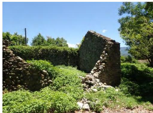
【照片 4-2-10】第一室屋頂坍塌，牆體部份倒塌
