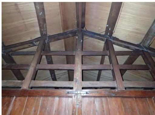
【照片 3-2-5】神明廳兩側混合式棟架設置人字樑
