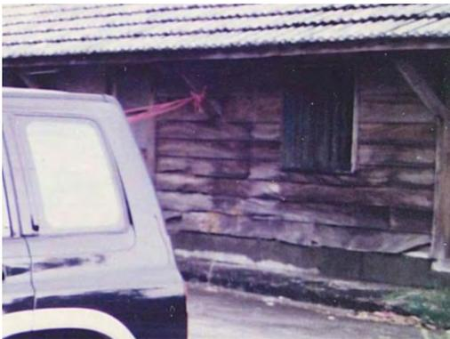
【照片 3-2-19】左護龍正立面之編竹夾泥牆外鋪設雨淋板。資料來源：連洪德先生提供。
