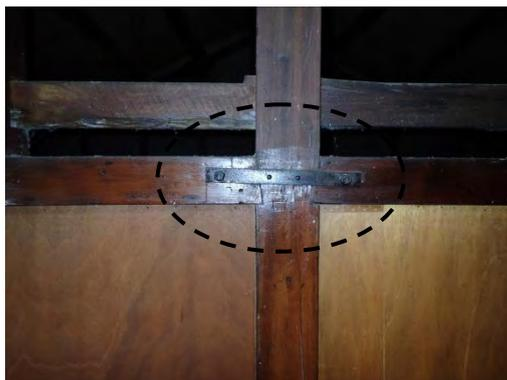
【照片 3-2-6】神明廳兩側混合式棟架以日式榫接及鐵件固定
