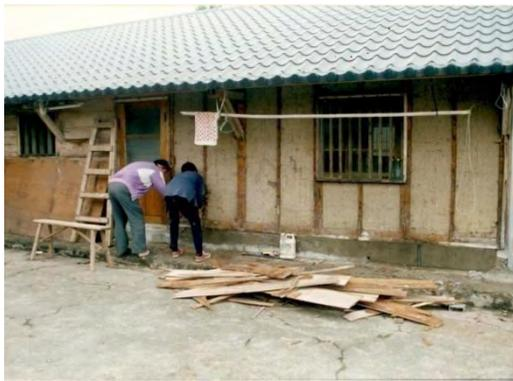
【照片 3-2-20】左護龍正立面之編竹夾泥牆，雨淋板已拆除。資料來源：連洪德先生提供。
