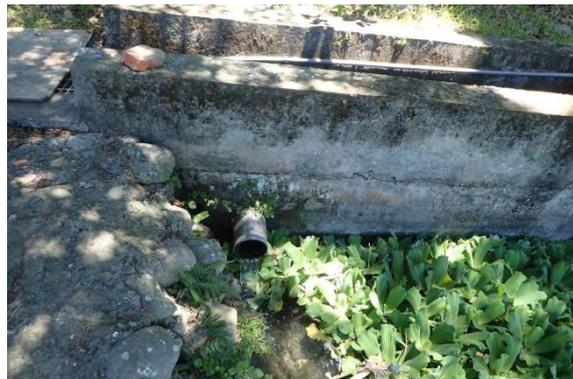
【照片 4-3-4】排水溝之進水孔遭落葉阻塞
