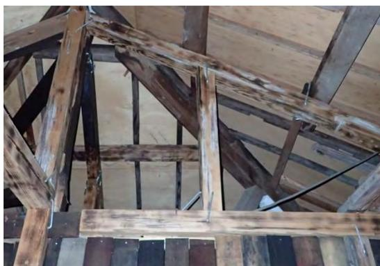
【照片 4-1-12】集貨室上方屋架已整修，但工法較為簡易
