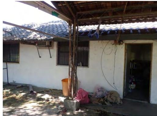
【照片 3-4-26】停車棚架為鋼構造，設有混凝土基座
