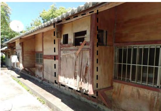
【照片 4-1-24】木夾板因加裝冷氣破損
