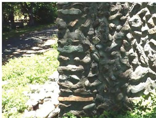
【照片 3-4-7】第一室平面轉角處以較大的扁平卵石砌築
