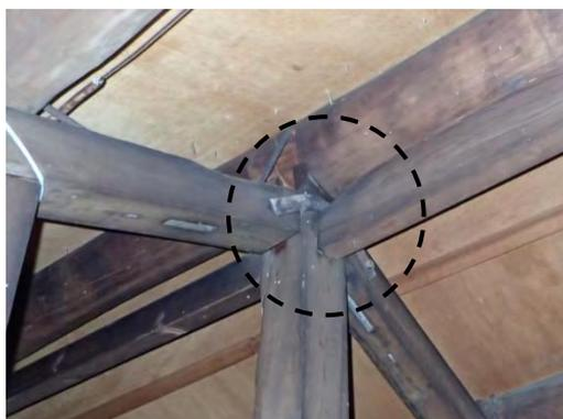
【照片 3-2-7】神明廳兩側混合式棟架以日式榫接及鐵件固定
