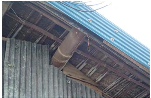
【照片 2-3-6】現況仍使用竹子與藤結之工法，屋頂鋪設茅草，外層再鋪設一層鐵皮
