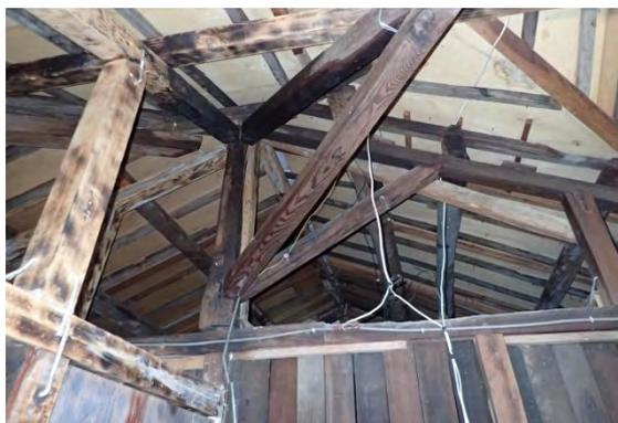
【照片 4-1-11】集貨室上方屋架已整修，但工法較為簡易
