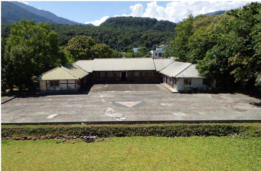
【照片 4-1-8】外埕已重鋪洗石子地坪，目前已部份龜裂與破損
