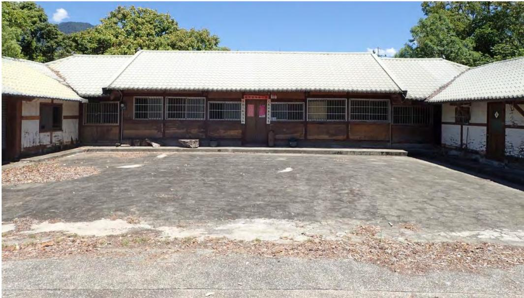
【照片 4-1-7】內埕的水泥砂漿粉光地坪有裂痕，且與外埕交接處有明顯分界
