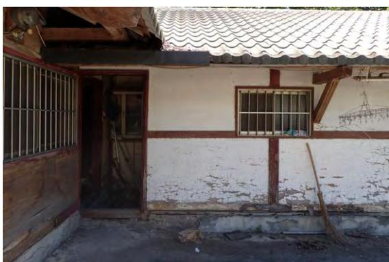
【照片 4-1-31】木夾板劣化破損
