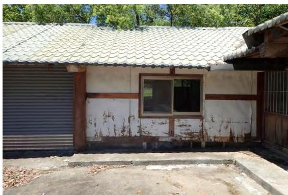
【照片 4-1-29】木夾板劣化破損
