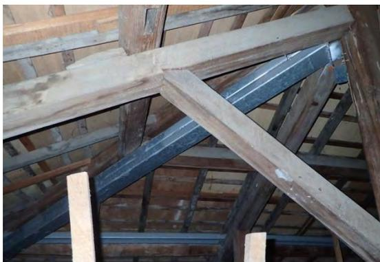
【照片 4-1-16】左護龍屋架以 C 形鋼補強
