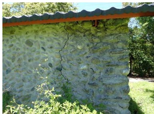
【照片 4-2-4】已整修之第三室，卵石砌牆開裂
