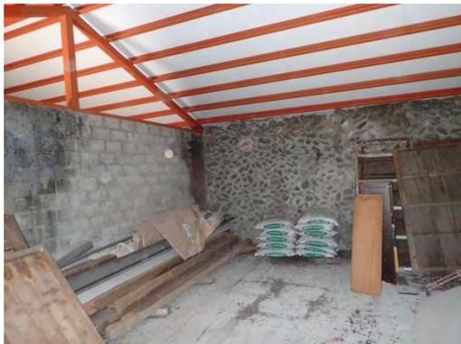
【照片 4-2-1】已整修之第三室，地坪以水泥砂漿重新打底
