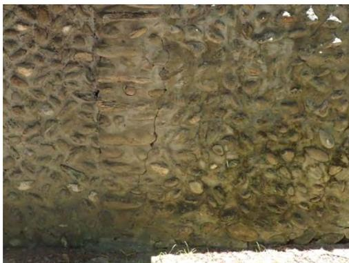
【照片 3-4-9】第二室平面轉角處以較大的扁平卵石砌築
