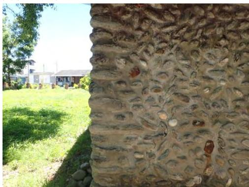
【照片 3-4-11】第三室平面轉角處以較大的扁平卵石砌築
