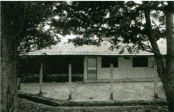
【照片 2-3-16】左護龍外牆部份更改為磚牆，外層再包覆美耐板，資料來源：連洪德先生提供。
