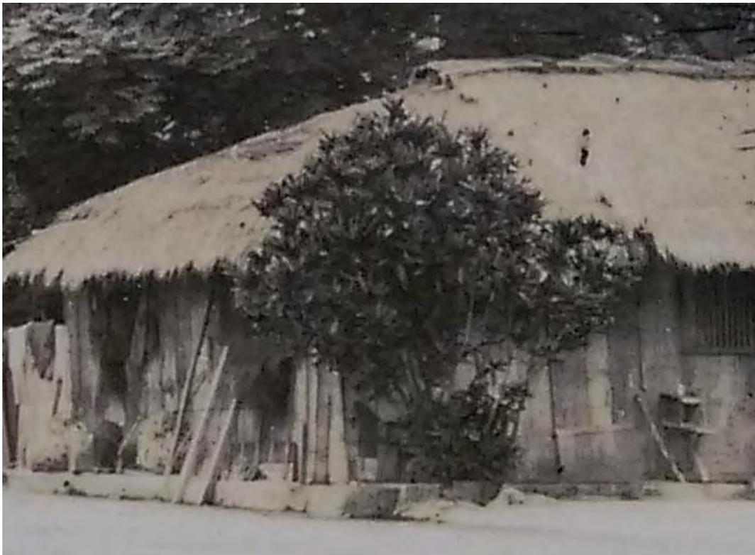
【照片 3-2-21】日治時期的右護龍外牆為垂直鋪設的木板牆。資料來源：連洪德先生提供。
