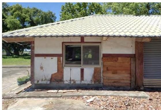
【照片 4-1-30】木夾板劣化破損
