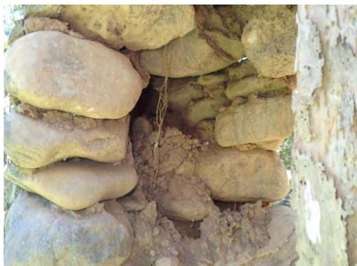
【照片 3-4-14】牆體兩側以卵石疊砌，中央填補碎石與泥土
