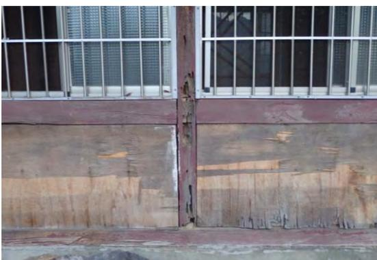
【照片 4-1-20】木夾板劣化破損
