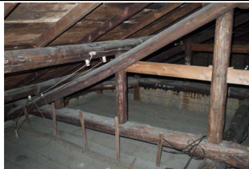
照片 4-1.18 屋架 2 現況照片 2
