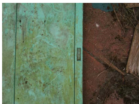
照片 4-2.22 D5'建具現況照片 3
