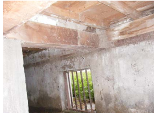
照片 4-1.2 床組現況照片 2
