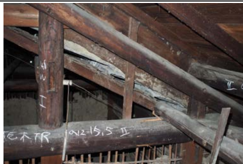
照片 4-1.24 屋架 3 現況照片 2
