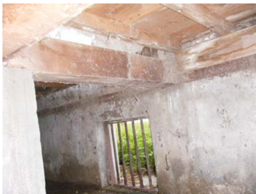
照片 4-1.9 床組現況照片 9
