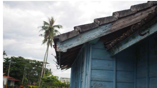
照片 4-3.16 屋頂瓦現況
