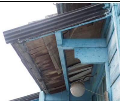
照片 4-2.7 D1 建具現況照片 7
