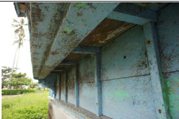
照片 4-2.29 W1 建具現況照片 3
