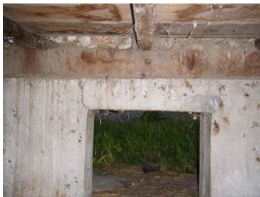
照片 4-1.1 床組現況照片 1
