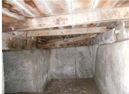
照片 4-1.10 床組現況照片 10
