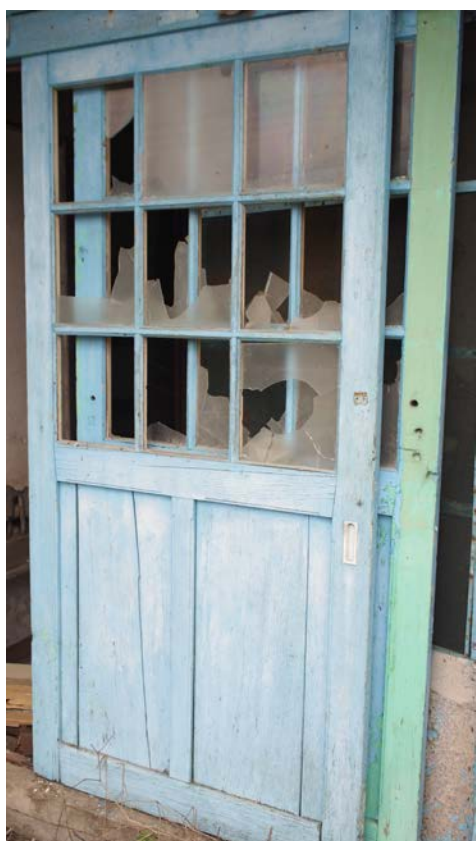
照片 4-2.2 D1 建具現況照片 2
