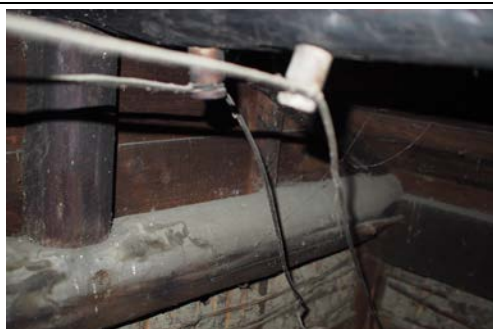
照片 4-1.39 屋架 5 現況照片 3
