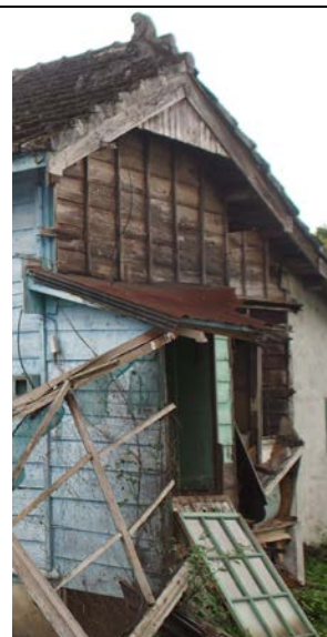
照片 4-2.35 W2 建具現況照片 3
