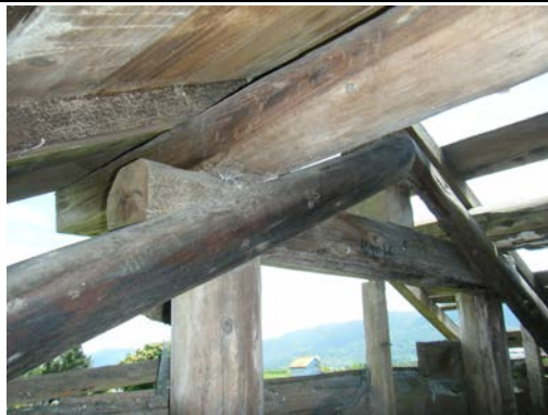
照片 4-1.15 屋架 1 現況照片 5
