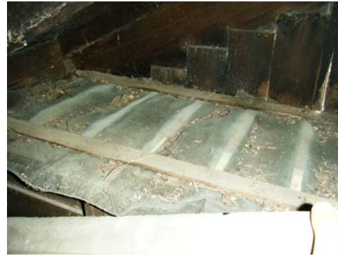
照片 4-1.36 屋架 4 現況照片 8
