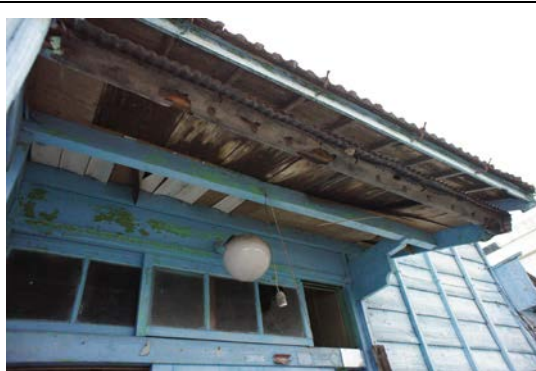
照片 4-2.6 D1 建具現況照片 6
