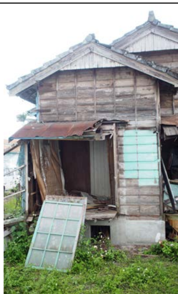
照片 4-2.34 W2 建具現況照片 2
