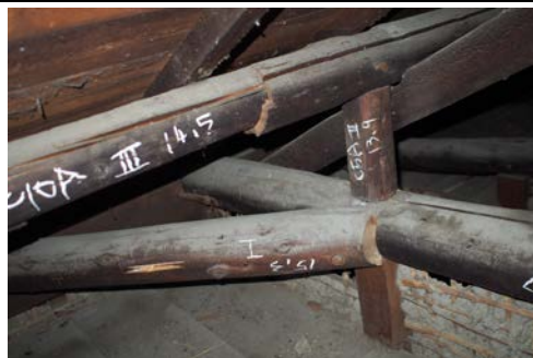
照片 4-1.26 屋架 3 現況照片 4
