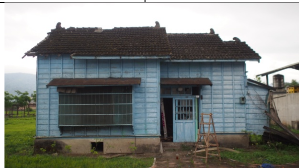
照片 3-3-1 建築正立面現況照片
