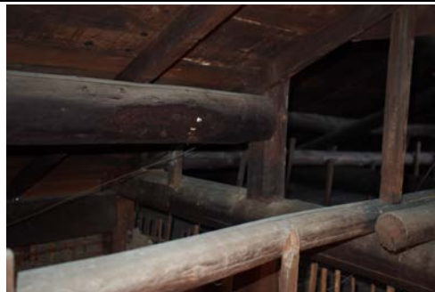
照片 4-1.28 屋架 3 現況照片 6
