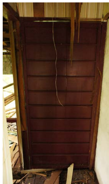
照片 4-2.26 D9 建具現況照片 (由廊下側觀看)
