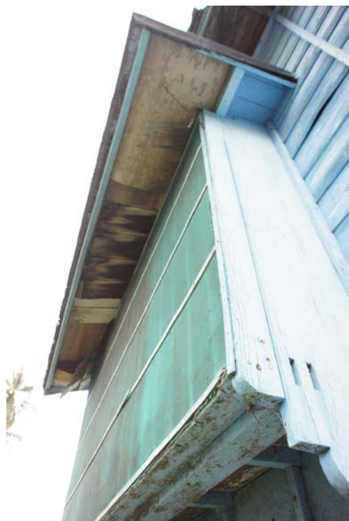
照片 4-2.27 W1 建具現況照片 1
