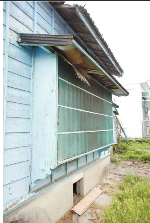
照片 4-2.32 W1 建具現況照片 6
