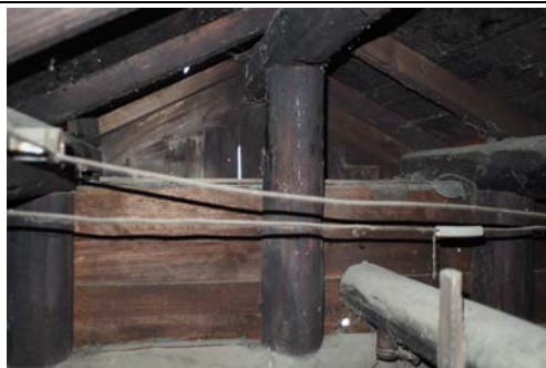
照片 4-1.37 屋架 5 現況照片 1
