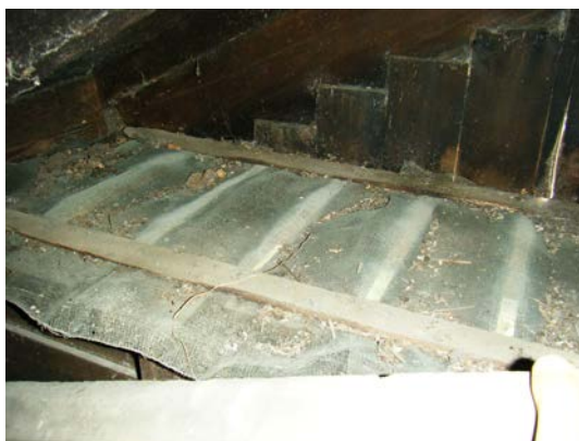
照片 4-1.49 軒先現況照片 2(由屋架內拍攝)
