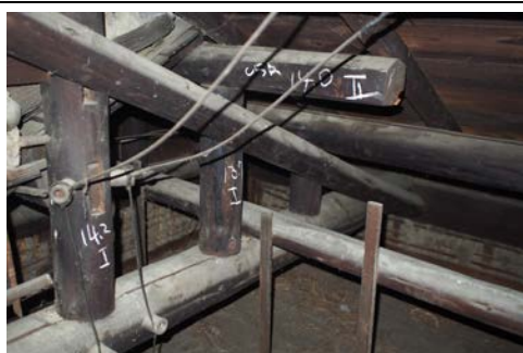
照片 4-1.33 屋架 4 現況照片 5
