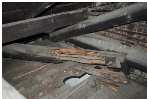
照片 4-1.31 屋架 4 現況照片 3
