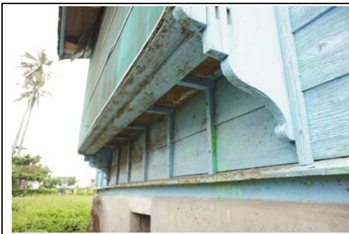
照片 4-2.30 W1 建具現況照片 4
