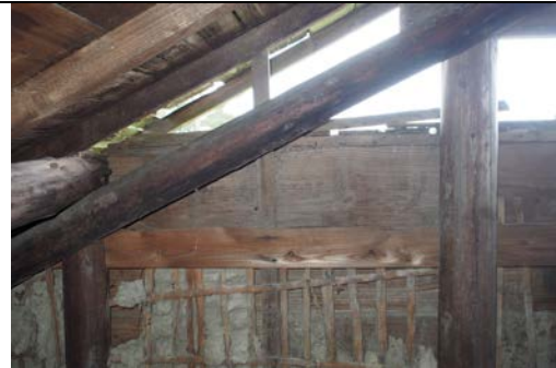
照片 4-1.12 屋架 1 現況照片 2
