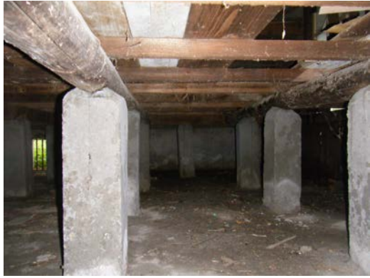
照片 4-1.5 床組現況照片 5
