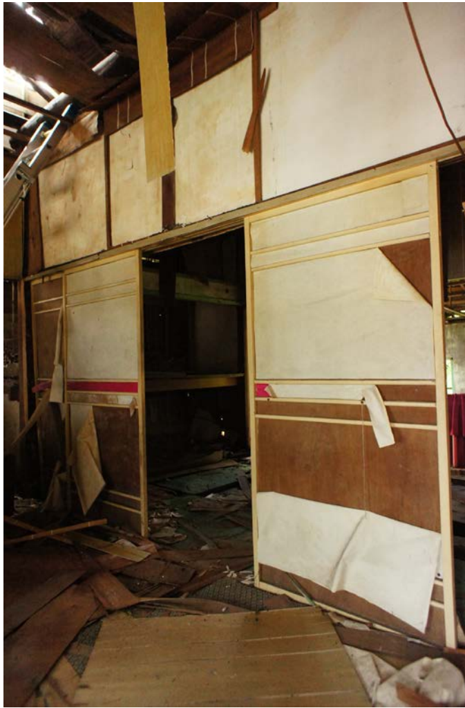
照片 4-2.14 D4 建具現況照片(由座敷側觀看)
