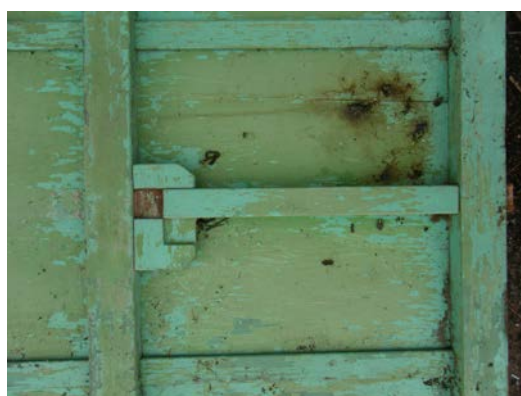
照片 4-2.23 D5'建具現況照片 4
