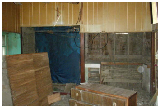
照片 4-3.8 空間 03 押入與床之間真壁構造
