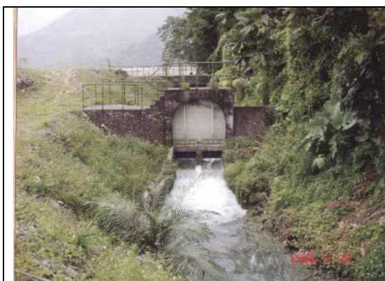
照片 2-3.6 林田圳閘門現況
