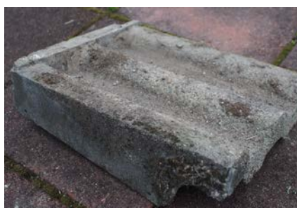
照片 4-1.40 角瓦現況照片 1
