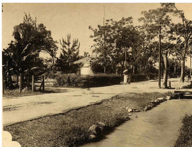
圖 2-2.8 林田村排水圳路
