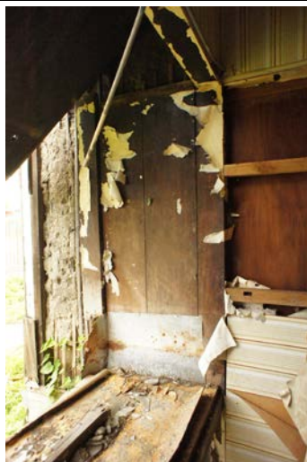
照片 4-2.40 W3 建具現況照 片 3
