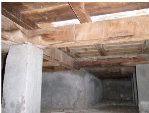
照片 4-1.7 床組現況照片 7
