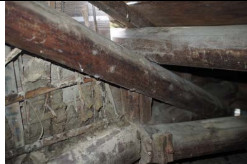
照片 4-1.14 屋架 1 現況照片 4
