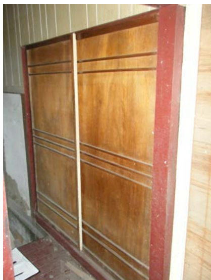
照片 4-2.9 D2 建具現況照片(由玄關側觀看)
