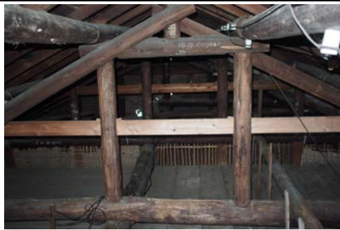
照片 4-1.17 屋架 2 現況照片 1
