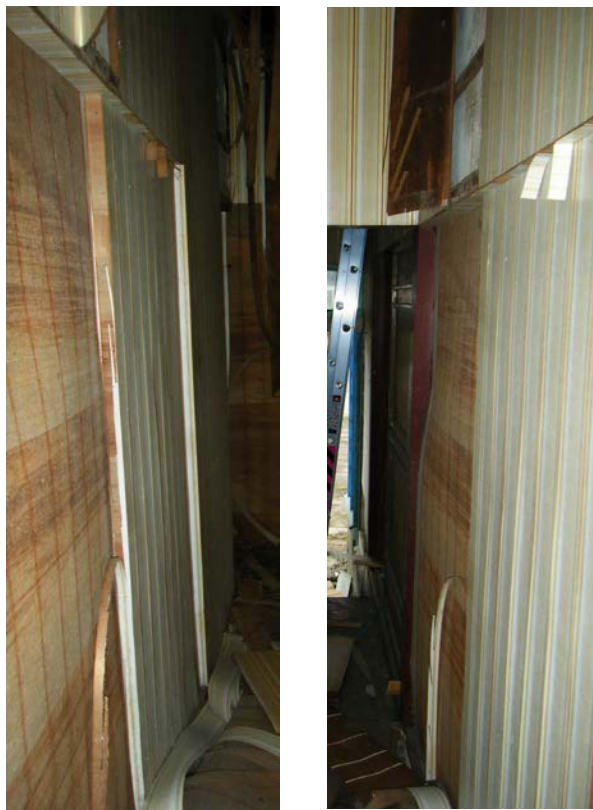
照片 4-2.13 D3 建具現況照片(由廊下側觀看)
