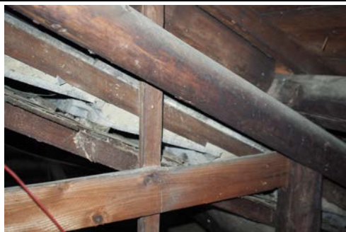
照片 4-1.27 屋架 3 現況照片 5
