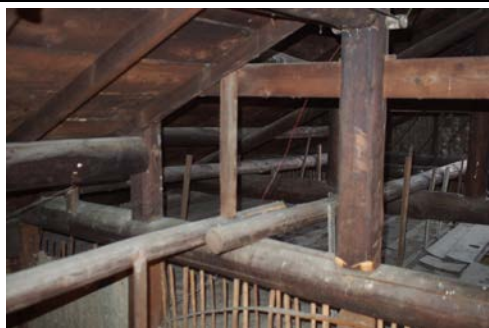
照片 4-1.25 屋架 3 現況照片 3
