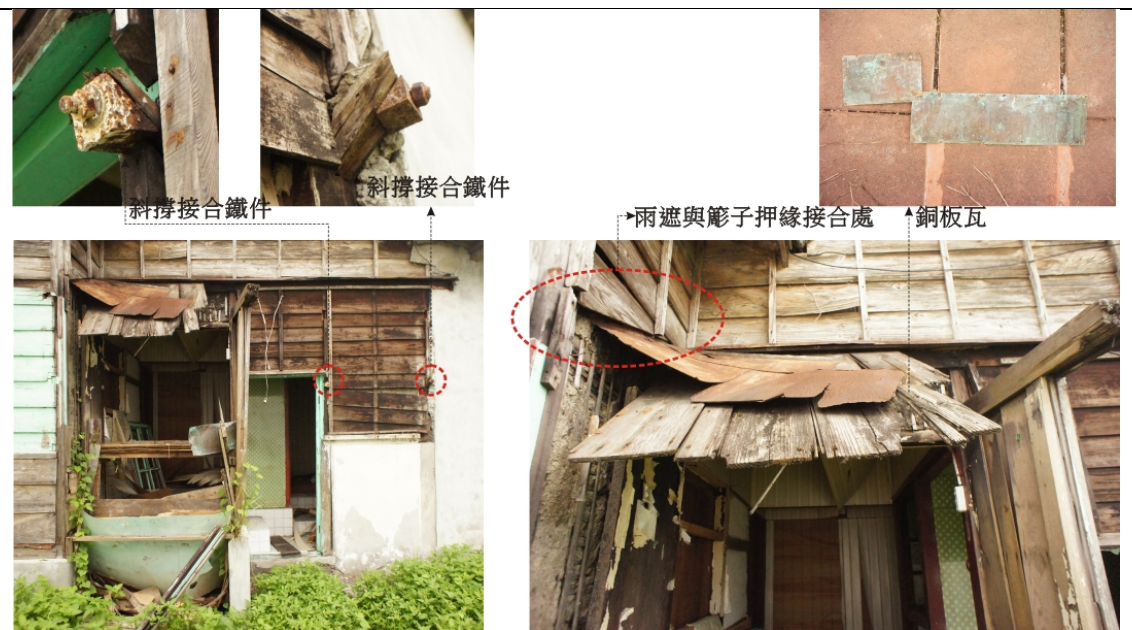
圖 3-1.24 雨遮斜撐與銅板瓦說明圖
