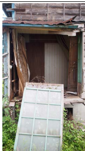
照片 4-2.33 W2 建具現況照片 1
