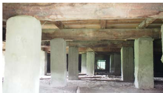
照片 3-3-4 束建床、布基礎現況照片
