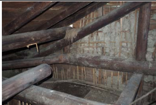
照片 4-1.13 屋架 1 現況照片 3
