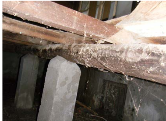
照片 4-1.8 床組現況照片 8
