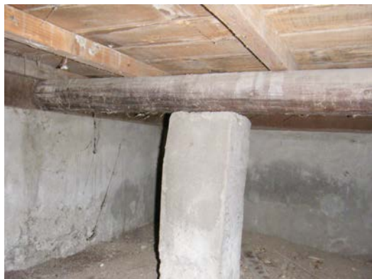
照片 4-1.3 床組現況照片 3
