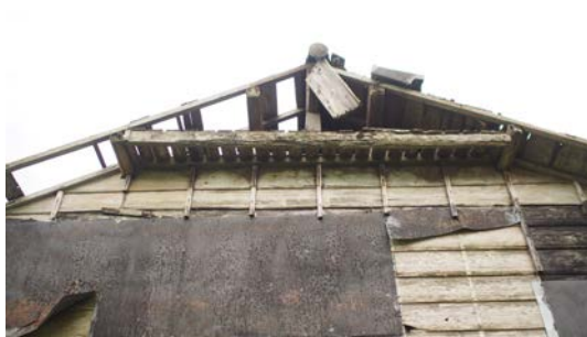
照片 4-1.47 軒先、破風現況照片 2
