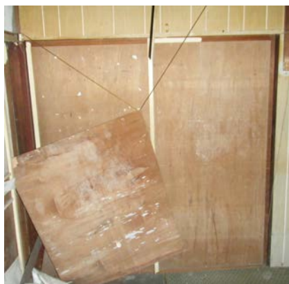
照片 4-2.10 D2 建具現況照片(由座敷側觀看)
