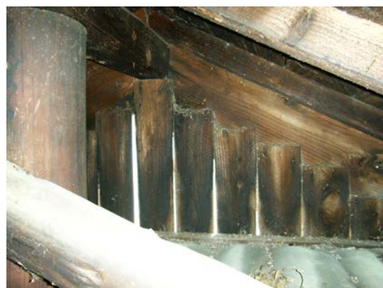
照片 4-1.48 軒先現況照片 1(由屋架內拍攝)
