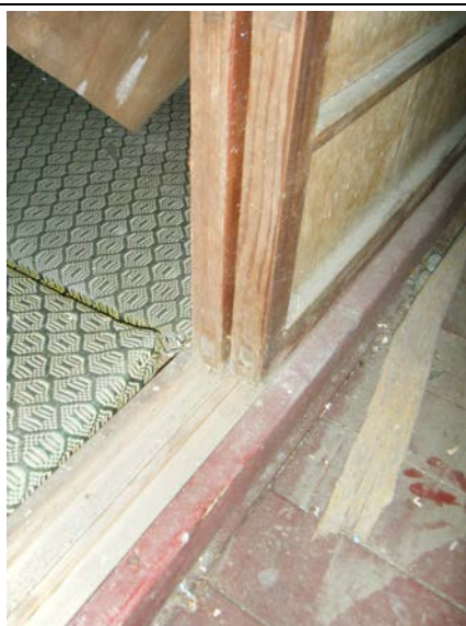
照片 4-2.11 D2 建具門框現況照片
