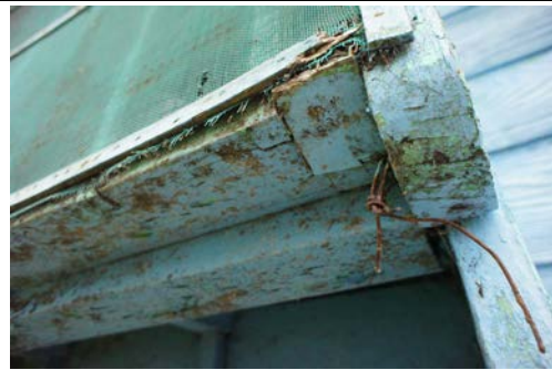
照片 4-2.31 W1 建具現況照片 5
