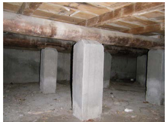
照片 4-1.4 床組現況照片 4
