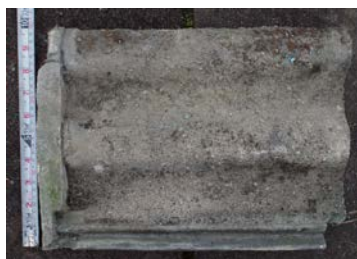
照片 4-1.44 水泥瓦現況照片 2
