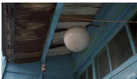
照片 4-2.8 D1 建具現況照片 8
