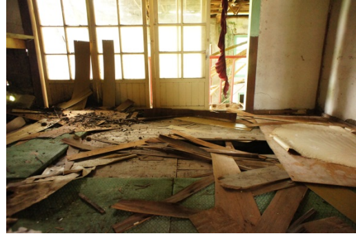
照片 4-3.4 空間 04 木地板與塌塌米現況
