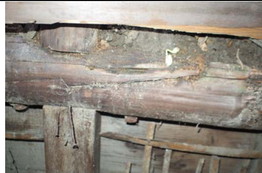
照片 4-1.16 屋架 1 現況照片 6
