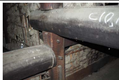
照片 4-1.34 屋架 4 現況照片 6
