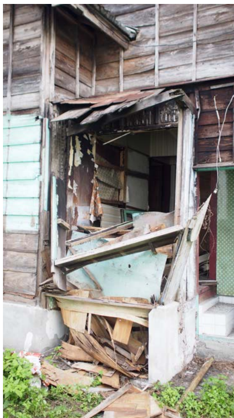
照片 4-2.36 W3 建具現況照片 1
