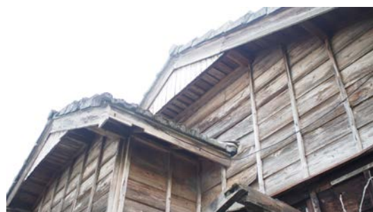
照片 4-1.46 軒先、破風現況照片 1
