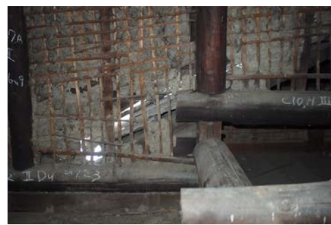
照片 4-1.30 屋架 4 現況照片 2
