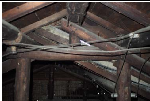
照片 4-1.23 屋架 3 現況照片 1
