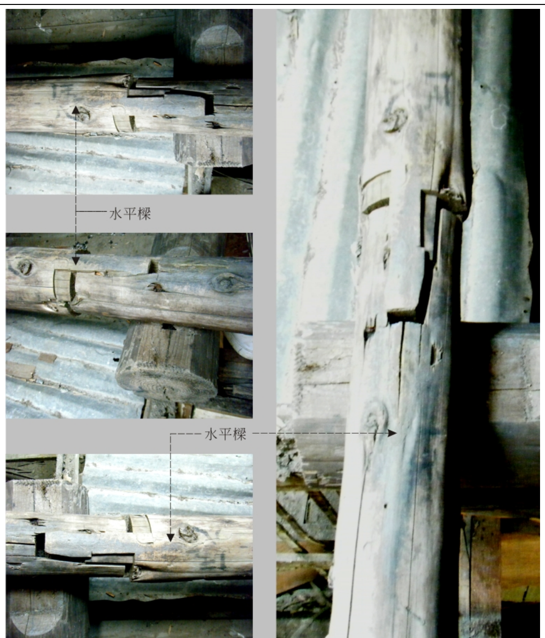
圖 4-4.5 水平樑銜接工法說明圖
