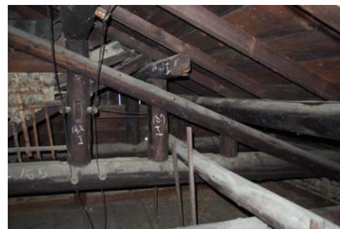
照片 4-1.32 屋架 4 現況照片 4
