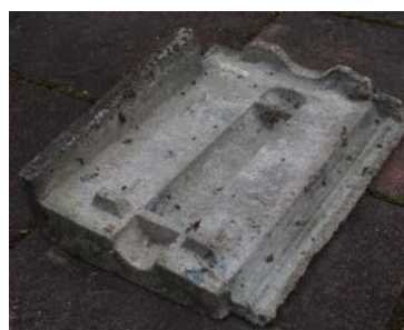
照片 4-1.41 角瓦現況照片 2
