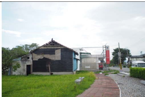
照片 3-2.1 周邊環境現況照片 1
