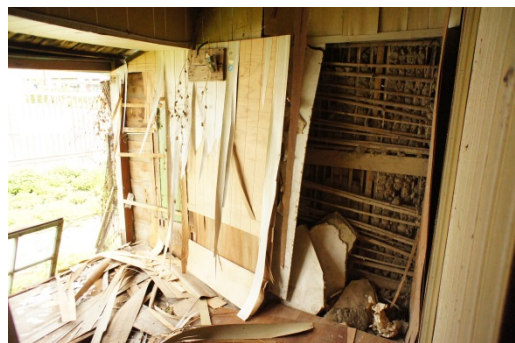
照片 4-3.9 空間 06 牆體真壁構造
