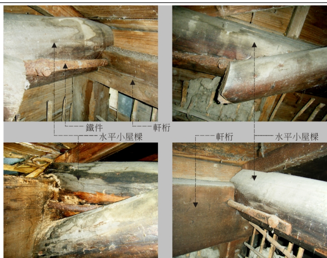
圖 4-4.8 水平小屋樑與軒桁銜接工法說明圖
