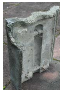
照片 4-1.42 角瓦現況照片 3
