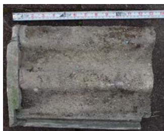
照片 4-1.43 水泥瓦現況照片 1
