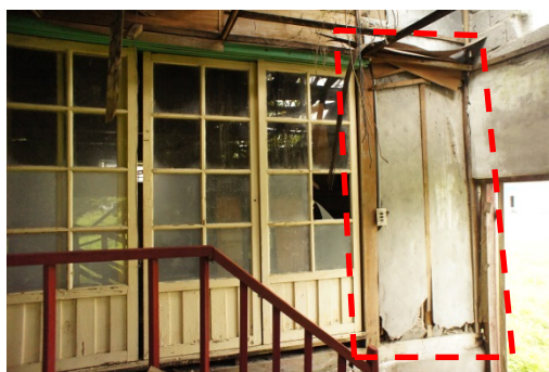
照片 4-3.12 空間 05 戶袋背牆真壁構造
