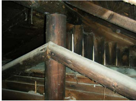
照片 4-1.35 屋架 4 現況照片 7
