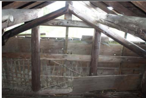
照片 4-1.11 屋架 1 現況照片 1
