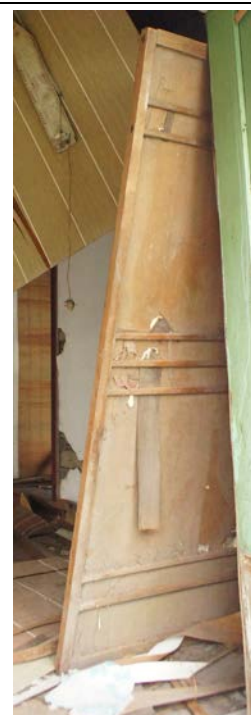
照片 4-2.24 D6 建具 現況照片
