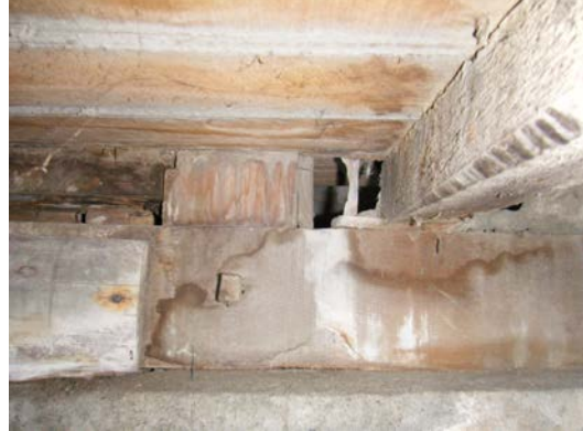
照片 4-1.6 床組現況照片 6
