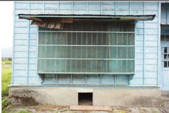
照片 4-2.28 W1 建具現況照片 2
