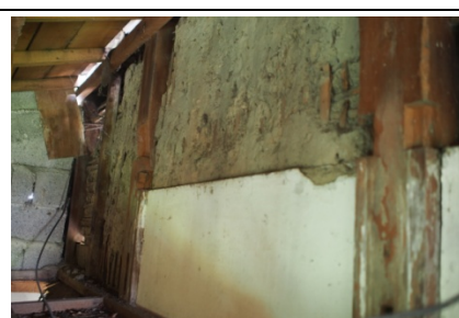
照片 3-1.3 便所壁體面飾材現況照片
