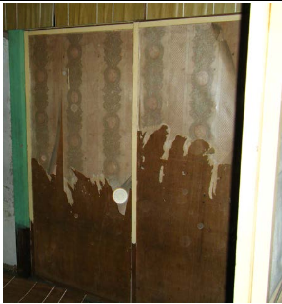
照片 4-2.12 D3 建具現況照片(由居間側觀看)
