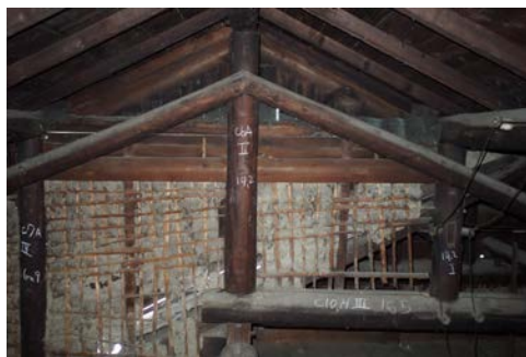
照片 4-1.29 屋架 4 現況照片 1
