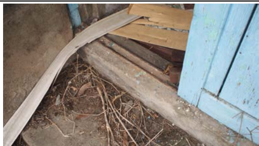
照片 4-2.5 D1 建具現況照片 5
