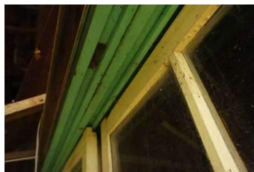
照片 4-2.19 D5 建具門框現況照片
