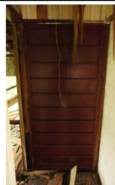
照片 3-1.1 便所建具現況照片
