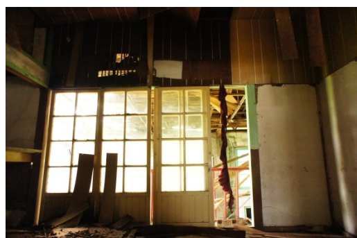
照片 4-3.13 空間 04 建具上方真壁構造
