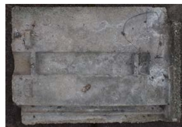
照片 4-1.45 水泥瓦現況照片 3
