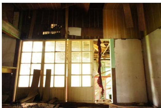
照片 4-2.16 D5 建具現況照片(由居間側觀看)
