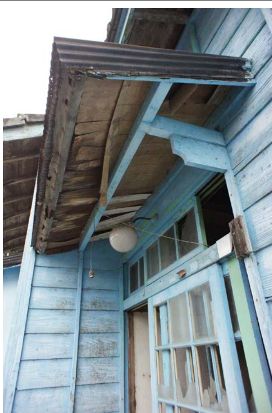
照片 4-2.4 D1 建具現況照片 4
