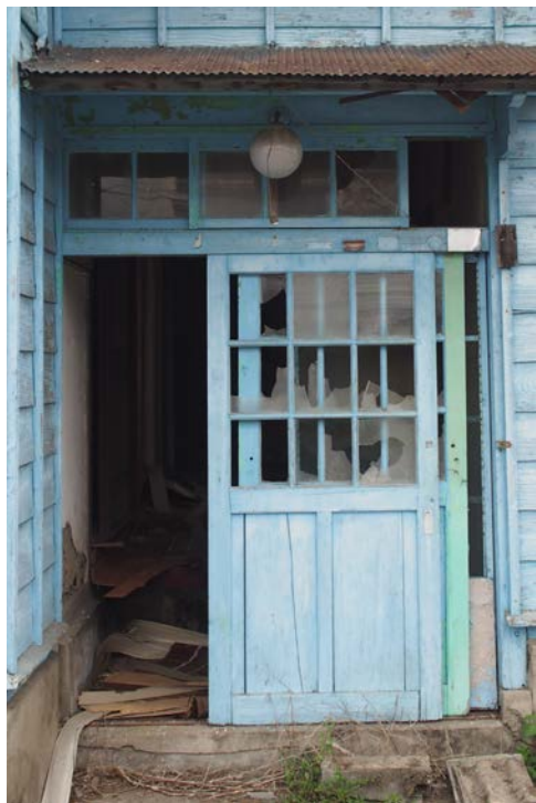
照片 4-2.1 D1 建具現況照片 1
