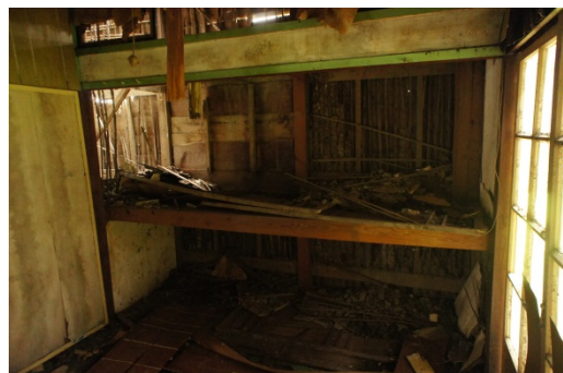
照片 4-3.7 空間 04 押入真壁構造
