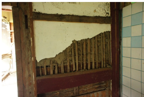
照片 4-3.10 空間 09 牆體白灰真壁構造
