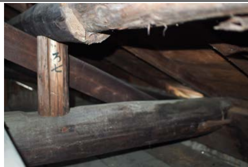
照片 4-1.22 屋架 2 現況照片 6
