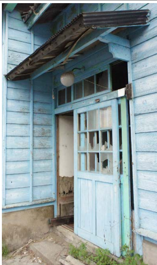
照片 4-2.3 D1 建具現況照片 3
