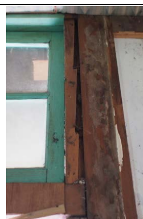
照片 3-1.2 雨淋板遺構現況照片
