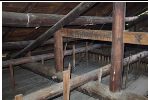
照片 4-1.21 屋架 2 現況照片 5
