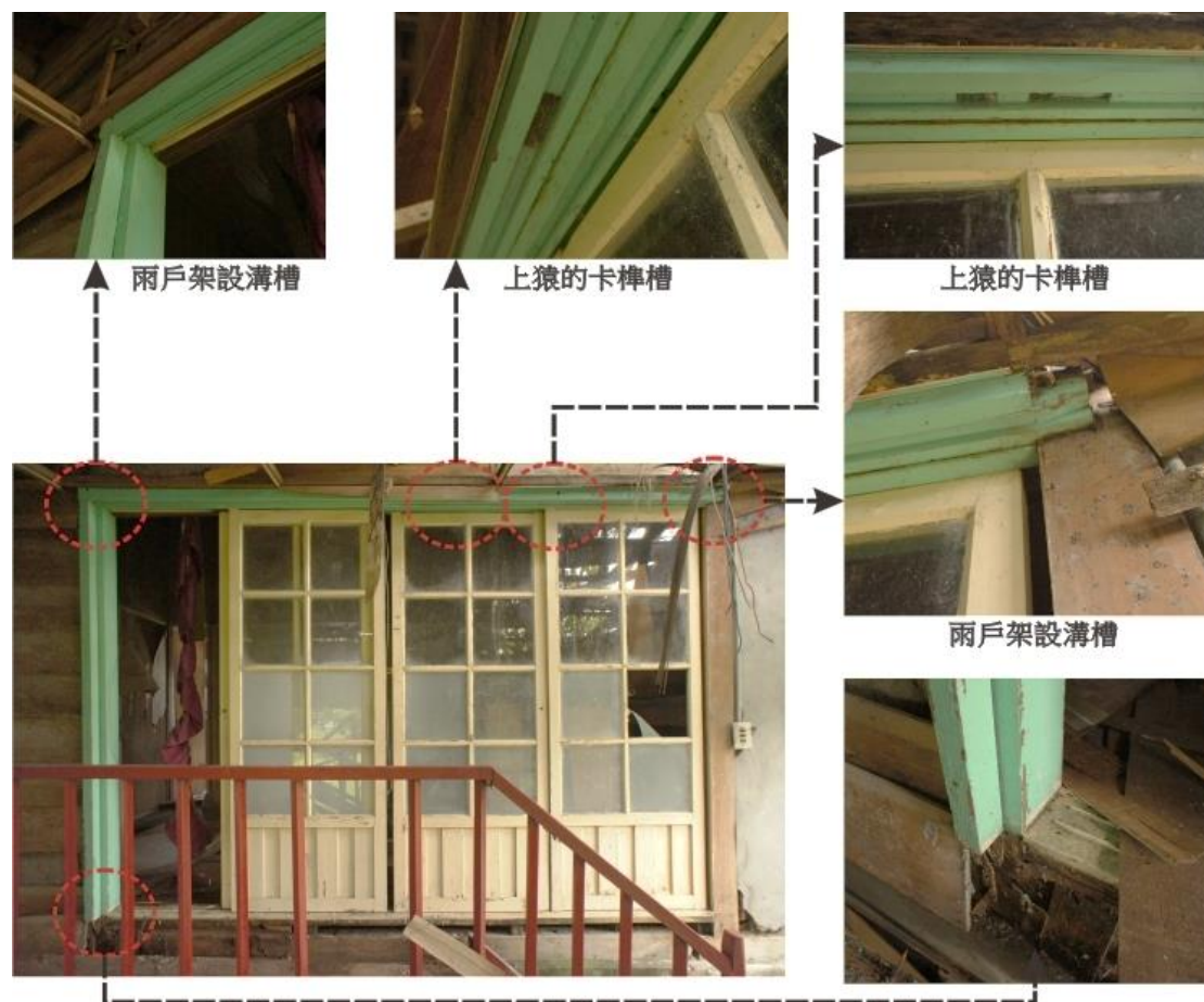
圖 3-1.19 兩戶架設溝槽說明圖
