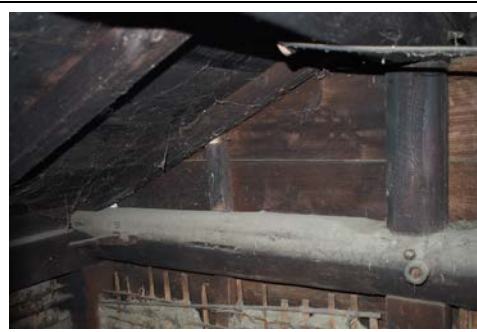
照片 4-1.38 屋架 5 現況照片 2
