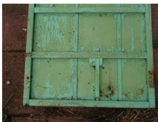
照片 4-2.21 D5'建具現況照片 2
