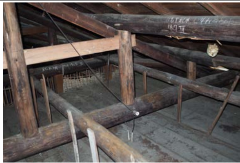
照片 4-1.19 屋架 2 現況照片 3
