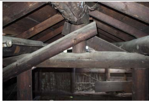
照片 4-1.20 屋架 2 現況照片 4
