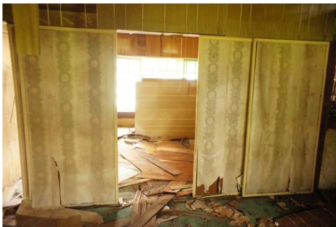
照片 4-2.15 D4 建具現況照片(由居間側觀看)
