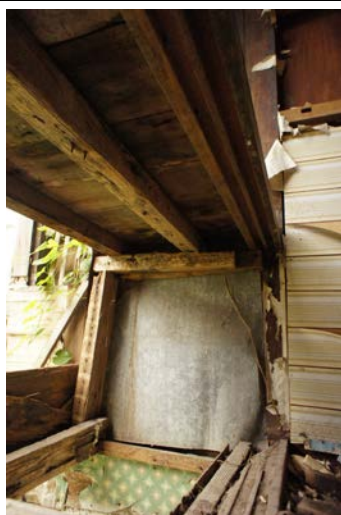
照片 4-2.39 W3 建具現況照片 2
