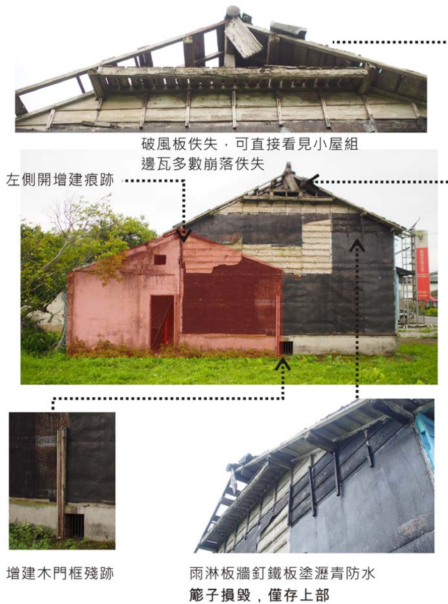
圖 5-2.11 左向立面損壞標示圖 本研究整理
