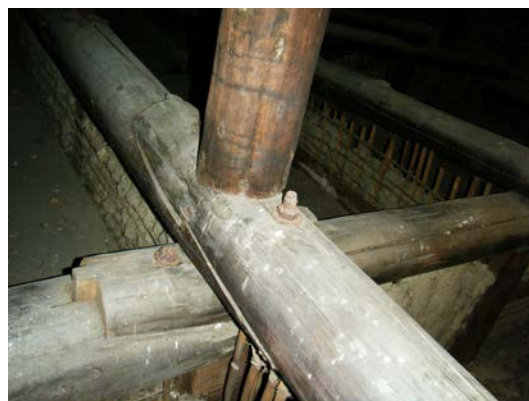
照片 7-3.6 屋架現況照片
