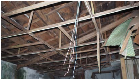
照片 5-02.115 增建空間屋頂現況
