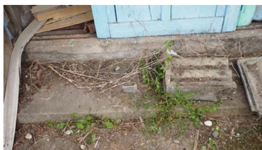
照片 5-2.5 入口踏階
