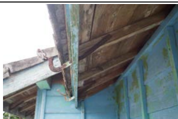
照片 7-3.11 屋頂排水系統現況照片
