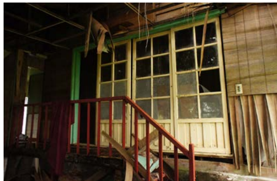
照片 5-2.102 緣側改建情形-3
