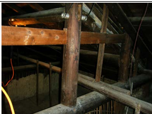
照片 5-2.50 短柱接樑轉換後母屋
