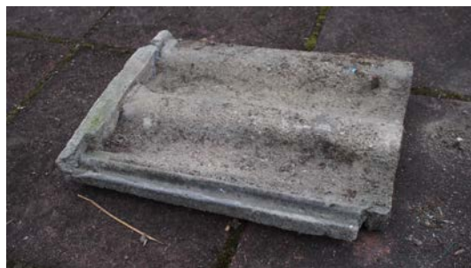
照片 7-3.2 水泥瓦照片
