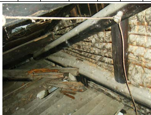
照片 5-2.59 疑似煙囪開口
