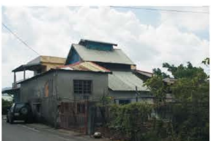
③ 菸樓建築3
