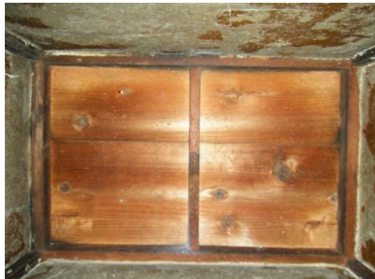
照片 5-2.112 櫃體天井板
