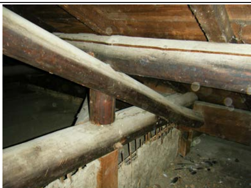
照片 5-2.46 禽類羽毛散落與母屋劈裂
