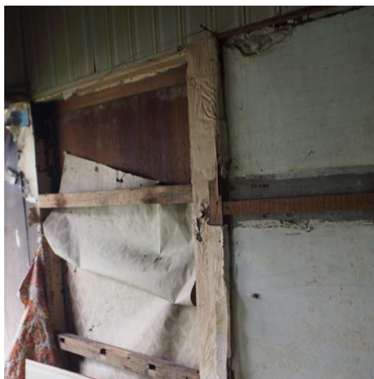
照片 5-2.105 廊間與茶之間連結門扇之情形
