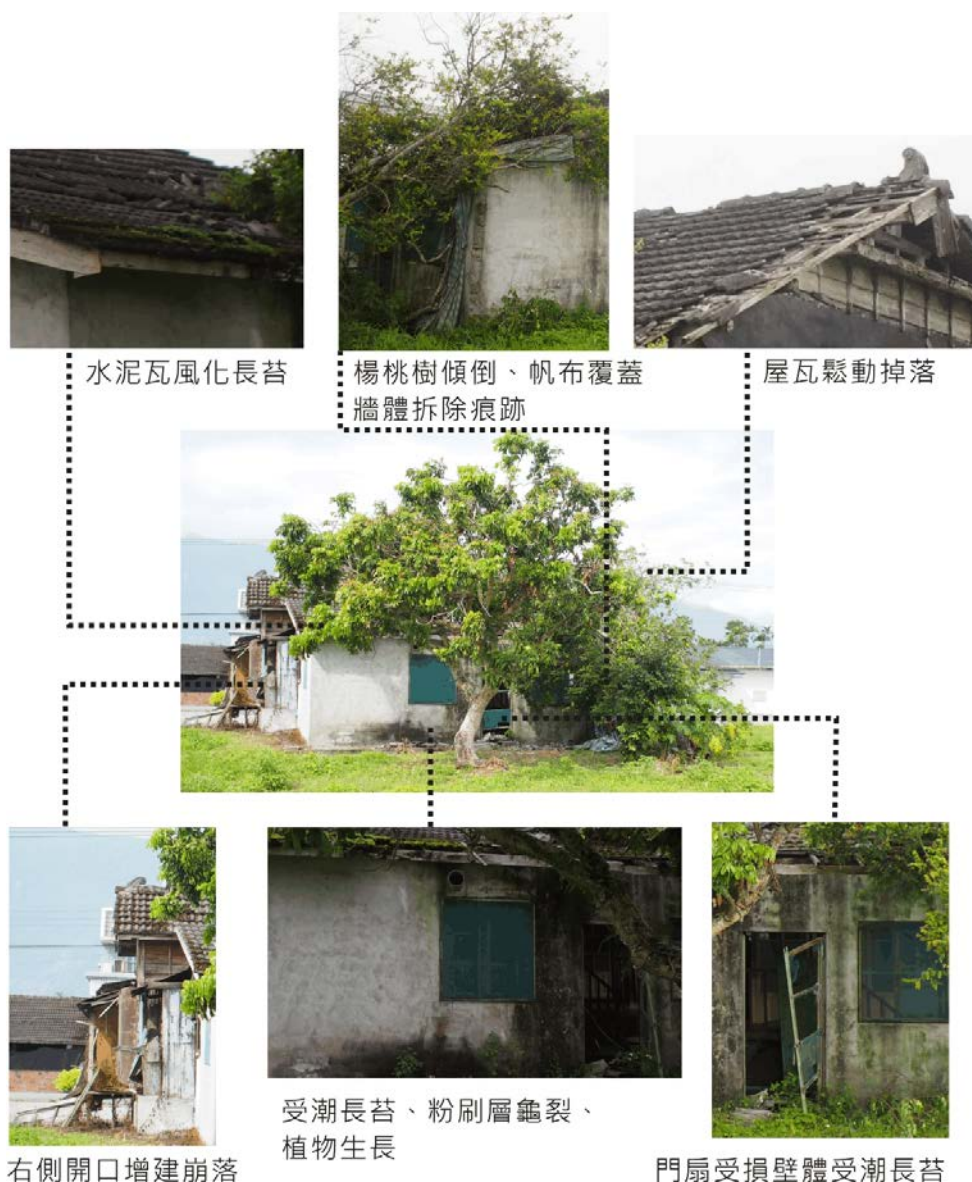
圖 5-2.7 背向立面損壞標示圖 本研究整理
