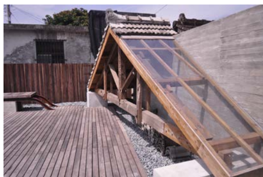
照片 6-4.2 豐田村移民指導所事務室舊屋架結合戶外舞臺之展示現況照片
