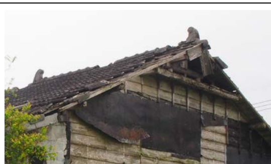
照片 7-3.1 屋檐現況照片
