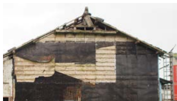
照片 7-3.8 北側立面現況照片
