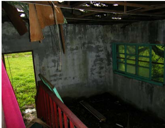
照片 5-2.117 粉刷層長苔龜裂
