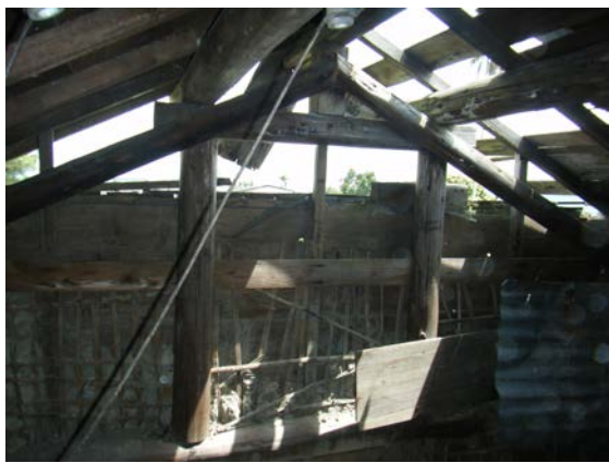
照片 5-2.20 屋組 T1 屋架外露情形
