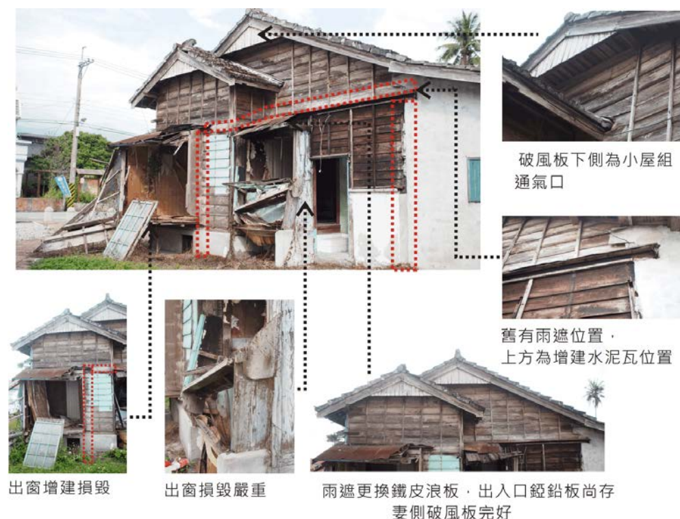
圖 5-2.9 右向立面損壞標示圖 本研究整理
