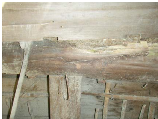
照片 5-2.23 水平屋樑搭接處長苔蟲蟻排遺
