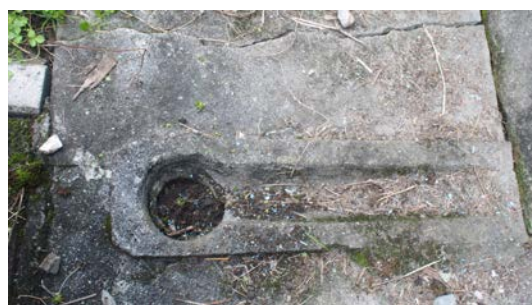
照片 5-2.6 落水頭洩水位置與暗溝
