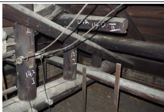
照片 5-2.61 屋坡轉換搭接情形-1
