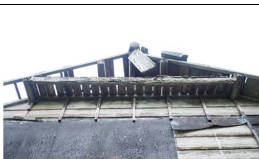
照片 7-3.4 破風現況照片
