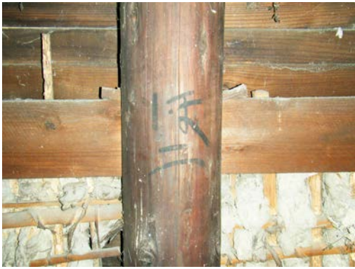
照片 5-2.62 V1 短柱原構件編號ほ二
