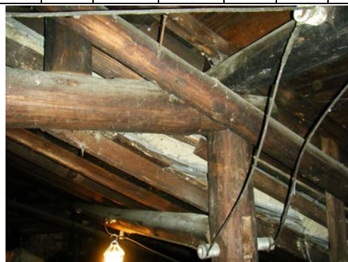
照片 5-2.43 短柱 V3 接樑情形
