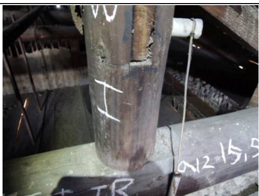
照片 5-2.54 V5 短柱有蟲蟲危害。
