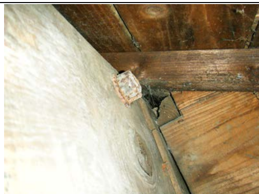
照片 5-2.45 水平樑與軒桁魚尾螺栓固定情形
