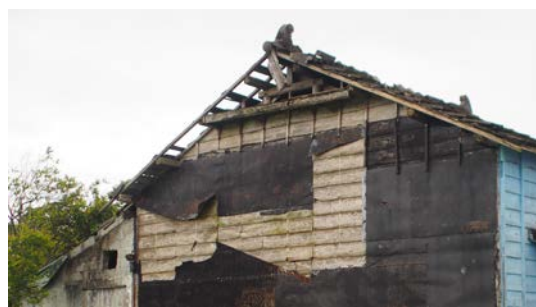
照片 5-2.17 左側立面屋瓦破損情形
