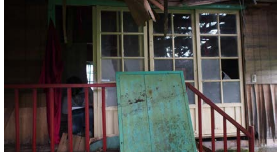
照片 5-2.116 與空間緣側空間照片
