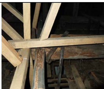
照片 7-3.19 支撐施工示意圖
