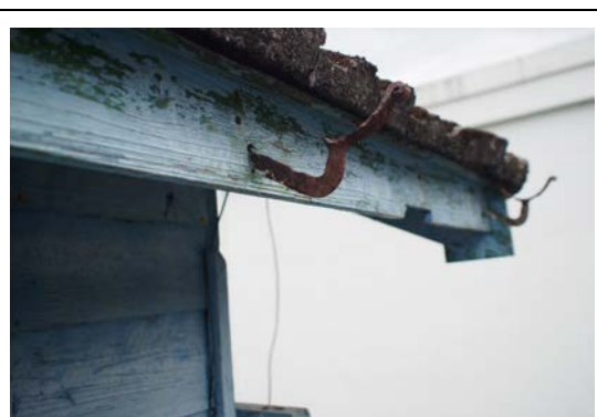
照片 7-3.3 軒先現況照片
