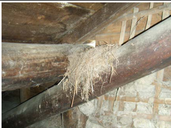
照片 5-2.24 木構件間築巢情形
