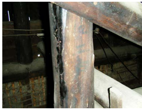
照片 5-2.63 V5 短柱滲油編號不易辨識
