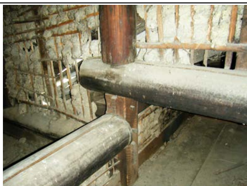
照片 5-2.60 屋坡轉換搭接情形-1
