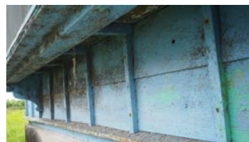
照片 7-3.7 簷子押緣現況照片
