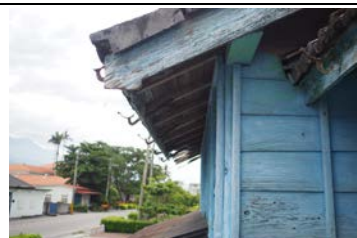
照片 7-3.10 屋頂排水系統現況照片
