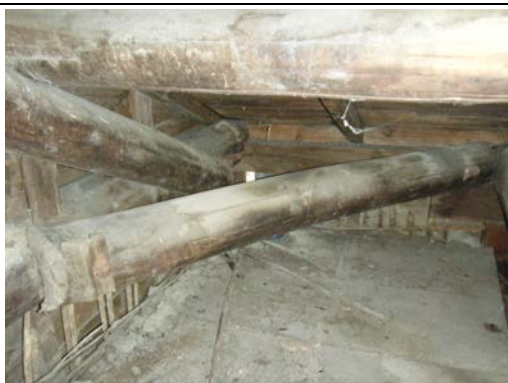
照片 5-2.26 火打樑 H2' 與各構件情形
