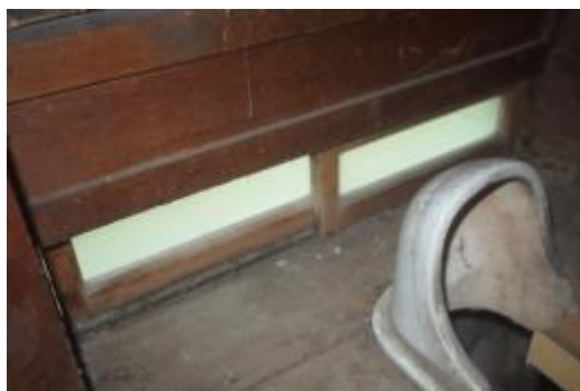
照片 4-2.32 W3 建具現況照片 2
