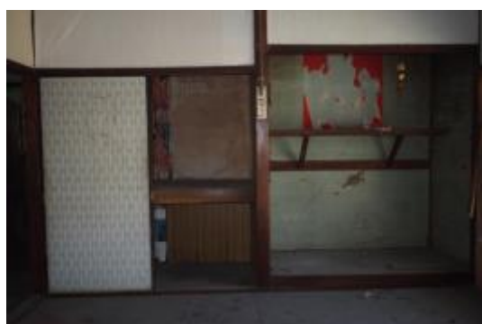
照片 4-2.47 A-1 棟建築物床之間現況照片
