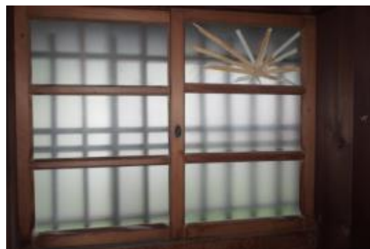
照片 4-2.33 W2 建具現況照片
