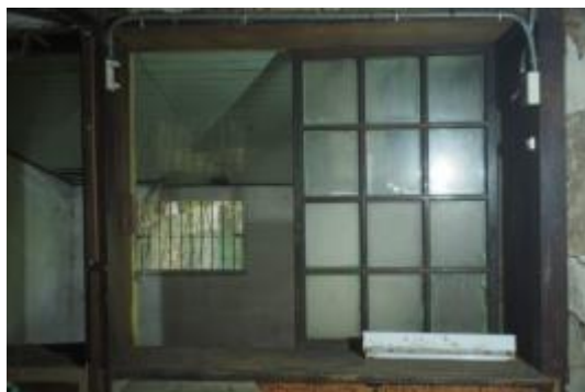
照片 4-2.40 W7 建具現況照片
