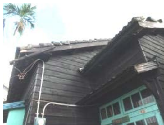
照片 4-1.26 B 幢下見板張現況照片 1
