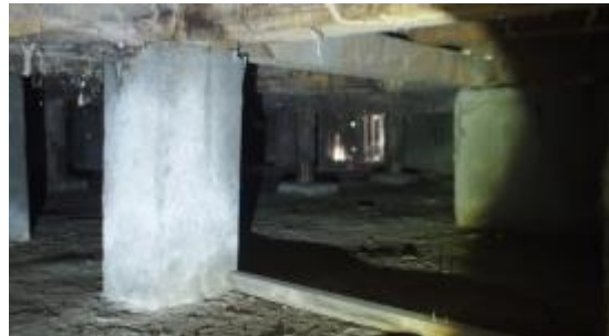
照片 4-1.2 A 幢建築物束建床現況照片 2
