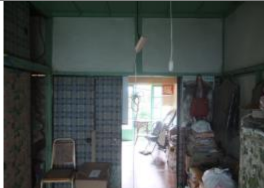
照片 4-3.74 空間 B-2-04 襖上方之真壁現況
