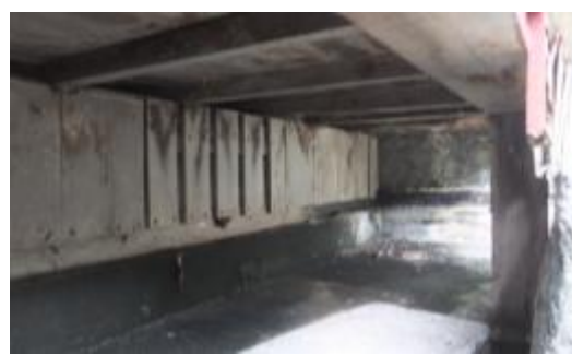
照片 4-1.21 B 幢建築物布基礎通氣窗現況照片 2
