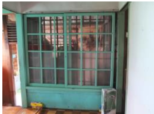
照片 4-2.93 W1 建具現況照片 1
