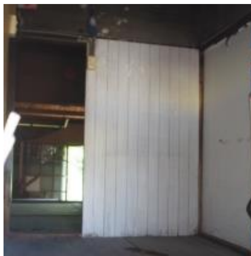
照片 4-2.10 D5 建具現況照片
