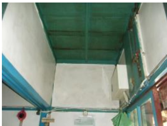
照片 4-3.69 空間 B-1-06 緣側上方真壁構造
