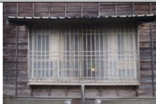
照片 4-2.25 W1 建具現況照片 1
