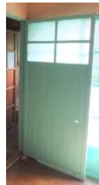
照片 4-2.81 D9 建具 現況照片 2
