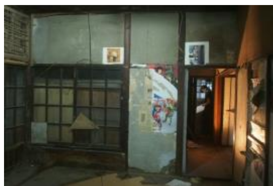
照片 4-3.12 空間 A-1-07 牆體白灰真壁構造
