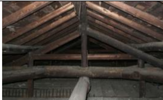
照片 3-3.2 A 幢建築物屋架現況照片
