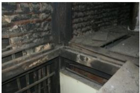
照片 4-1.13 A 幢真壁構造現況照片 3
