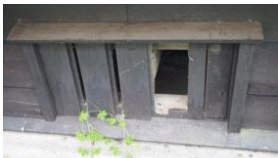
照片 4-1.20 B 幢建築物布基礎通氣窗現況照片 1
