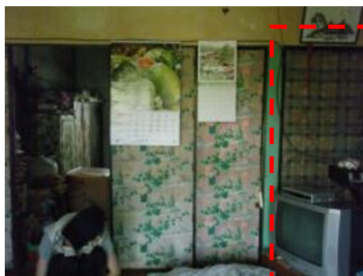
照片 4-3.72 空間 B-2-05 押入真壁壁體更改為門扇
