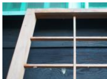
照片 4-2.87 D11 建具現況照片 1
