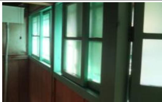
照片 4-2.107 W5 建具現況照片 2
