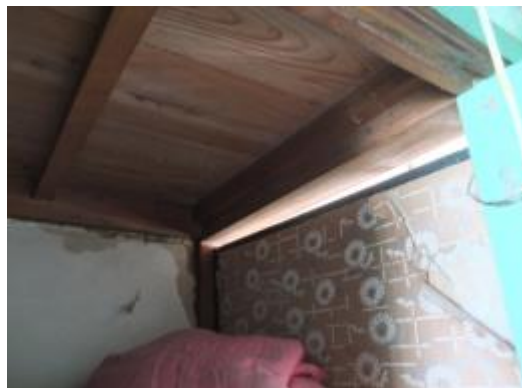
照片 4-2.75 D7 建具現況照片 3
