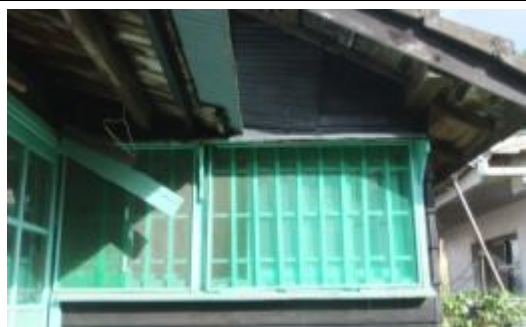
照片 4-2.106 W5 建具現況照片 1
