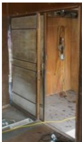
照片 4-2.11 D6 建具現況照片 1
