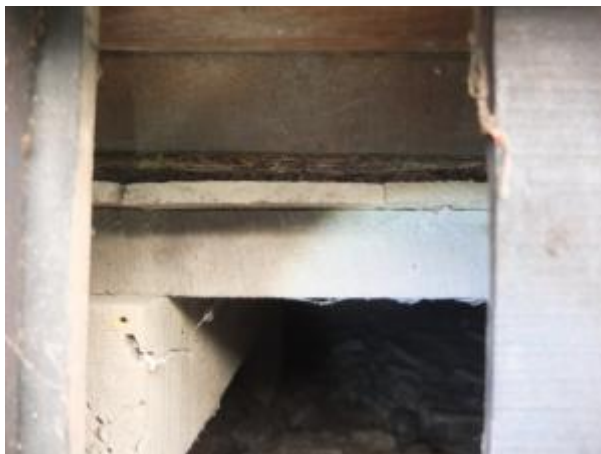
照片 4-1.23 B 幢建築物床組現況照片 2
