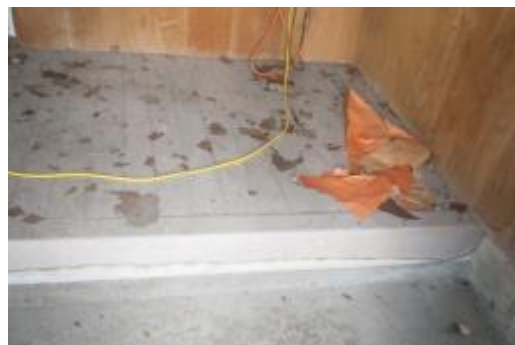
照片 4-3.2 空間 A-2-01、A-2-02 地坪現況
