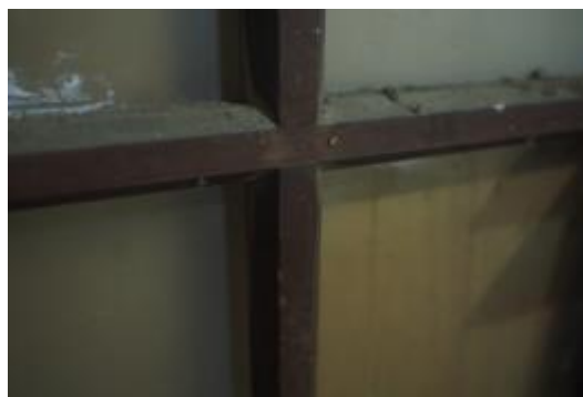
照片 4-2.39 W6 建具現況照片 2
