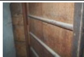
照片 4-2.20 D9 建具現況照片 2
