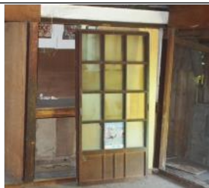
照片 4-2.22 D11 建具現況照片
