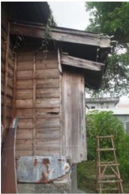
照片 4-1.15 A 幢建築物屋簷現況照片
