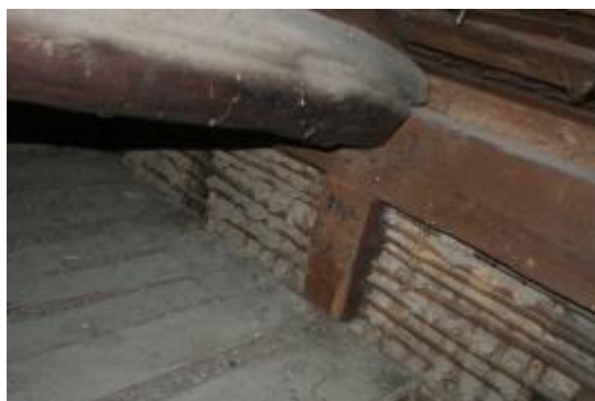
照片4-3.50 50號宿舍座敷空間押入墨字
