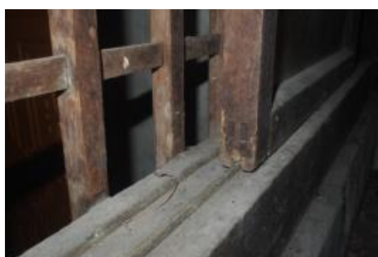
照片 4-2.42 W8 建具現況照片 2
