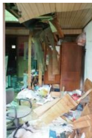
照片 3-2.1 A-2 棟建築物炊事場現況照片
