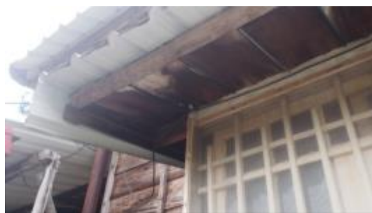
照片 4-2.26 W1 建具現況照片 2
