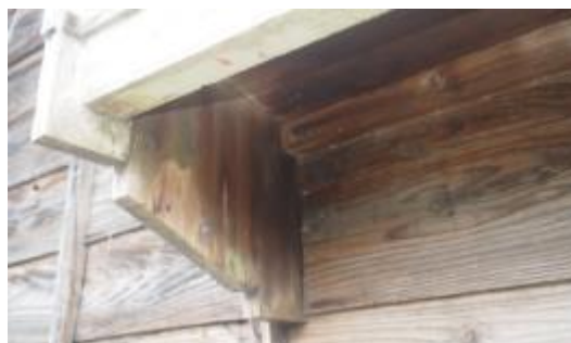
照片 4-2.27 W1 建具現況照片 3
