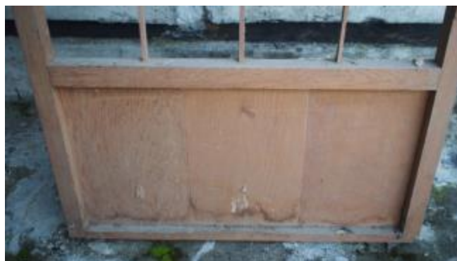
照片 4-2.90 D11 建具現況照片 4
