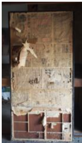
照片 4-2.17 D8 建具現況 照片 1
