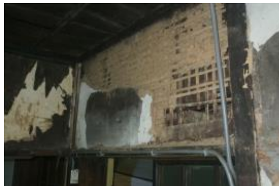
照片 4-3.14 空間 A-1-09 窗台上真壁構造
