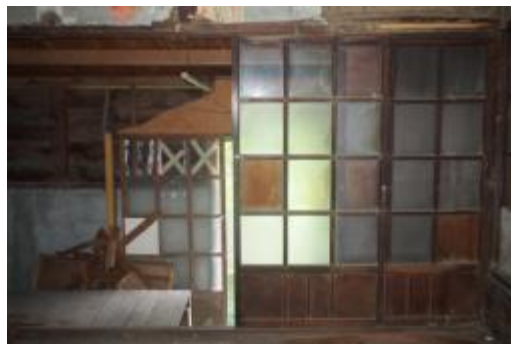
照片 4-2.7 D3 建具現況照片 1
