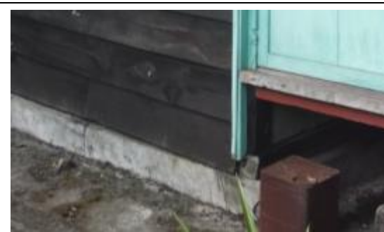
照片 4-1.19 B 幢建築物布基礎現況照片 2
