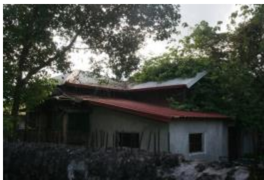
照片 4-3.28 A 幢 50 號宿舍原束更換為鐵皮
