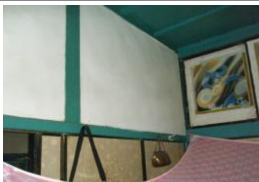
照片 4-3.73 空間 B-1-04 襖上方之真壁現況
