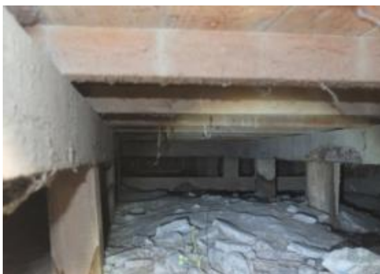
照片 4-1.17 B 幢建築物束建床現況照片 2
