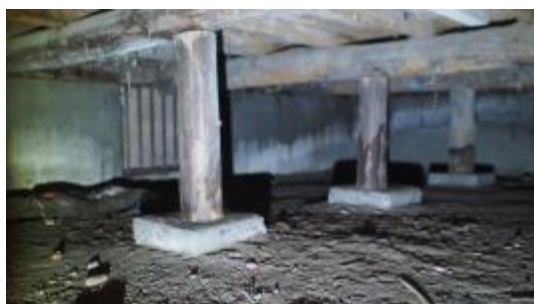
照片 4-1.1 A 幢建築物束建床現況照片 1
