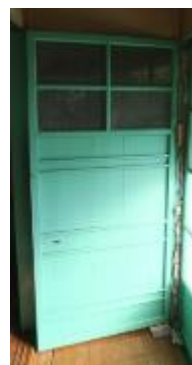
照片 4-2.80 D9 建具現況照片 1
