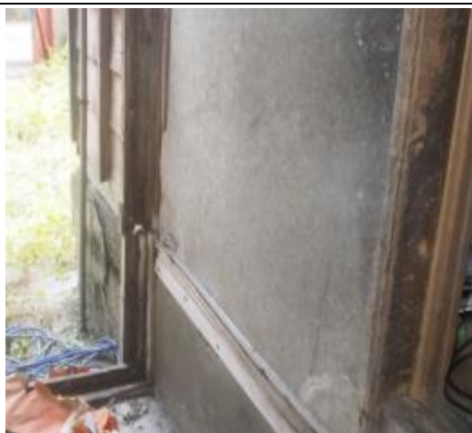
照片 4-3.9 空間 A-1-01 踏進真壁構造
