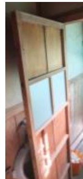
照片 4-2.79 D8 建具 現況照片 2
