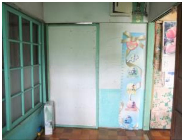
照片 4-2.62 D2 建具現況照片 2
