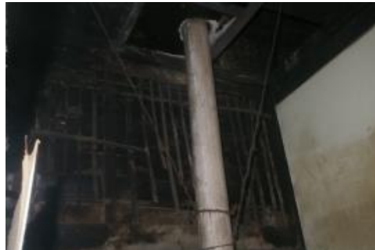
照片 4-3.16 空間 A-1-11 風呂出入口上方真壁構造
