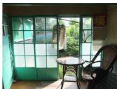
照片 4-2.82 D10 建具現況照片 1
