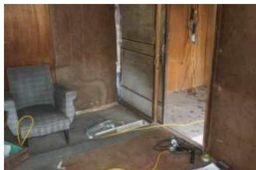
照片 4-3.8 空間 A-2-03 座敷木地板上覆榻榻米
