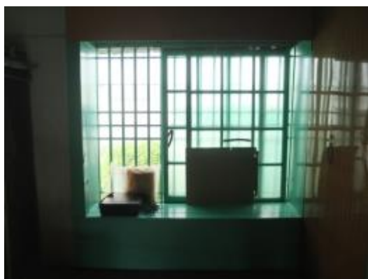
照片 4-2.97 W2 建具現況照片 2
