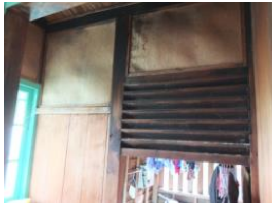
照片 4-2.92 D13 建具現況照片 2
