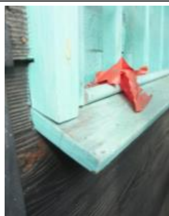
照片 4-2.117 W7 建具現況照片 3
