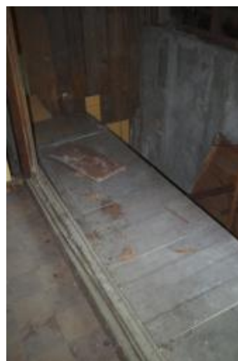
照片 4-2.46 A-1 棟建築物濡緣現況照片
