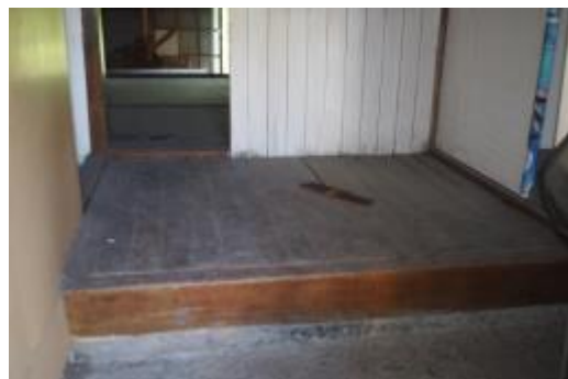
照片 4-3.1 空間 A-1-01、A-1-02 地坪現況
