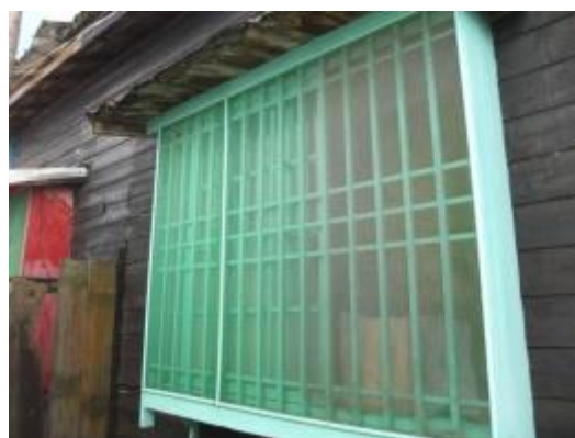
照片 4-2.96 W2 建具現況照片 1
