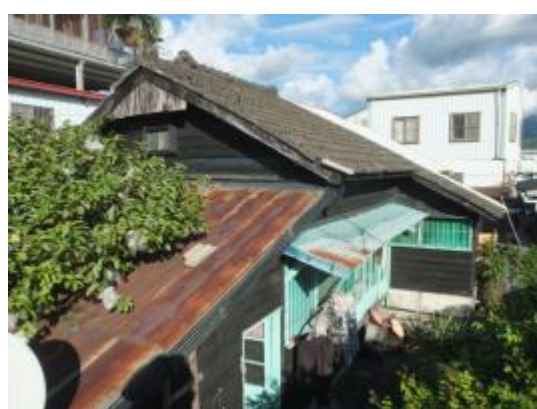
照片 4-1.28 B 幢建築物屋頂現況照片 1
