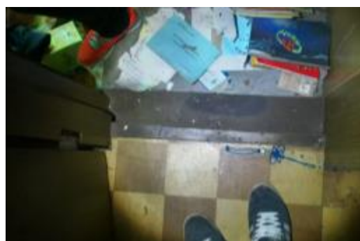
照片 4-3.4 空間 A-2-05 居間為夾板木地板
