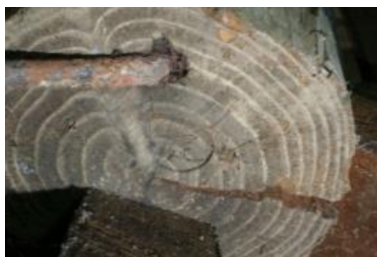
照片 4-3.36 棟木 X6-1 構件刻劃情形
