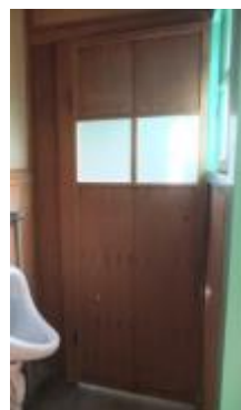
照片 4-2.78 D8 建具 現況照片 1
