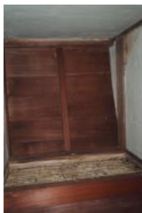
照片 4-2.52 A-1 棟建築物便所天井現況照片
