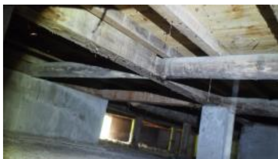
照片 4-1.7 A 幢建築物床組現況照片 1
