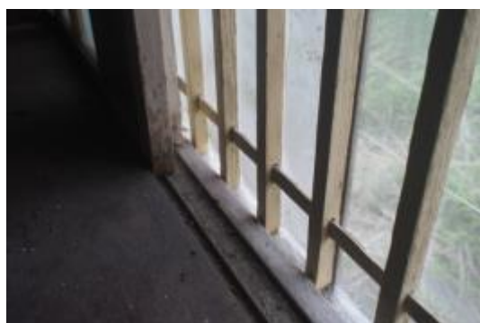
照片 4-2.28 W1 建具現況照片 4
