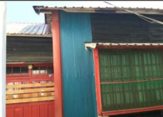
照片 4-3.75 外牆雨淋板局部更換鐵皮
