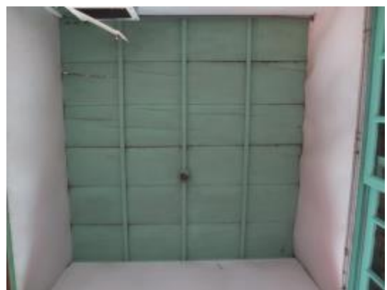
照片 4-2.121 B2 戶建築物茶之間天井現況照片
