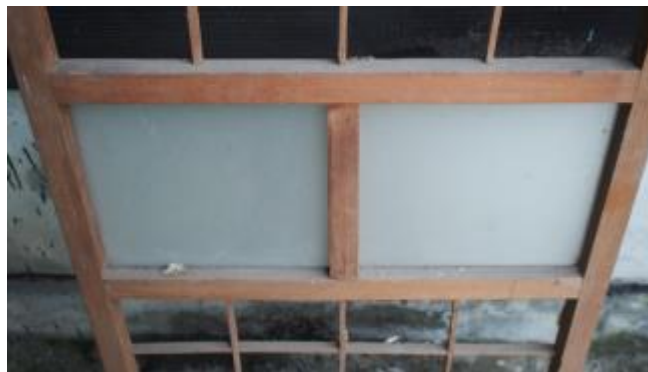
照片 4-2.89 D11 建具現況照片 3
