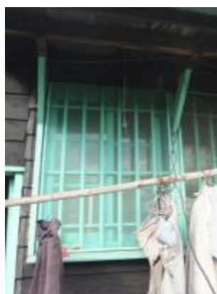
照片 4-2.116 W7 建具現況 照片 2
