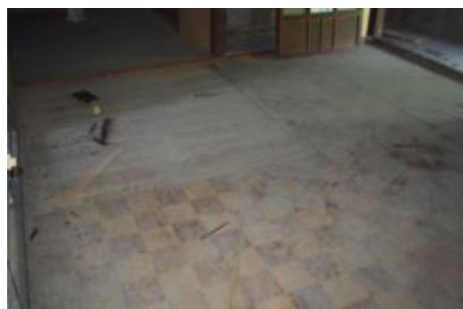
照片 4-3.3 空間 A-1-07 居間木地板上覆木作夾板
