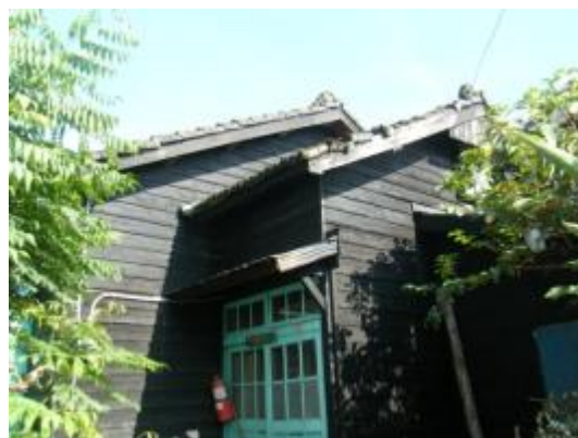
照片 3-3.4 B 幢建築物外觀現況照片 2
