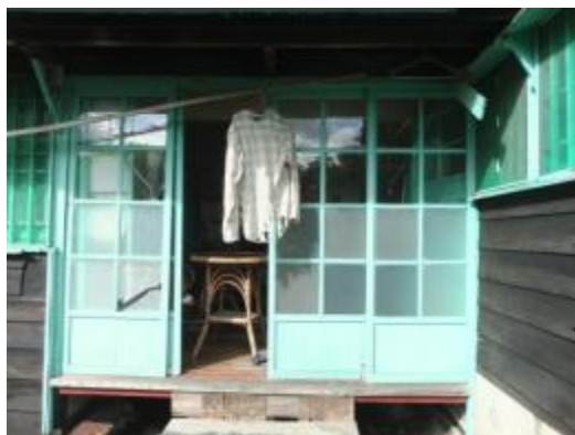
照片 4-2.85 D10 建具現況照片 4
