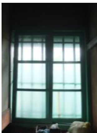
照片 4-2.115 W7 建具現況照片 1
