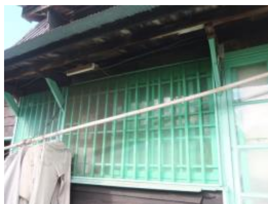
照片 4-2.110 W5 建具現況照片 1
