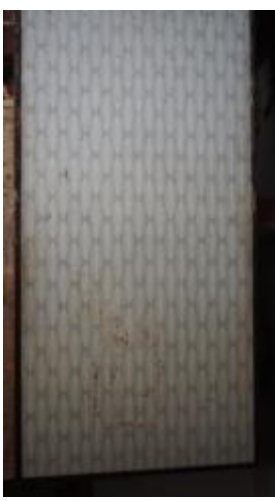
照片 4-2.18 D8 建具現況 照片 2
