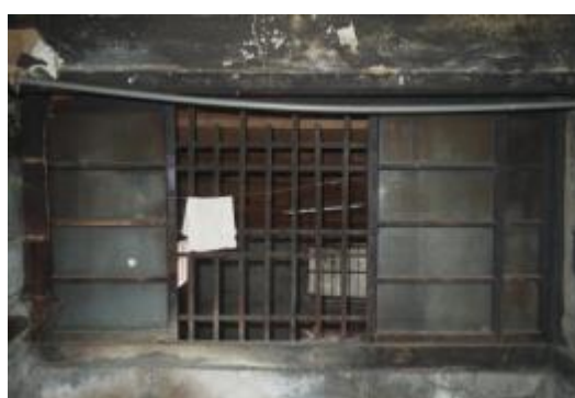
照片 4-2.43 W8 建具現況照片 3
