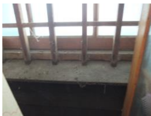
照片 4-2.95 W1 建具現況照片 3
