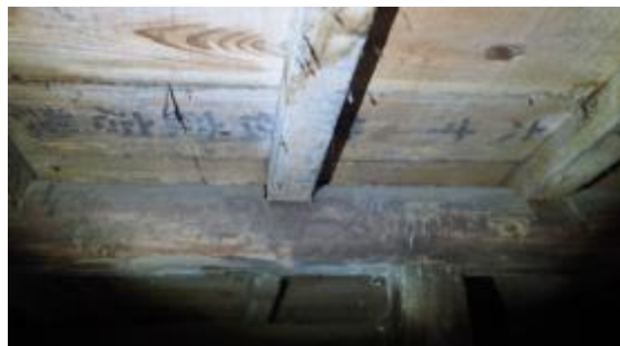
照片 4-1.8 A 幢建築物床組現況照片 2
