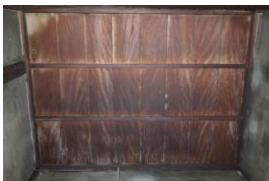
照片 4-2.49 A-1 棟建築物玄關天井現況照片
