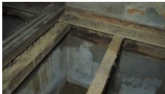
照片 4-1.4 A 幢建築物布基礎現況照片 2
