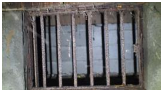
照片 4-1.6 A 幢建築物通氣口現況照片
