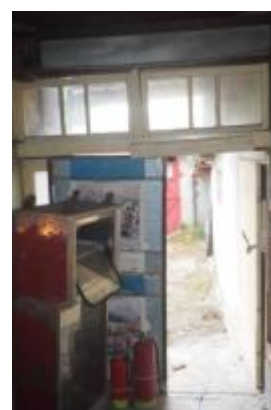
照片 4-2.2 D1 建具現況 照片(內側)
