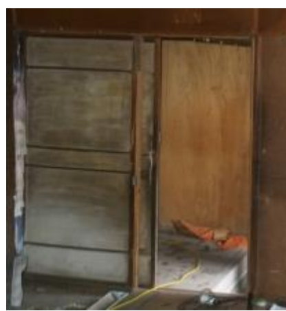
照片 4-2.13 D6 建具現況照片 3
