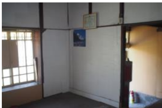
照片 4-1.11 A 幢真壁構造現況照片 1
