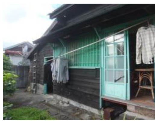
照片 4-1.27 B 幢下見板張現況照片 2
