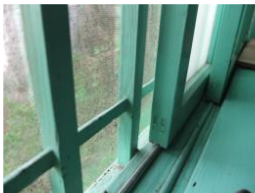
照片 4-2.98 W2 建具現況照片 3
