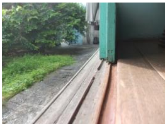
照片 4-2.83 D10 建具現況照片 2
