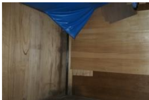
照片 4-2.14 D7 建具現況照片 1
