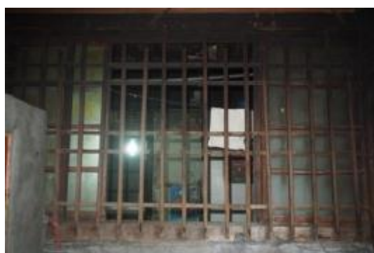
照片 4-2.41 W8 建具現況照片 1
