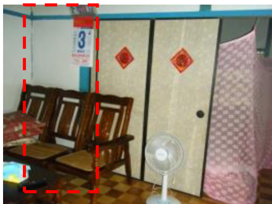
照片 4-3.71 空間 B-1-05 押入真壁壁體
