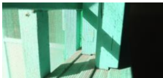
照片 4-2.108 W5 建具現況照片 3
