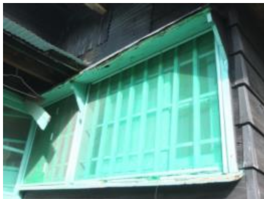
照片 4-2.104 W4 建具現況照片 1
