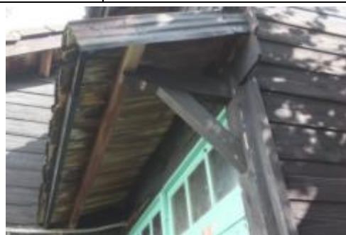
照片 4-2.60 D1 建具現況照片 2
