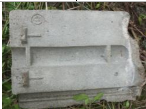
照片 4-3.23 水泥瓦背面
