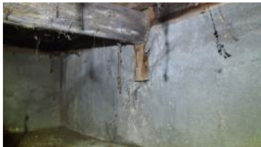
照片 4-1.3 A 幢建築物布基礎現況照片 1
