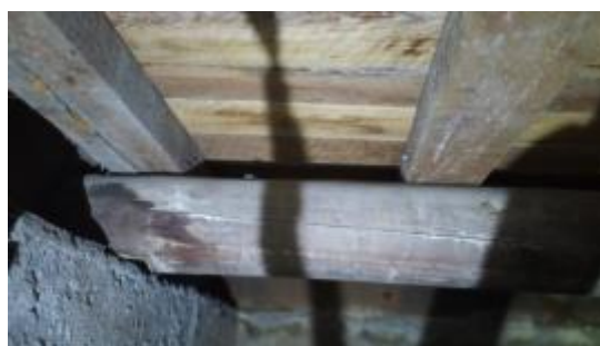
照片 4-1.10 A 幢建築物床組現況照片 4
