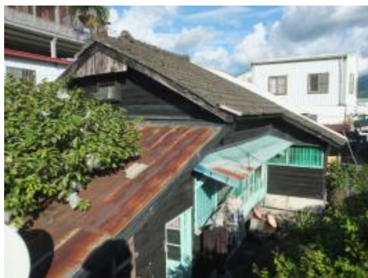
照片 3-3.3 B 幢建築物外觀現況照片 1
