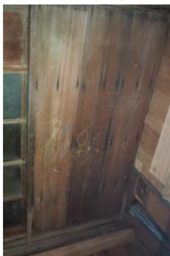
照片 4-2.45 A-1 棟建築物戶袋現況照片
