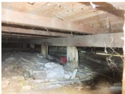
照片 4-1.16 B 幢建築物束建床現況照片 1
