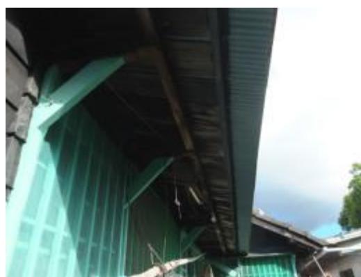
照片 4-2.112 W6 建具現況照片 3
