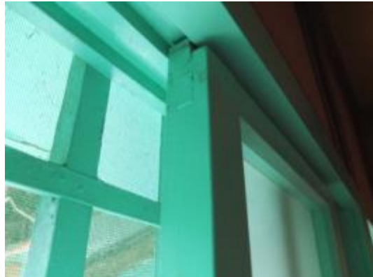
照片 4-2.105 W4 建具現況照片 2
