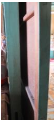
照片 4-2.61 D2 建具現況照片 1
