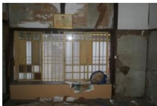
照片 4-3.11 空間 A-1-03 牆體真壁構造
