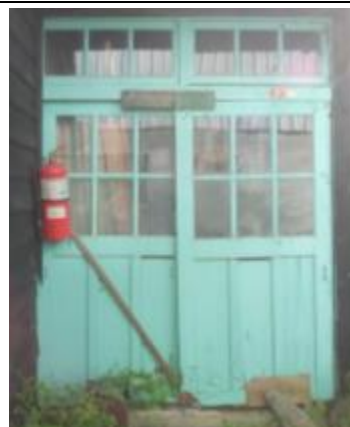
照片 4-2.58 D1 建具現況照片(外側)
