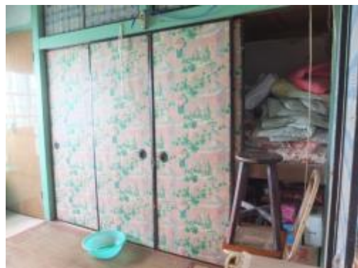
照片 4-2.73 D7 建具現況照片 1
