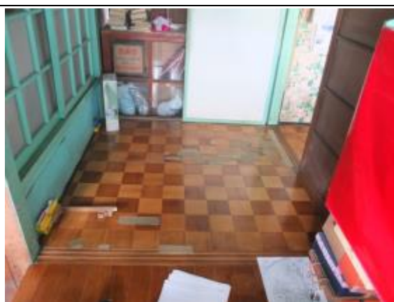
照片 4-3.62 空間 B-2-02 夾板木地板現況
