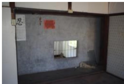
照片 4-2.15 D7 建具現況照片
