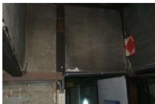
照片 4-3.15 空間 A-1-02 建具上方真壁構造
