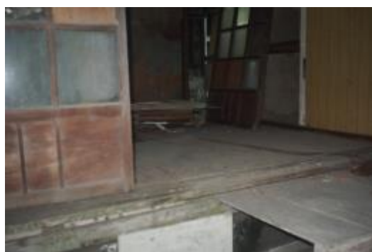
照片 4-2.8 D3 建具現況照片 2
