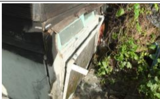
照片 4-1.18 B 幢建築物布基礎現況照片 1
