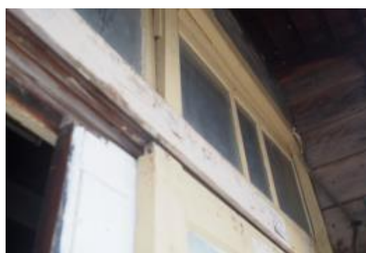
照片 4-2.4 D1 建具現況照片 2
