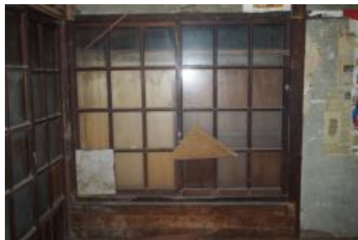
照片 4-2.38 W6 建具現況照片 1
