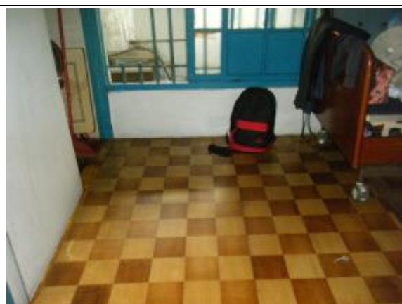
照片 4-3.61 空間 B-1-02 夾板木地板現況
