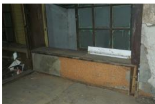
照片 4-3.13 空間 A-1-09 窗台下真壁構造
