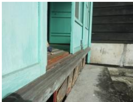
照片 4-2.86 D10 建具現況照片 5
