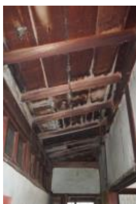
照片 4-2.51 A-1 棟建築物緣側天井現況照片
