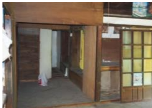
照片 4-2.23 D12 建具現況照片
