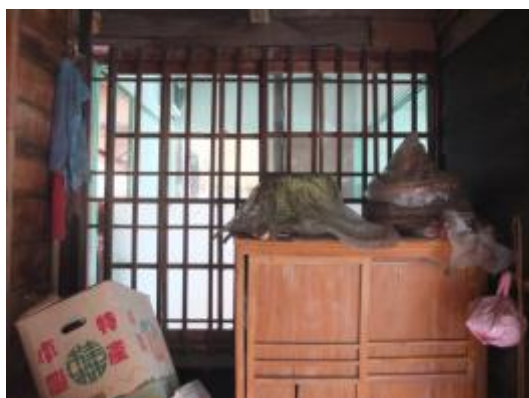
照片 4-2.94 W1 建具現況照片 2
