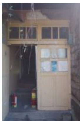
照片 4-2.1 D1 建具現況 照片(外側)
