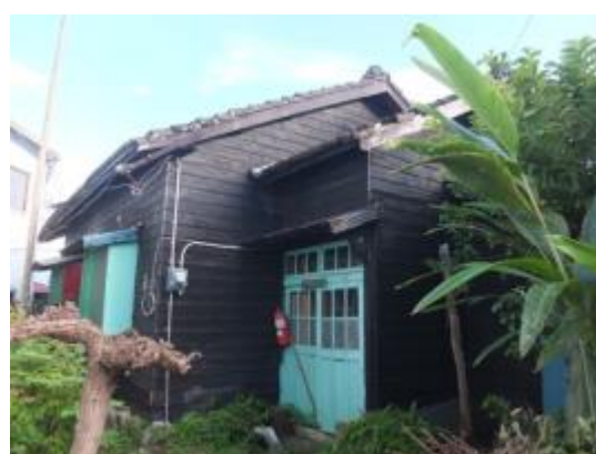
照片 4-1.29 B 幢建築物屋頂現況照片 2
