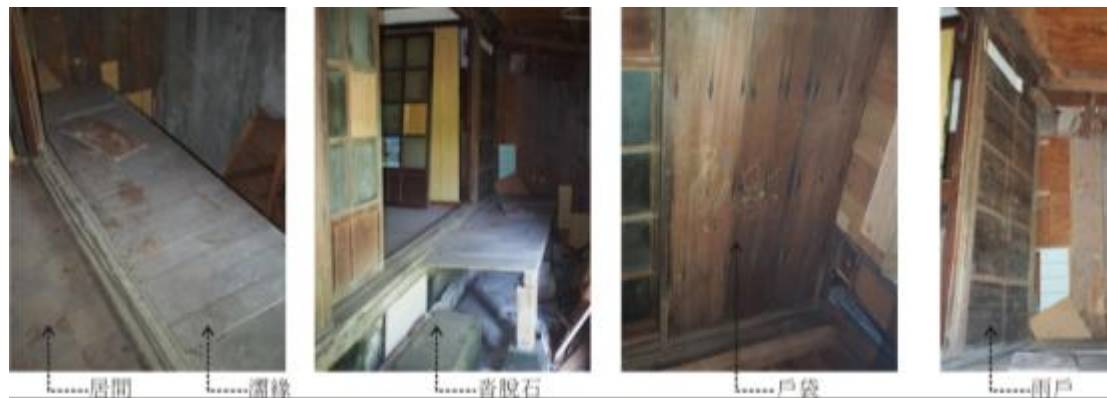
圖 3-2.30 A-1 棟建築物濡緣位置標示圖
