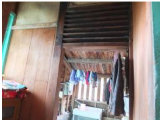
照片 4-2.91 D13 建具現況照片 1
