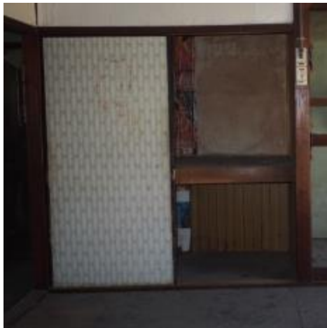
照片 4-2.19 D8 建具現況照片 3
