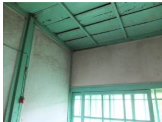
照片 4-1.24 B 幢真壁構造現況照片 1
