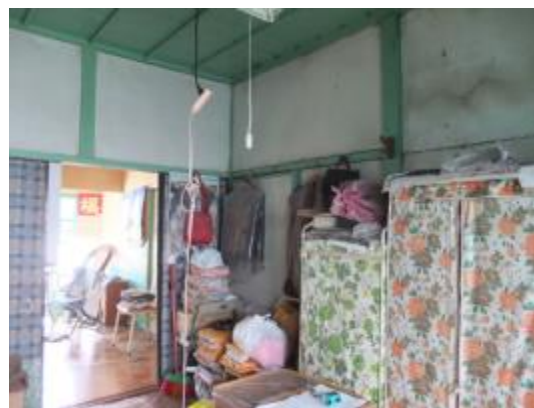
照片 4-1.25 B 幢真壁構造現況照片 2
