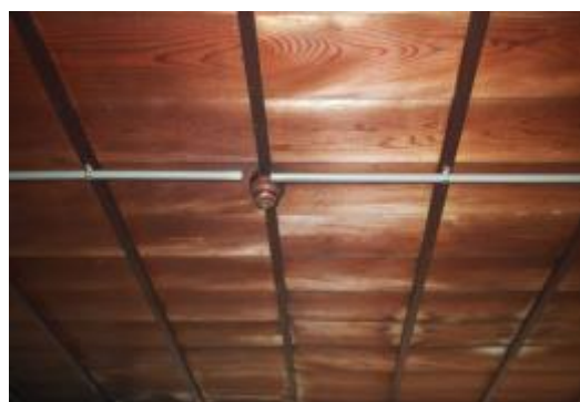
照片 4-2.50 A-1 棟建築物座敷天井現況照片
