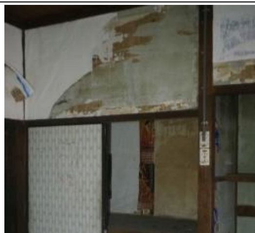
照片 4-3.10 空間 A-1-03 押入與床之間真壁構造
