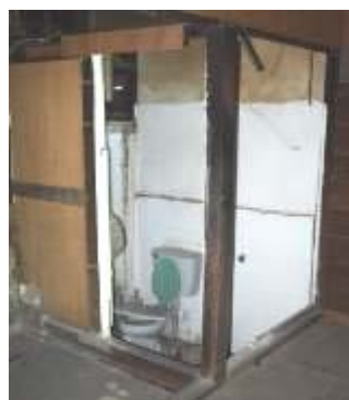
照片 4-2.24 D14 建具現況照片
