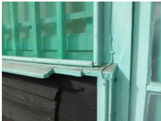
照片 4-2.114 W6 建具現況照片 5
