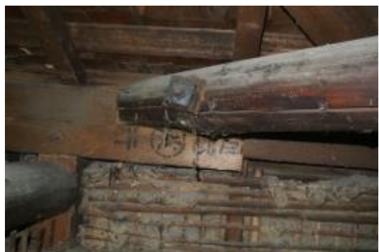
照片 4-3.34 軒桁 X4-3 蓮港 ㊦ 行墨字
