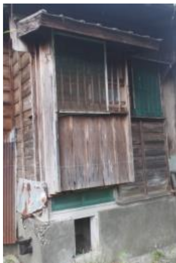
照片 4-2.30 W2、W3 建具現況照片
