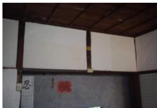
照片 4-2.6 D2 建具現況照片 2
