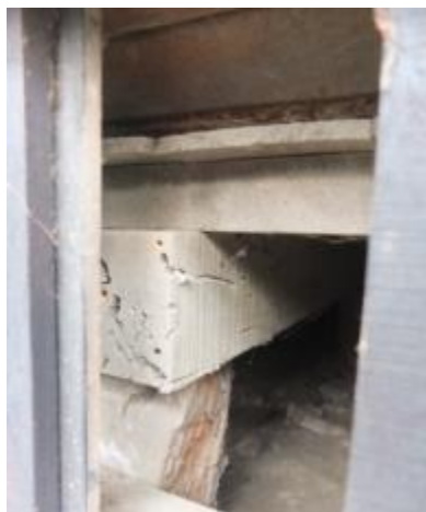
照片 4-1.22 B 幢建築物床組現況照片 1
