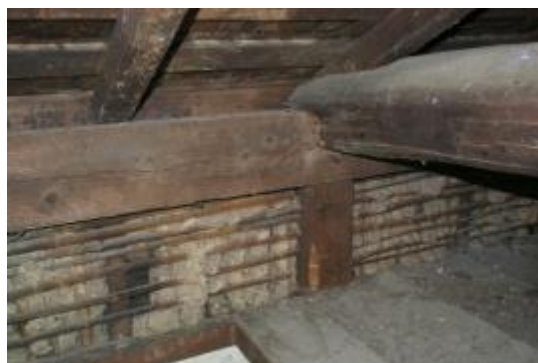
照片4-3.51 54號宿舍座敷空間押入墨字
