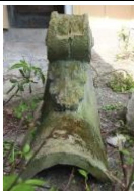
照片 4-3.20 隅水泥瓦背面
