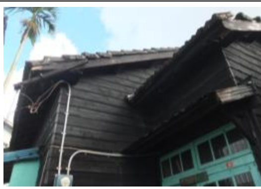
照片 4-3.76 B-2 棟外牆為雨林板
