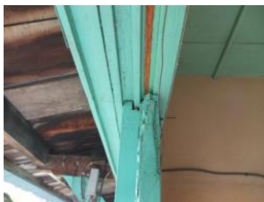
照片 4-2.84 D10 建具現況照片 3
