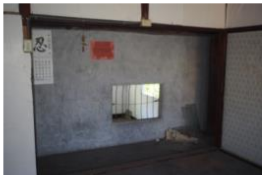
照片 4-2.5 D2 建具現況照片 1
