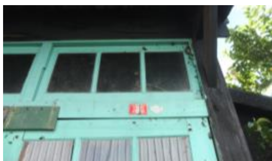
照片 4-2.59 D1 建具現況照片 1
