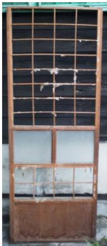
照片 4-2.88 D11 建具現況照片 2
