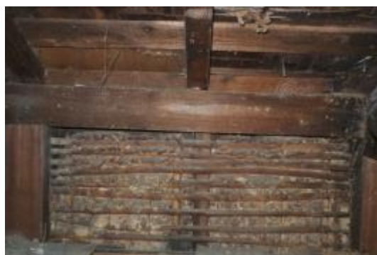
照片 4-1.12 A 幢真壁構造現況照片 2
