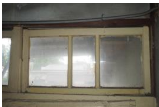
照片 4-2.3 D1 建具現況照片 1
