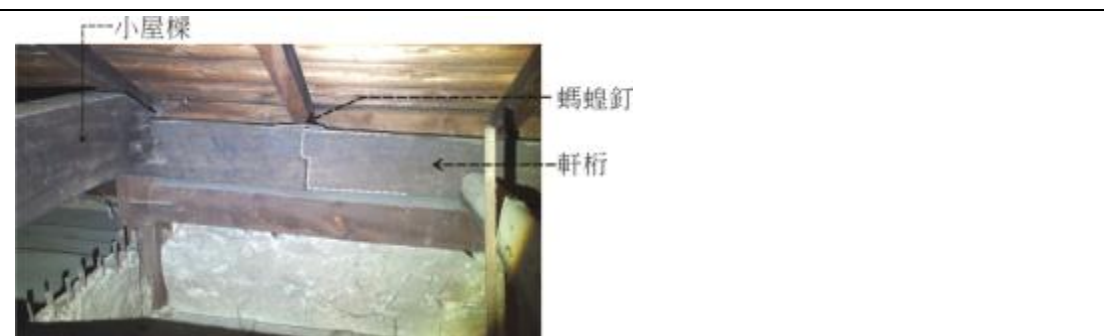
圖 4-4.14 B 幢建築物軒桁銜接工法標示圖
