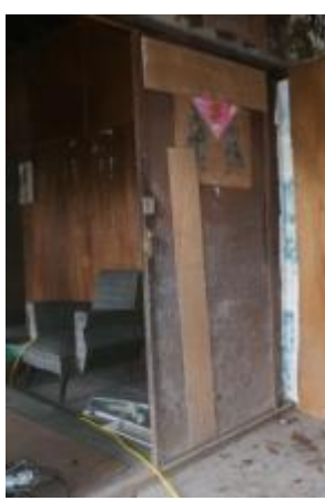
照片 4-2.12 D6 建具現況照片 2
