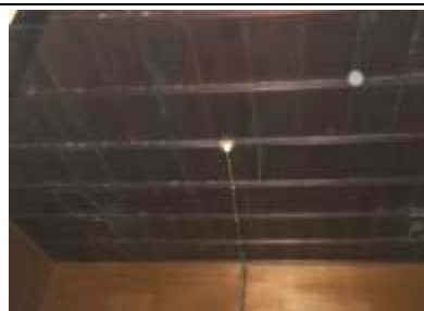
照片 4-2.53 A-2 棟建築物座敷天井現況照片
