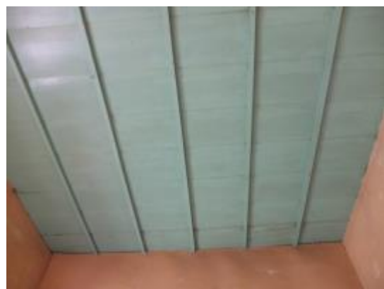
照片 4-2.119 B2 戶建築物座敷天井現況照片
