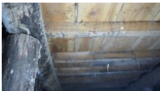
照片 4-1.9 A 幢建築物床組現況照片 3
