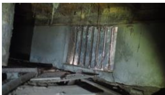
照片 4-1.5 A 幢建築物布基礎和通氣口現況照片
