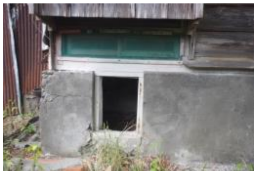
照片 4-2.31 W3 建具現況照片 1
