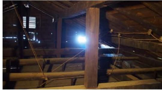
屋組 B3 架 雨淋板損壞佚失
