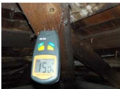
照片 5-1.3 以含水率計量測構件水分
