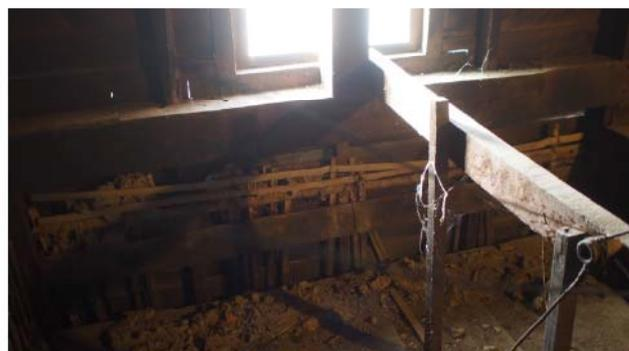
屋組 B3' 小屋樑下方壁土崩落
