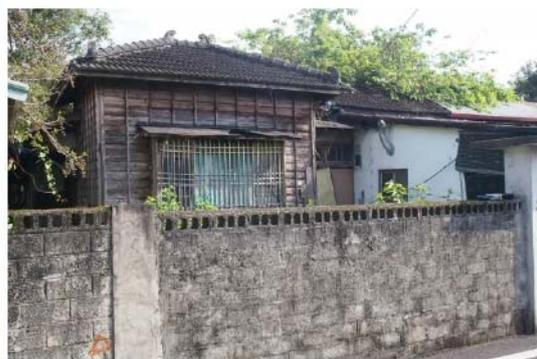
照片 5-2.10 立面屋瓦破損情形
