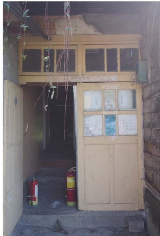
戶外門作上方壁土崩落修補痕跡
