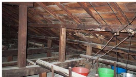
照片 5-1.26 B-1 棟-屋面及小屋束腐朽情形
