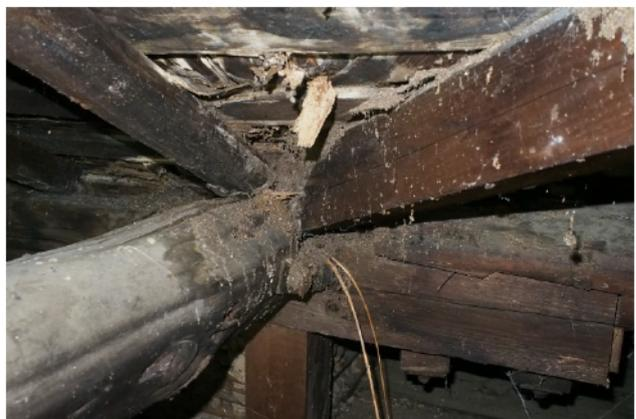
構件 Y7-1 與 X2-1 及 A9 小屋組搭接損壞
