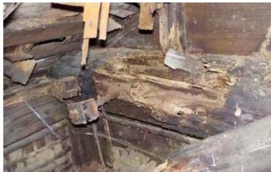
照片 5-1.10 軒桁處有白蟻副巢，構件已明顯空洞
