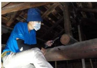
照片 5-1.1 目視現況調查以敲打法敲擊構件
