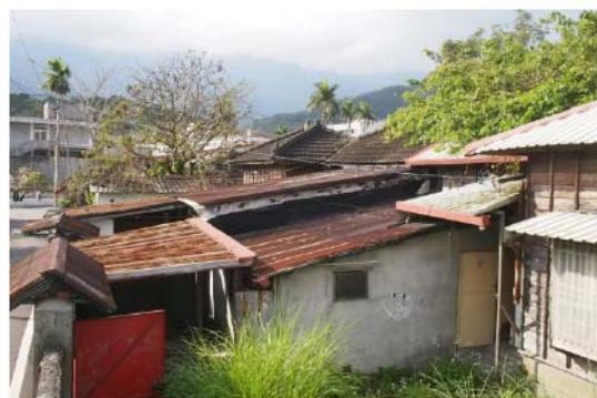
照片 5-2.11 左側立面屋瓦更換鐵皮
