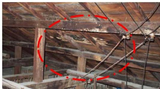
屋面腐朽破損可直接看到鐵皮浪板
