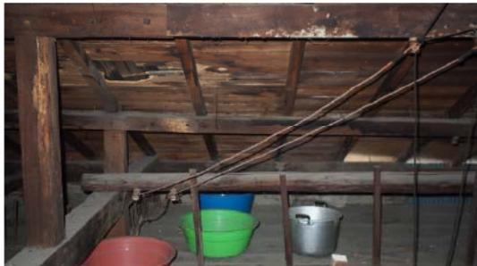
B1 屋組屋面板腐朽與擺設盛器
