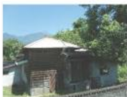
A棟建築物外觀現況照片
