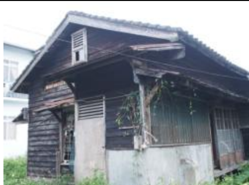
照片 6-2.16 中華路 139 巷 48 弄 13 號、19 號現況照片
