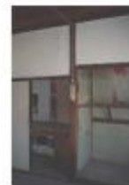
A-1座敷現況照片
