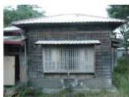
A棟建築物外觀現況照片
