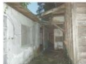
A-2便所現況照片
