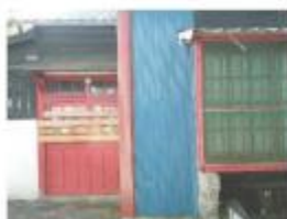
B棟建築物外觀現況照片
