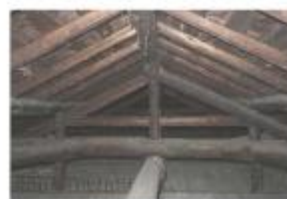
A棟建築物屋架現況照片
