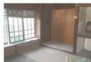
A-2座敷現況照片
