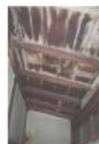
A-1緣側天井現況照片
