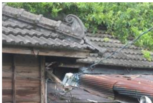
照片 6-3.4 A 軒先現況照片
