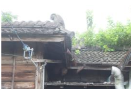
照片 6-3.19 屋檐樋現況照片
