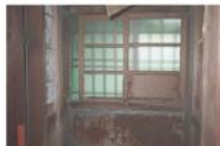
A-1便所現況照片
