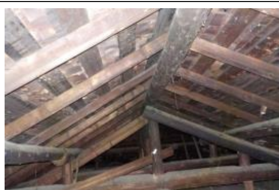
照片 6-3.7 檜板葺和小屋組現況
