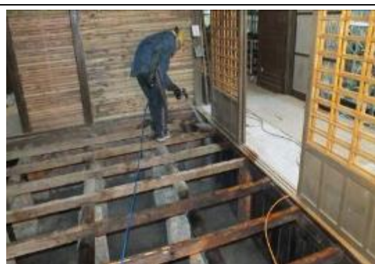
照片 6-3.22 現場舊木構件表面噴塗處理
