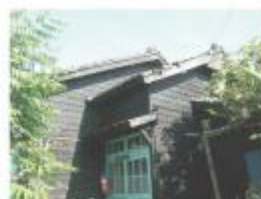
B棟建築物外觀現況照片
