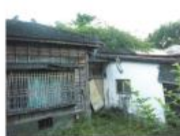
A棟建築物外觀現況照片
