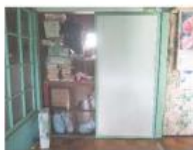
B-2踏進、玄關現況照片
