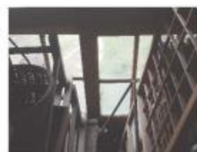
B-2踏進、玄關現況照片
