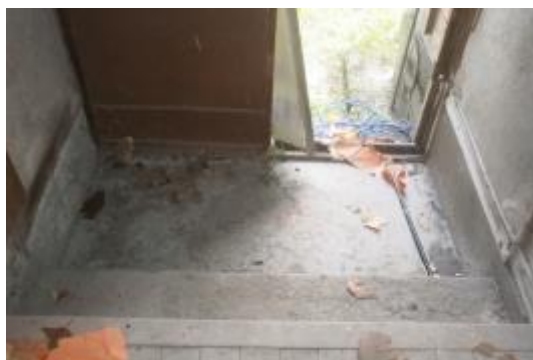
照片 6-3.17 水泥沙漿粉光地坪現況
