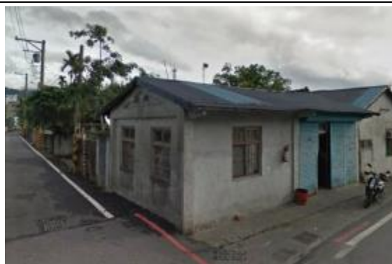
照片 6-2.19 磚木混合造房子現況照片
