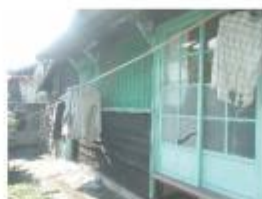
B棟建築物外觀現況照片
