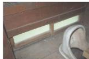
A-1便所現況照片
