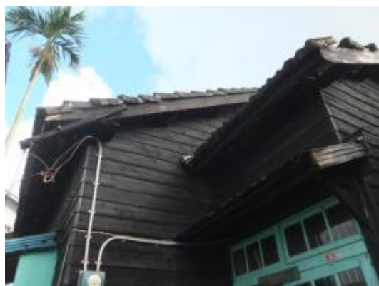
照片 6-3.6 軒先與破風現況照片
