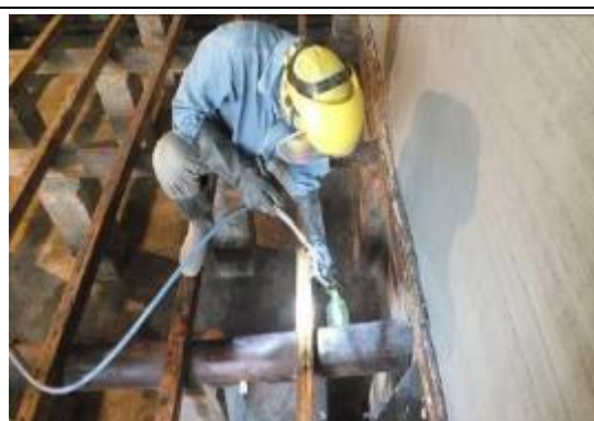
照片 6-3.23 現場舊木構件表面灌注處理
