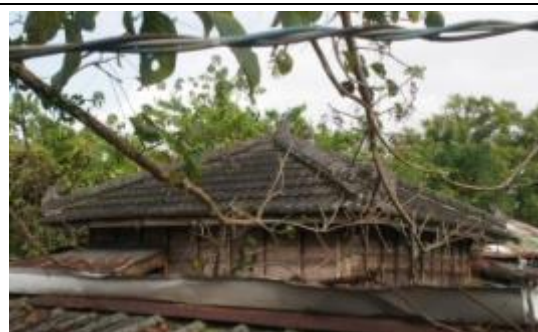
照片 6-3.1 A 幢屋根現況照片
