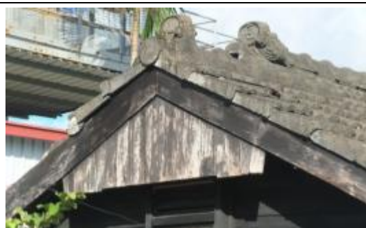
照片 6-3.2 B 幢屋根現況照片
