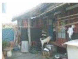
B棟建築物外觀現況照片
