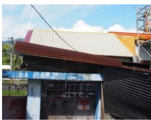
照片 6-2.18 中華路 139 巷 48 弄 3 號、5 號現況照片
