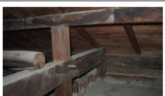
照片 6-3.9 屋架現況照片
