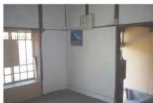
A-1座敷現況照片
