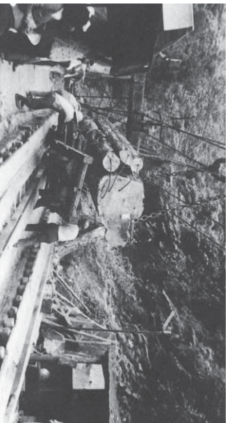
【圖 2-2-92】掘田式索道運下山之木材可直接銜接鐵道
