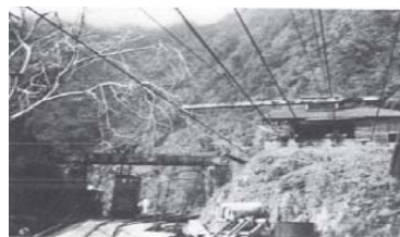
【圖 2-2-61】二號索道著點(右側建築為一號索道運轉室)
