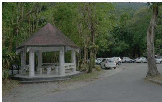
【照片 2-5-65】位置 1：原貯木場空間變更為開放停車場後缺乏管制
