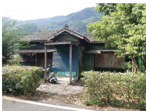
【照片 5-1-6】無人居住之日式宿舍入口以鐵板封閉
