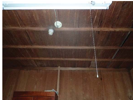
【照片 5-1-42】「居間」之日式「竿緣天井」
