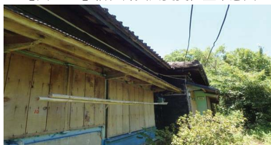
【照片 2-5-59】位置 1：屋頂變更為鋼浪板
