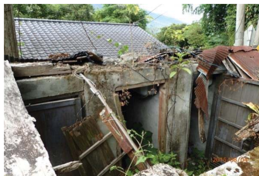
【照片 2-5-76】位置 3：修理工廠南方廢棄廁所
