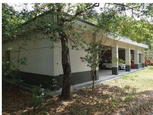
【照片 5-1-1】完成整修之機具展示館
