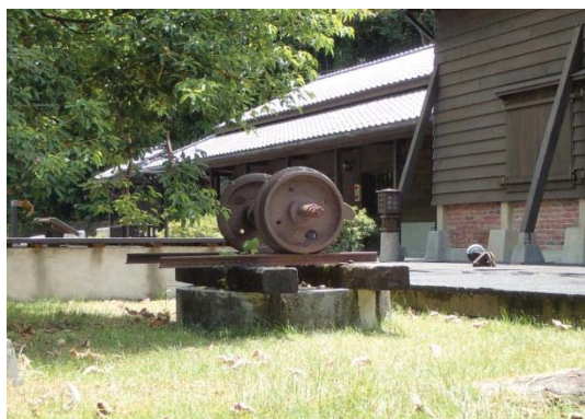
【照片 2-4-114】修理工廠前的鐵道與車輪
