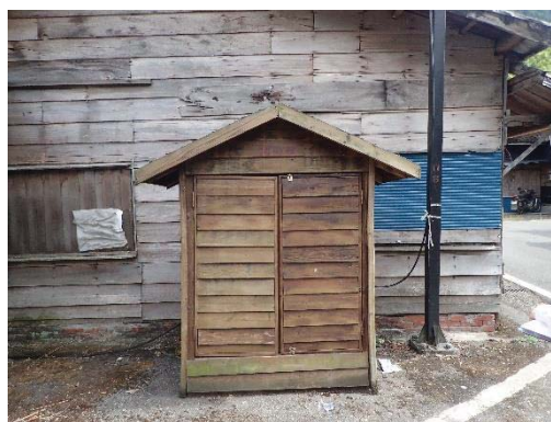
【照片 5-1-161】修景後的木製消防栓箱
