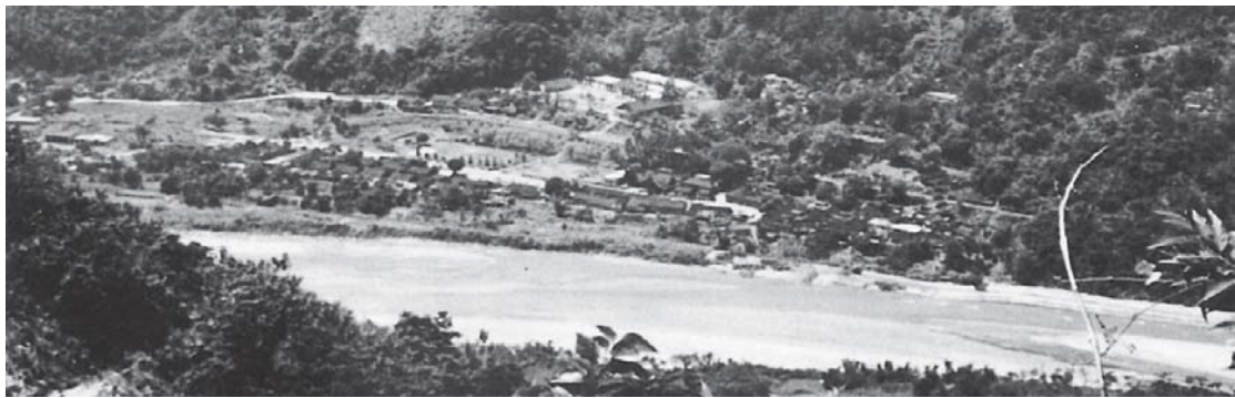
【照片 2-6-5】林業組織階層制度影響聚落配置之空間
