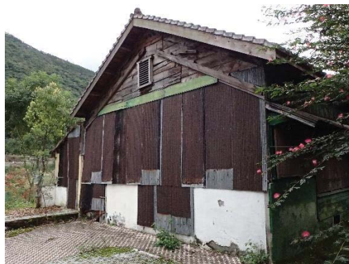
【照片 5-1-79】外立面鋪設鐵板
