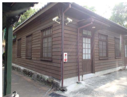
【照片 5-1-20】林場懷舊館設置火災警報器
