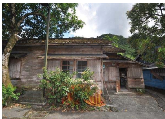
【照片 2-4-82】外牆鋪設雨淋板(林森路 91 號)
