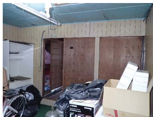
【照片 5-1-121】右側增建物室內
