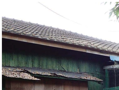
【照片 5-1-87】水泥瓦狀況良好
