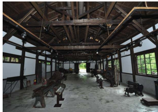
【照片 2-4-105】已整修之修理工廠室內
