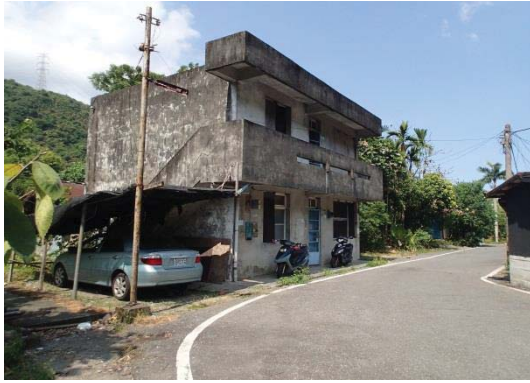
【照片 2-4-57】E 二層樓員工宿舍
