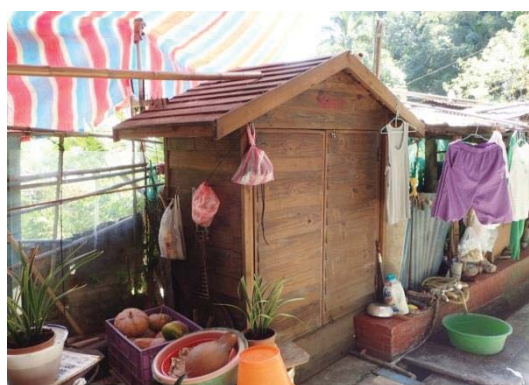
【照片 2-3-37】部分消防栓已變成放置私人物品的空間
