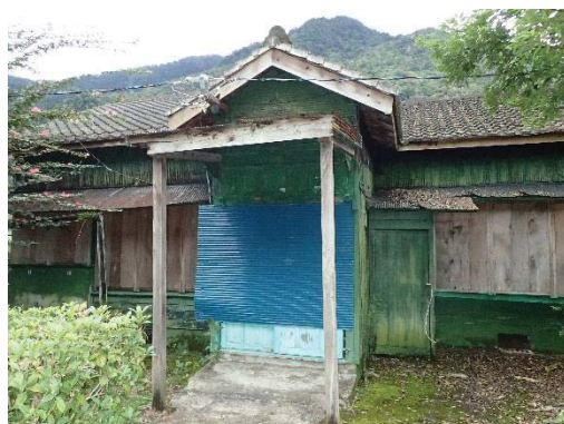
【照片 5-1-86】屋頂鋪設水泥瓦
