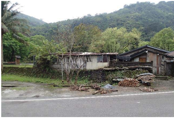
【照片 2-4-1】位置 A-萬里橋圳堤防
