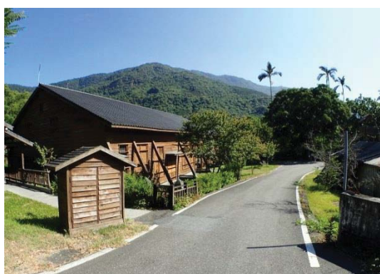
【照片 2-3-36】中山堂後方消防栓位置
