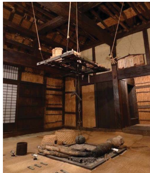
【圖 4-1-16】火爐正上方的懸吊隔板
