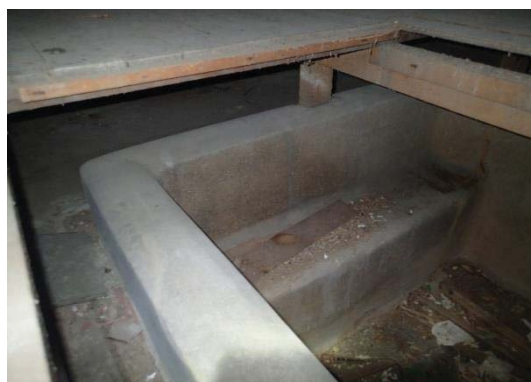
【照片 2-4-133】浴池內部還可看臺階
