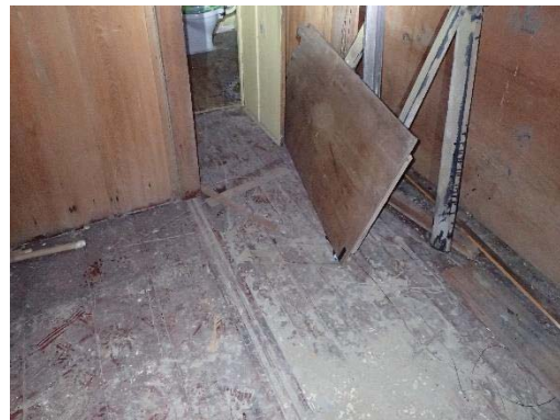
【照片 5-1-73】「緣側」維持原有抬高木地板
