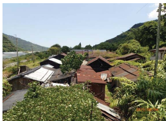
【照片 2-5-64】位置 6：多處屋頂改設鋼浪板
