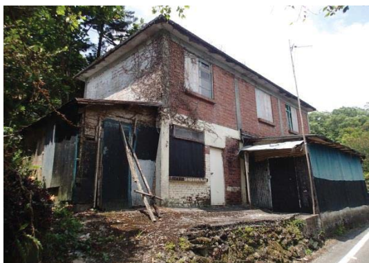
【照片 2-4-64】L 二層樓員工宿舍
