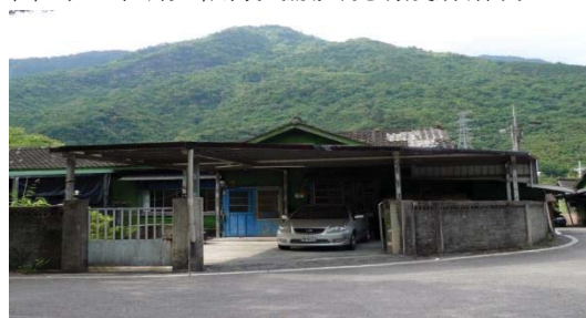
【照片 2-5-60】位置 2：搭建遮雨棚
