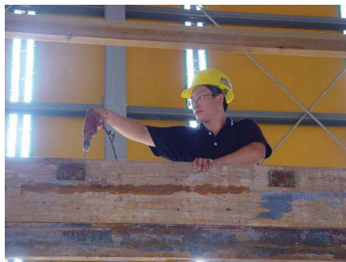
【照片 5-1-14】舊構件逆灌注藥劑處理
