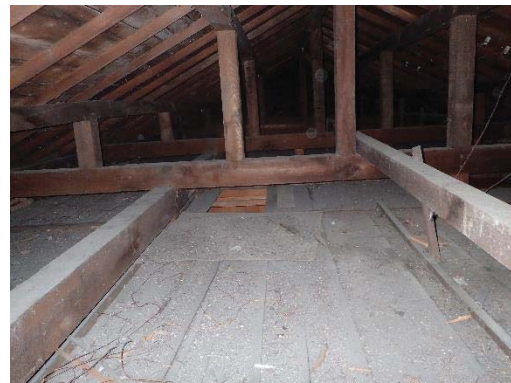
【照片 5-1-83】室內大部分仍保留原有天花（從屋架層拍攝）
