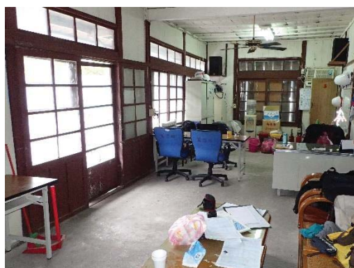
【照片 5-1-98】戰後初期增建的前側空間為水泥砂漿粉光地坪
