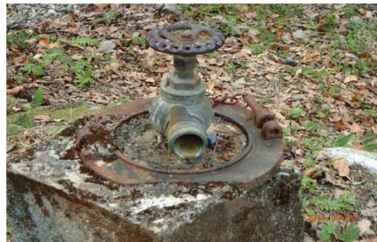
【照片 2-4-127】樹林小徑旁的舊有出水口
