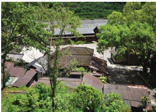
【照片 2-4-47】I 舊有鐵道步道，海拔約為 180 公尺
