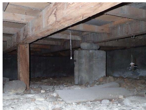
【照片 5-1-65】混凝土獨立基礎上方加設卵石
