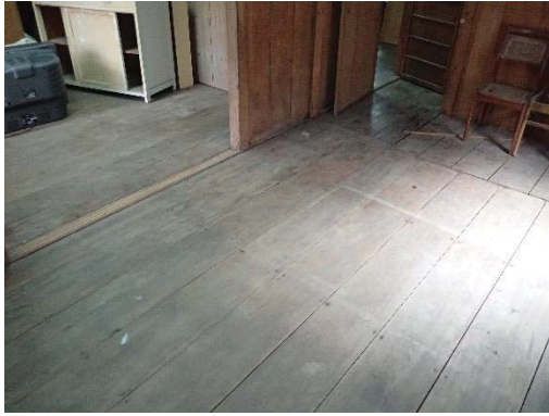
【照片 5-1-100】日治時期範圍的空間，推測原本為水泥砂漿粉光地坪，但目前設置抬高木地板
