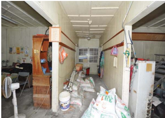
【照片 2-4-100】木板牆隔間
