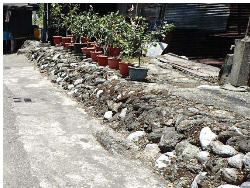
【照片 5-1-162】原有萬里橋圳堤防
