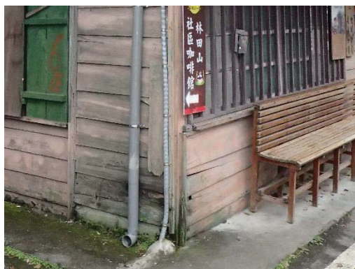
【照片 5-1-96】戰後初期增建的前側空間設置高度較低的基礎
