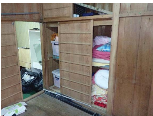
【照片 5-1-108】室內原有木板門
