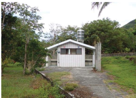
【照片 2-5-35】位置 21：入口處前方廁所
