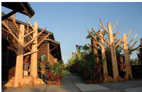
【照片 4-1-4】原貯木工人宿舍：現在僅少部分仍作為宿舍，大部分被再利用做為藝文使用
