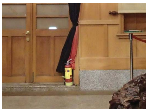
【照片 5-1-19】中山堂內放置滅火器
