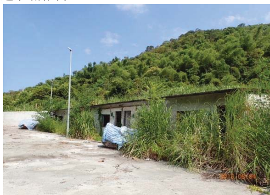
【照片 2-5-86】位置 10：貯木場連棟宿舍，門窗缺失
