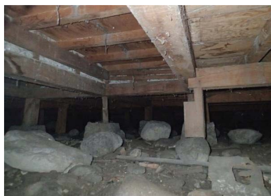
【照片 2-4-81】抬高木地板構造；以木柱及「束石」支撐(林森路 91 號)
