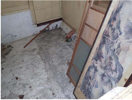
【照片 5-1-62】室內主要構件因增建而拆除
