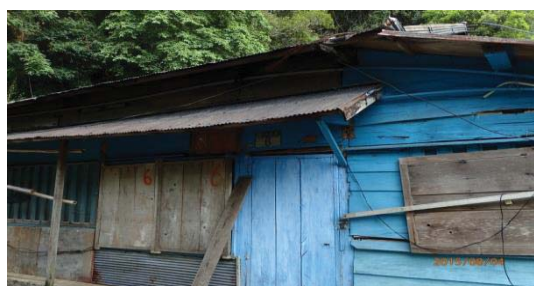
【照片 2-5-61】位置 3：加裝鋼浪板雨遮
