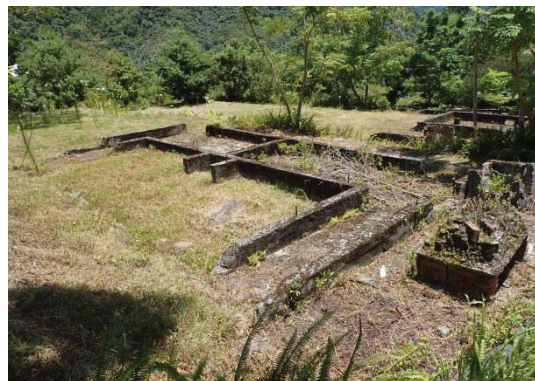
【照片 2-4-48】J 康樂新村殘構，海拔約為 200 公尺
