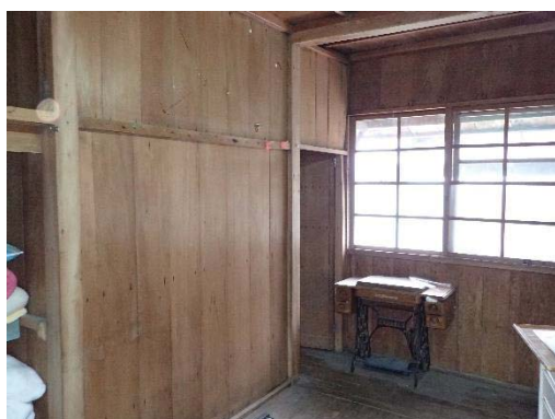
【照片 5-1-106】原有木板內牆
