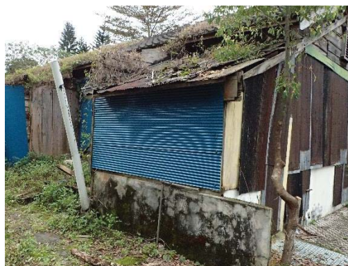
【照片 5-1-91】後側增建物現況
