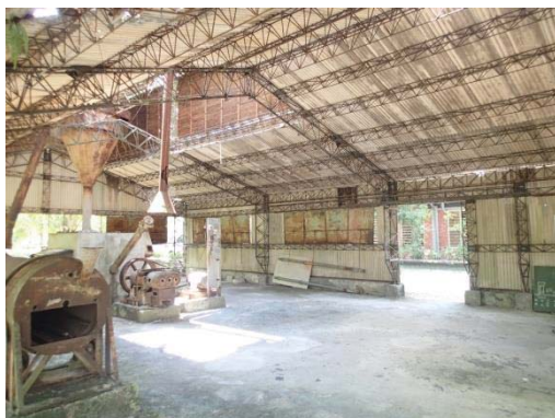
【照片 2-4-65】鋼構造建築(原子礫工廠)
