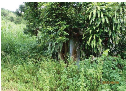
【照片 2-5-33】位置 19：貯木場旁閒置三棟建物，已被植物覆蓋
