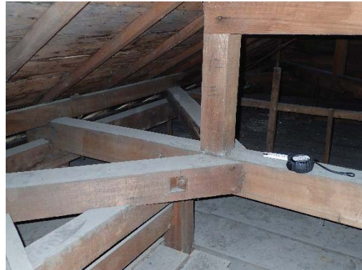
【照片 5-1-93】遭截斷的柱子在屋架仍可看見（由屋架拍攝）
