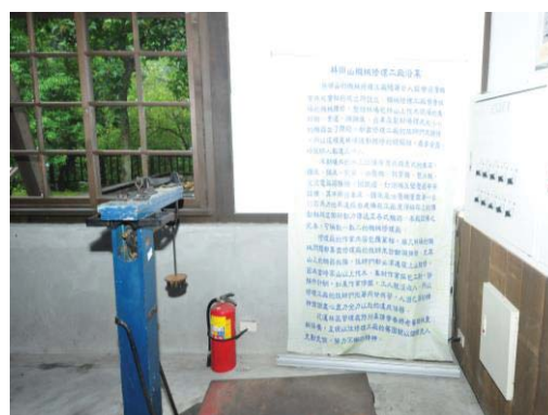
【照片 5-1-22】修理工廠內放置滅火器
