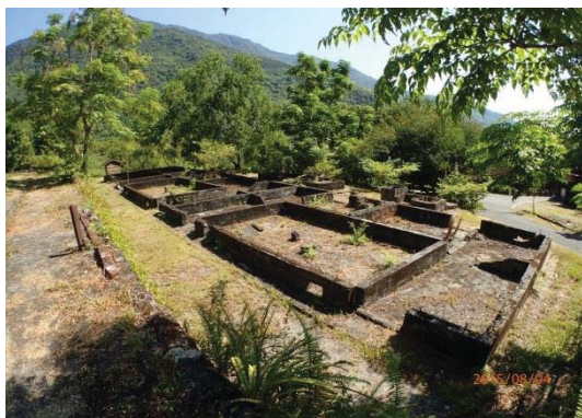
【照片 2-4-94】康樂新村現況
