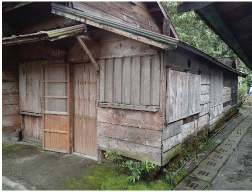
【照片 5-1-55】左側增建之木造建築
