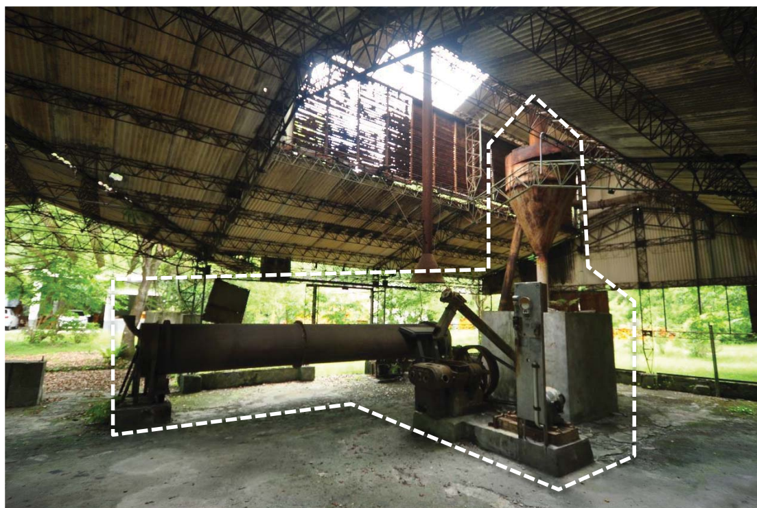
【照片 2-5-37】位置 1：原子碳工廠裡機具閒置擺放著
