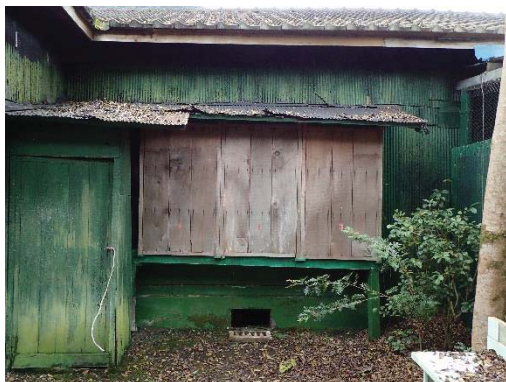
【照片 5-1-78】外立面鋪設鐵板
