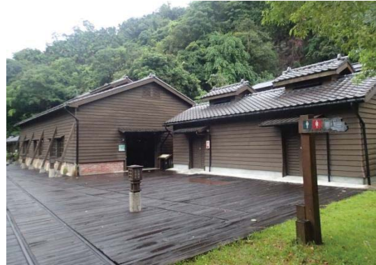
【照片 2-4-103】已整修之修理工廠外觀
