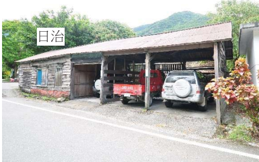
【照片 5-1-126】建築整體外觀，左側為戰後增建，右側為日治時期興建
