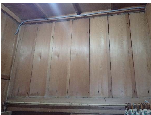
【照片 5-1-37】原有木摺泥牆之白灰粉刷拆除改設木板牆
