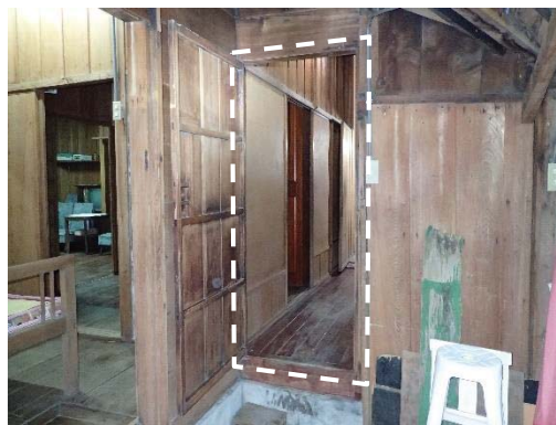
【照片 5-1-36】原有外牆因後期增建而拆除
