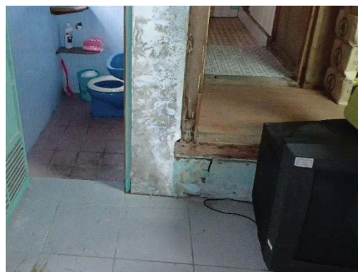
【照片 5-1-97】日治時期範圍設置較高的基礎
