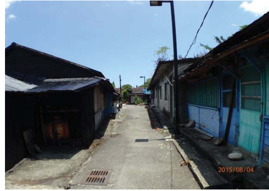
【照片 2-5-6】位置 6：河邊員工宿舍，建築物老舊
