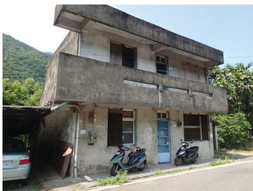
【照片 2-4-67】RC 造建築(宿舍)
