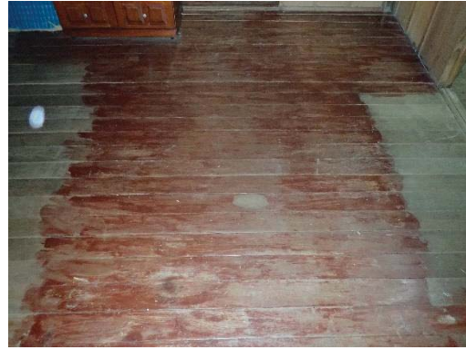
【照片 5-1-32】「居間」榻榻米拆除改鋪木地板
