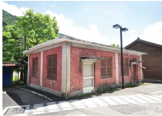
【照片 2-4-78】戰後興建之加強磚造建築
