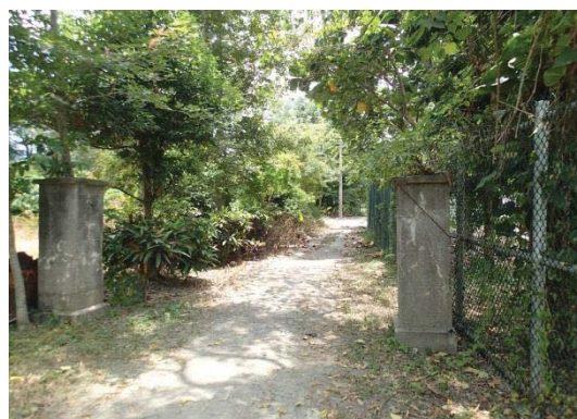
【照片 2-6-8】林場火車出入口兩側門柱仍保存良好。
