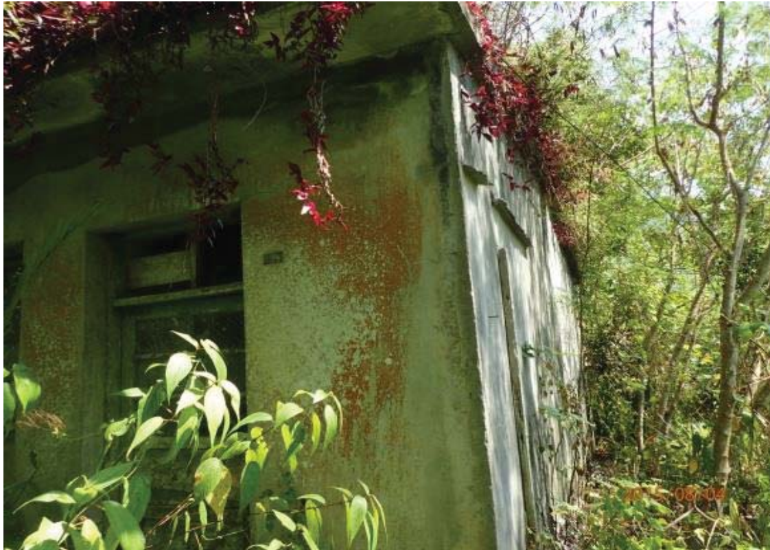
【照片 2-5-16】位置 2：康樂新村旁水泥造的員工宿舍閒置
