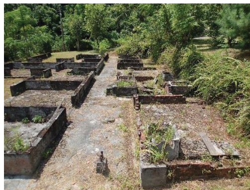
【照片 5-1-139】僅存的建築基礎
