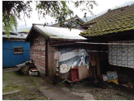
【照片 5-1-56】後側增建之木造建築
