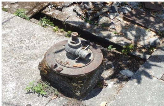
【照片 2-4-126】林森路旁的舊有出水口
