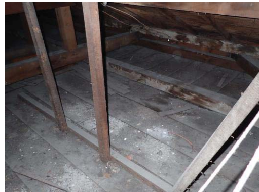
【照片 5-1-111】室內仍保存原有天花（從屋架層拍攝）
