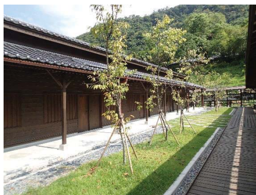
【照片 5-1-4】完成整修之林場生活館
