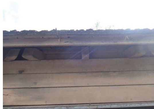
【照片 2-4-101】屋架設置「火打樑」補強
