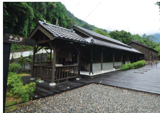
【照片 2-4-107】已整修之木工室
