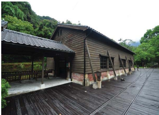
【照片 2-4-104】已整修之修理工廠外觀
