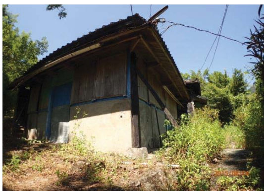
【照片 2-5-25】位置 11：役男宿舍後面的木造建物閒置
