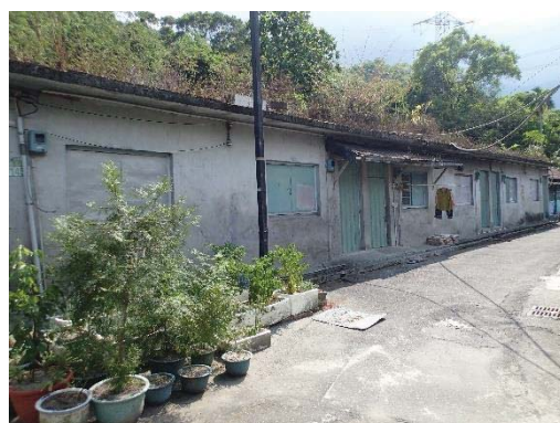
【照片 5-1-165】緩衝區的磚造建築
