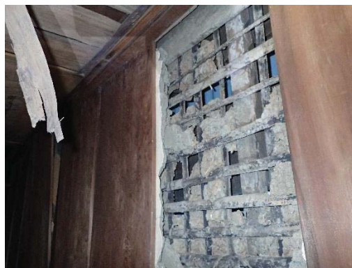
【照片 5-1-75】原有編竹夾泥牆外再鋪貼一層檜木板
