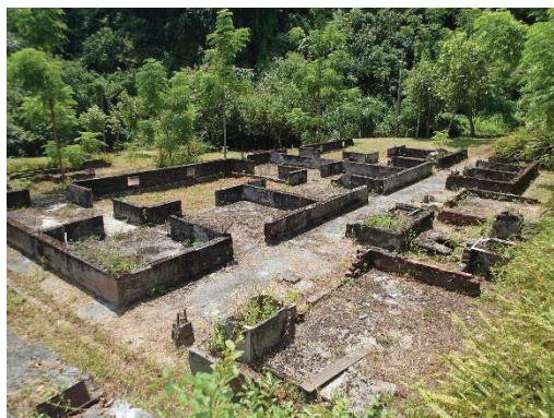
【照片 5-1-138】僅存的建築基礎
