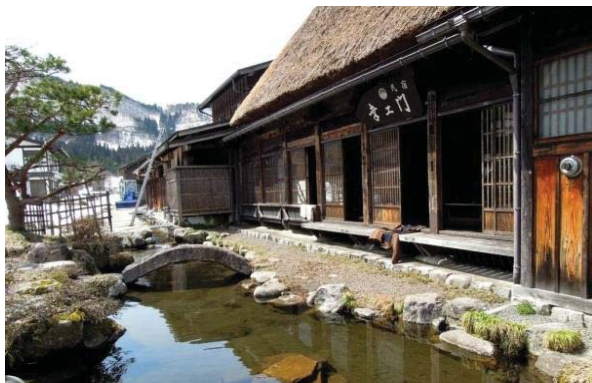
【圖 4-1-24】建築物旁的水溝
