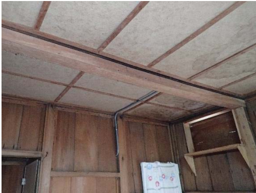
【照片 5-1-92】室內柱子遭到截斷（由室內拍攝）
