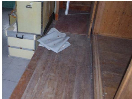
【照片 5-1-103】日治時期範圍的「緣側」設置抬高木地板
