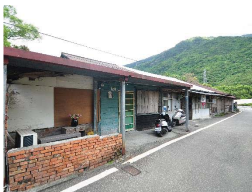
【照片 5-1-123】第二棟基層員工宿舍正面
