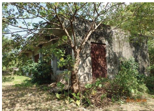
【照片 2-5-32】位置 18：林安路旁廠房閒置
