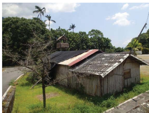
【照片 2-4-70】竹造建築
