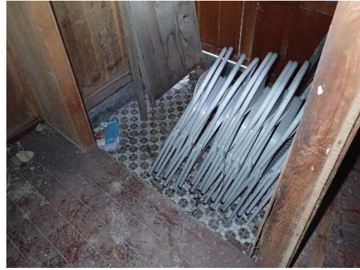
【照片 5-1-71】入口「踏込」地坪鋪設拼花地磚
