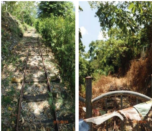
【照片 2-5-49】位置 7：鐵道殘跡的禁止參觀區域，缺乏維護
