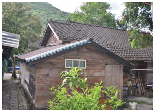
【照片 2-4-89】屋面鋪設水泥瓦(林森路 91 號)
