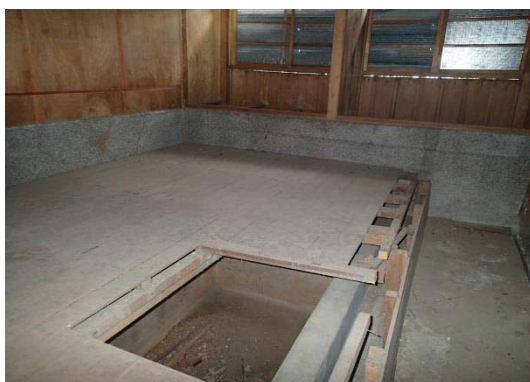
【照片 2-4-132】地板下方為浴池
