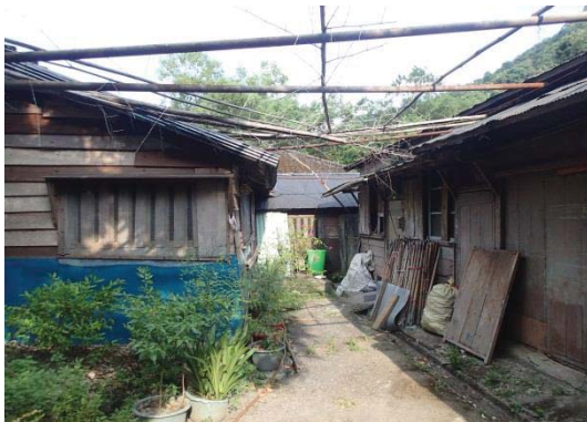
【照片 2-4-61】I 一層樓員工宿舍
