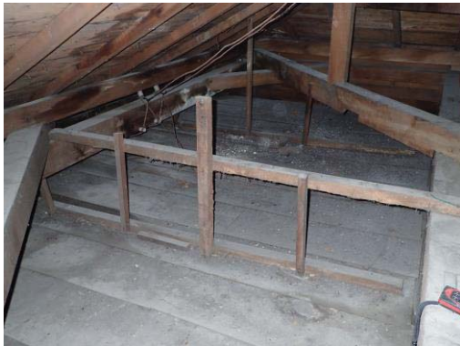
【照片 5-1-110】室內仍保存原有天花（從屋架層拍攝）
