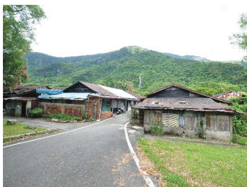
【照片 5-1-122】第一、二棟之基層員工宿舍
