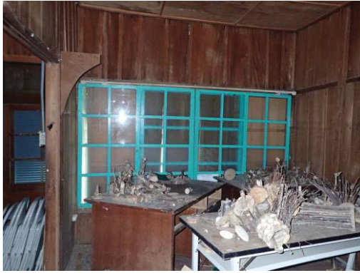
【照片 5-1-80】四扇一組的日式玻璃推拉窗
