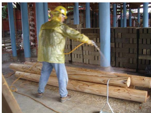
【照片 5-1-13】舊構件表面噴塗藥劑處理
