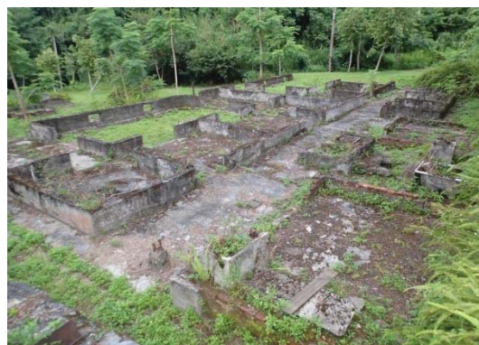
【照片 2-4-95】康樂新村現況
