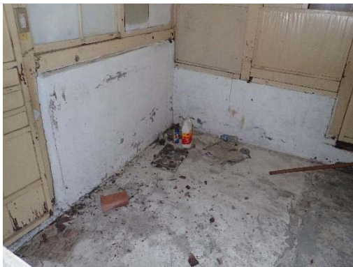
【照片 5-1-72】浴室維持沒有抬高的水泥砂漿粉光地坪
