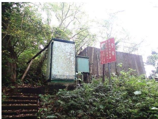
【照片 2-6-9】坐落於萬榮鄉萬利段 1208 地號的消防水池。
