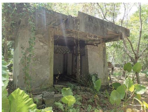
【照片 5-1-144】鄰近機具展示館的廁所
