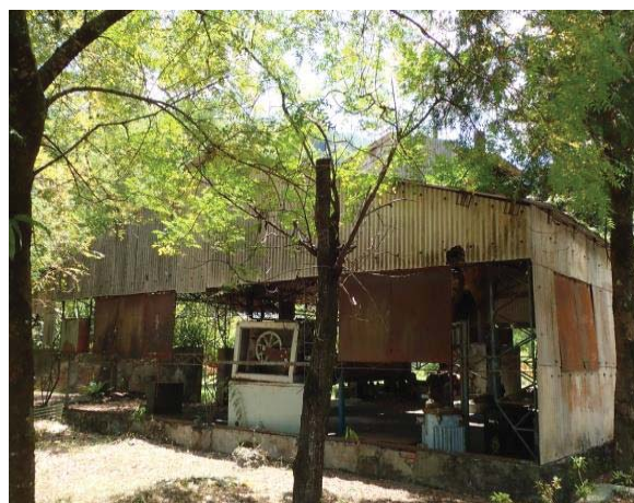
【照片 2-5-71】位置 1：原子碳工廠現況，空間仍然保有生產機具，但缺乏管理及維護
