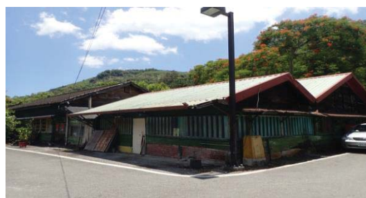
【照片 2-5-62】位置 4：屋頂變更為鋼浪板
