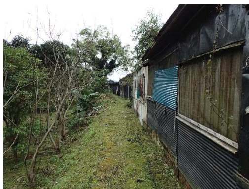
【照片 5-1-61】宿舍緊鄰河岸堤防
