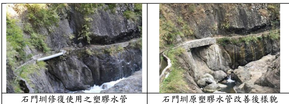
圖 2-21 石門圳以傳統工法進行修整之案例
