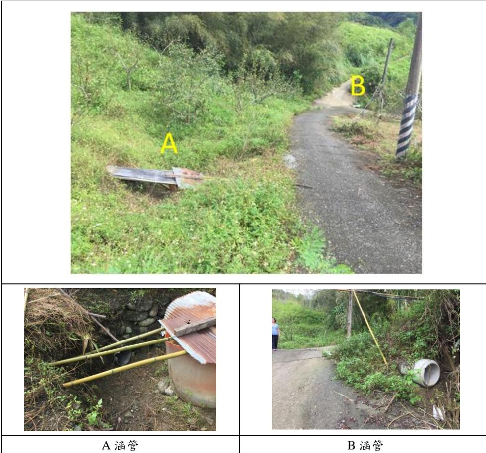
圖 3-12 通往宋啟源先生梯田之下坡水泥路 2 處集水涵管
