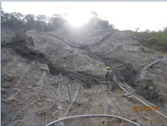
圖 3-29 菱形鋪網噴植配合格樑框錨定方式施工情形
