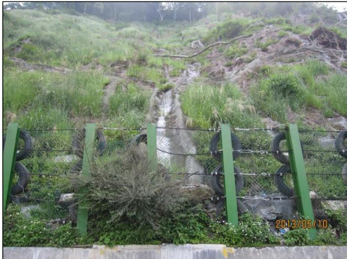
圖 3-30 菱形鋪網噴植配合格樑框錨定方式完工復育情形(含鋼柱輪胎之落石防止工)
